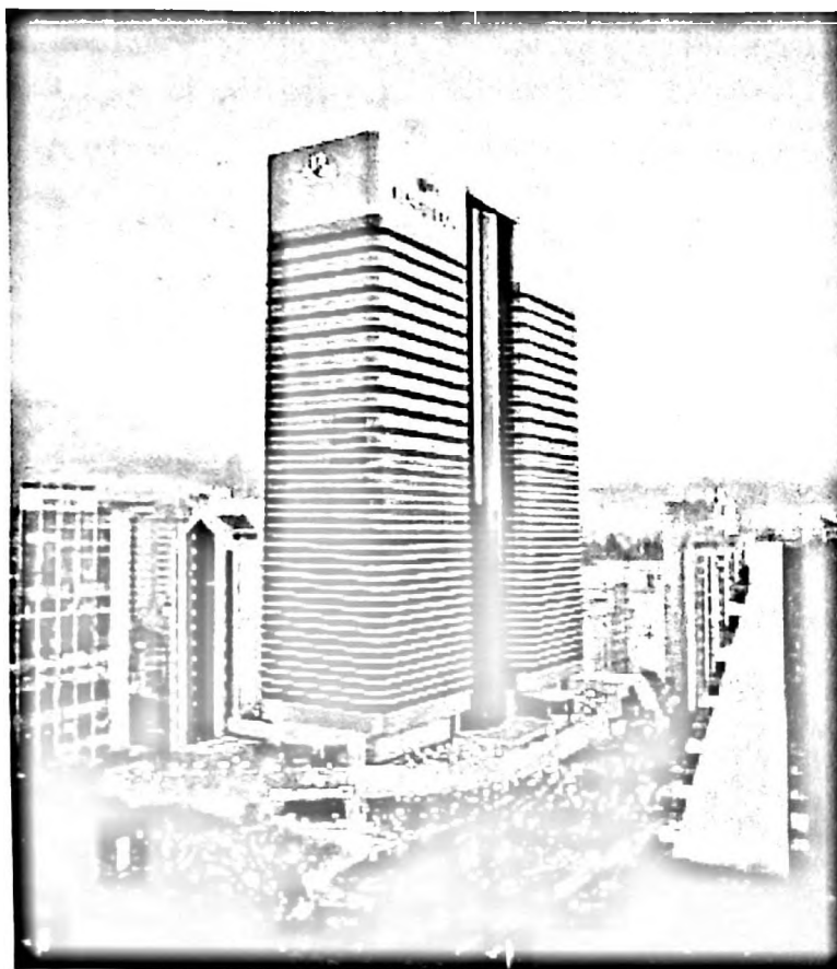
Figura 26 – Vista externa do hotel
