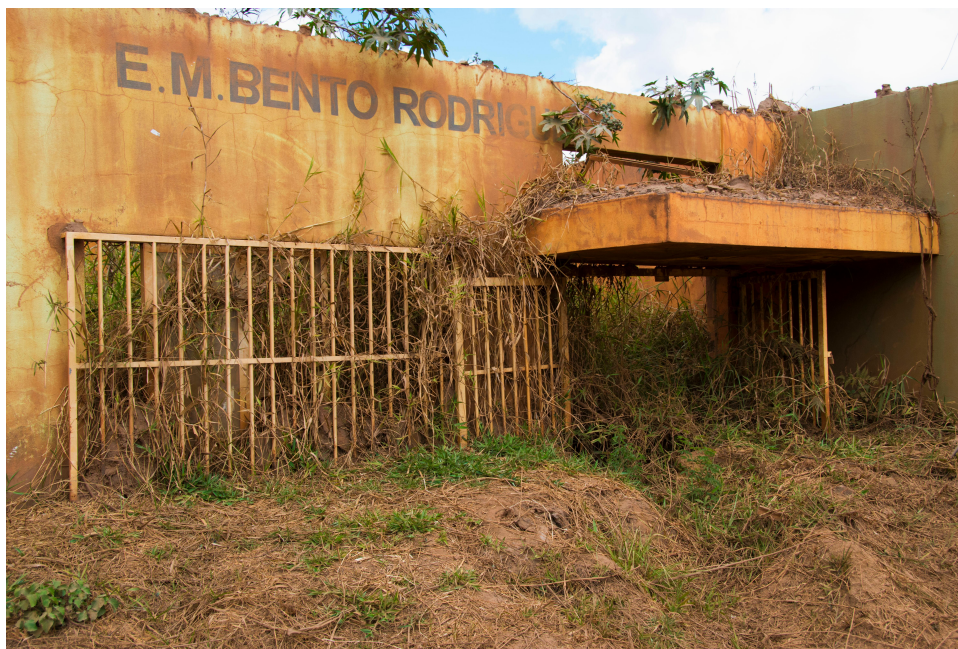
Figura 17 – Escola Municipal de Bento Rodrigues, subdistrito de Mariana (MG), após o desastre
