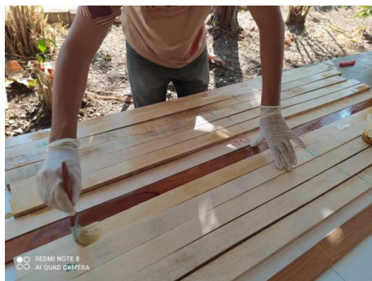
Figura 11. Aplicação do adesivo nas faces das madeiras
