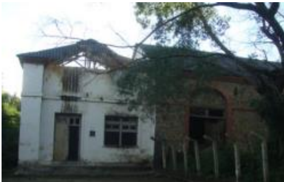
FIGURA 26: Vista Continuação Galpão 1 – (Setor 3)
