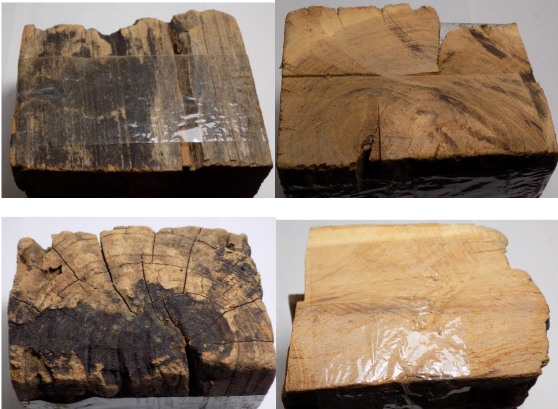
FIGURAS 32: Amostra 02: Tesoura – Estrutura dos telhados
