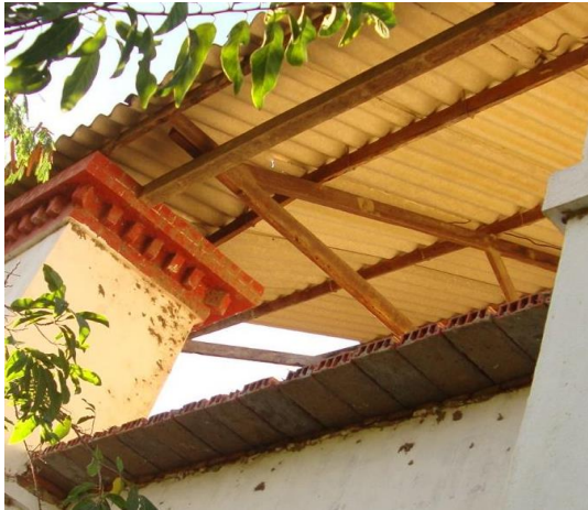
FIGURA 37: Detalhe do apoio de Tesoura sobre Frechal – Setor 3.
