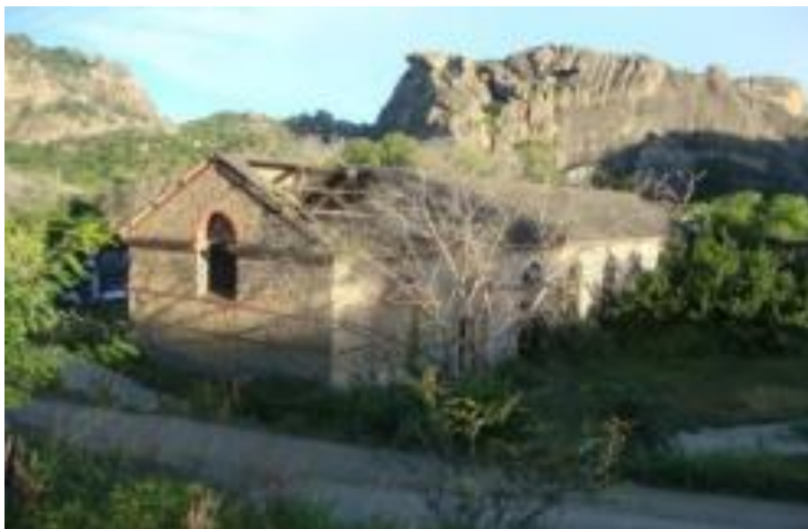
FIGURA 25: Vista Galpão 1 – (Setor 1)
