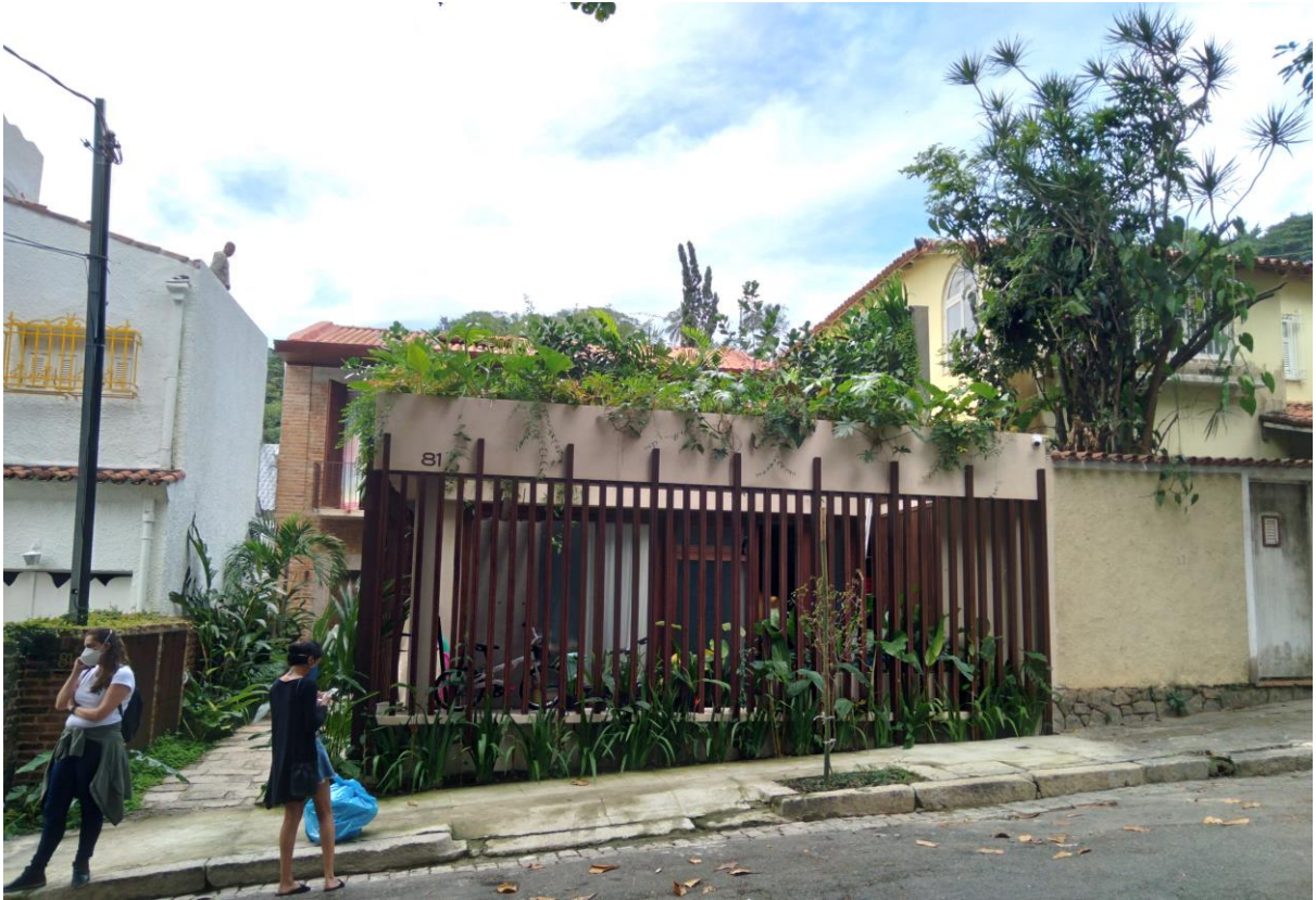
Figura 30. Vista geral da área 2. Fonte: Acervo da autora.
