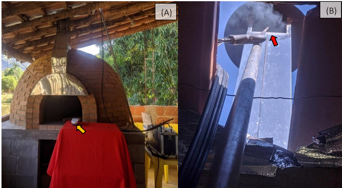
Figura 7. (A) Fotografia do forno com o analisador de gases portátil posicionado próximo à porta (seta laranja); (B) Estrutura da chaminé e o analisador móvel posicionado ao lado com os tubos de coleta indo até a chaminé na área externa (seta vermelha)
