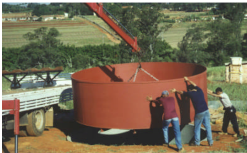
Figura 6 - Momento da instalação do lisímetro 4 em campo.
