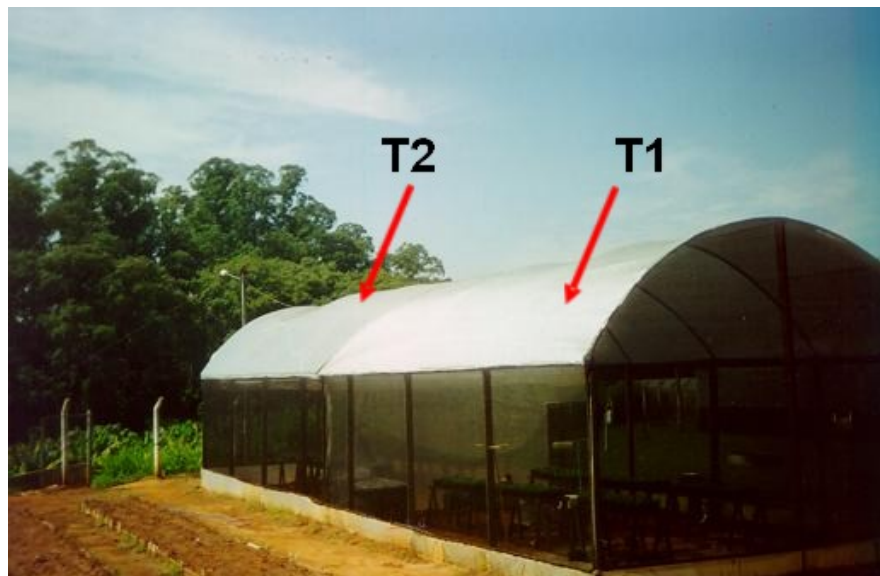
Figura 8 - Vista externa dos tratamentos adotados no presente estudo: Ambiente 1 (T1) - termo-refletores externa; Ambiente 2 (T2) - termo-refletores interna (dentro do ambiente protegido). Piracicaba, SP, 2004
