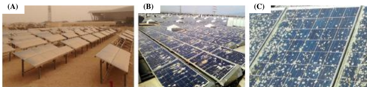
Figura 2.8 – Tipos de contaminantes em módulos fotovoltaicos (A) Poeira, (B) Dejetos de animais e (C) algas e líquens
