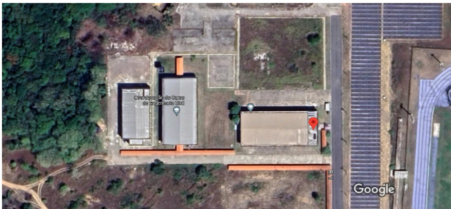
Figura 3.2 – Vista aérea do terraço do bloco da Coordenação do Curso de Engenharia Elétrica da UNIFAP.
