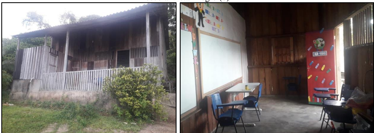
Figura 14 - Fachada da Escola Municipal de Ensino Fundamental Vista Alegre (a). Sala de aula da escola Vista Alegre (b)
