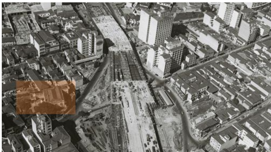
Figura 15 – Destaque n'á área da Casa de Dona Yayá feito na fotografia do Viaduto Júlio de Mesquita Filho.
