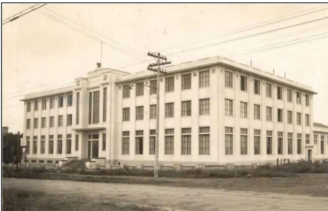
Figura 26 – O edifício em construção para abrigar a coleção zoológica do Museu Paulista, 1940. Fundo Museu Paulista – FMP. (MUSEU PAULISTA, s.d.)
