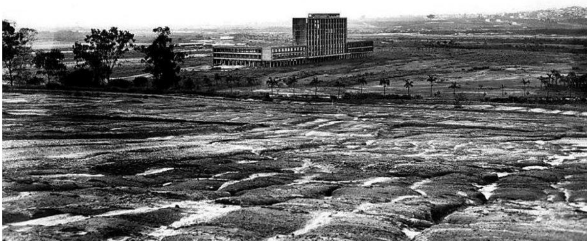
Figura 16 – Cidade Universitária da USP, início da década de 1950. Ao fundo, o edifício da Reitoria cercado pela área na qual se configurou a Praça dos Bancos, a Escola de Comunicações e Artes – ECA USP, a Praça do Relógio e a Av. Prof. Luciano Gualberto e a FFLCH USP. (HISTÓRIA DA CUASO, 1985).
