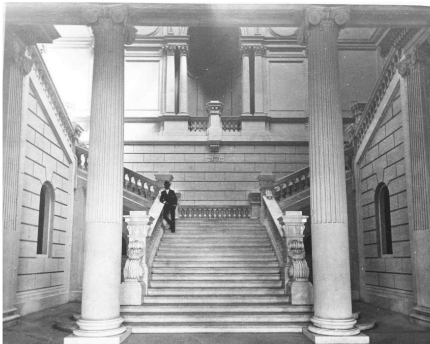
FIGURA 03: Interior do edifício-monumento – Bezzi na escadaria central (IC 1306) – Fotografia
