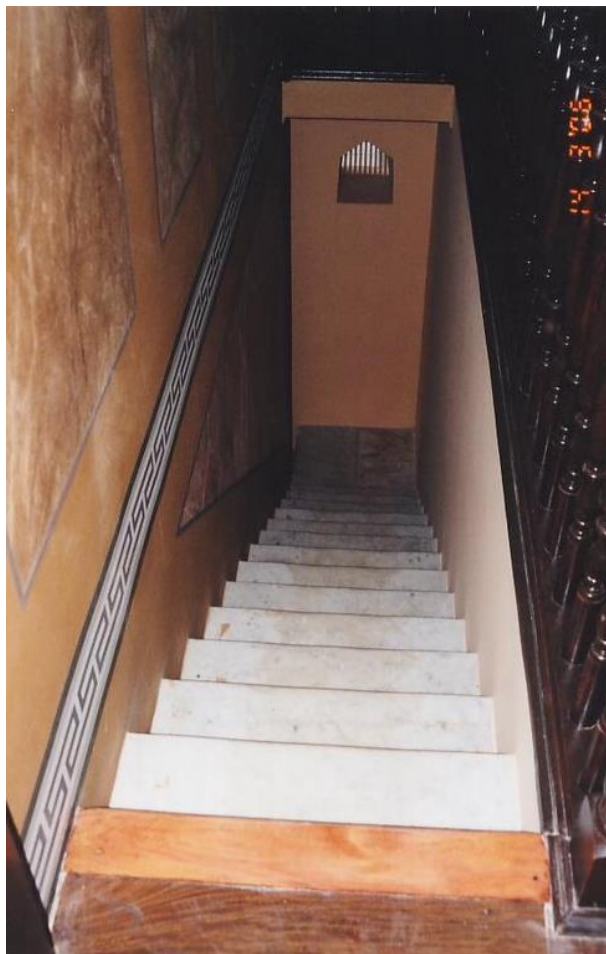
Figura 93: Escada de acesso ao porão
