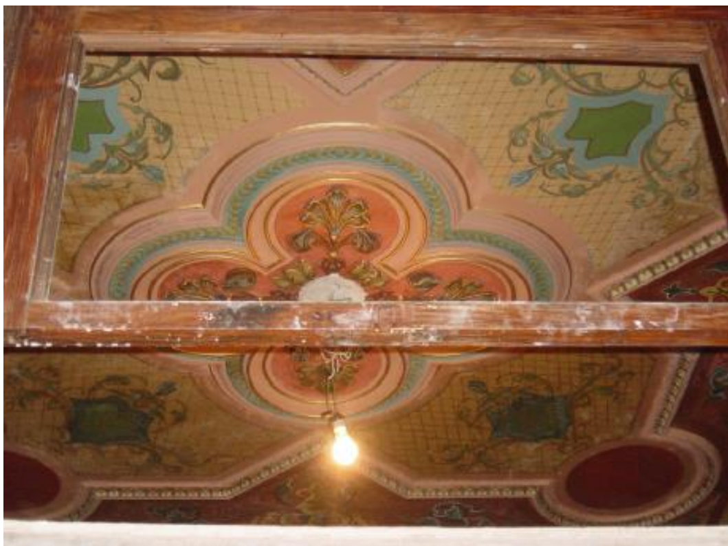
Figura 58: Detalhes do forro (1)
