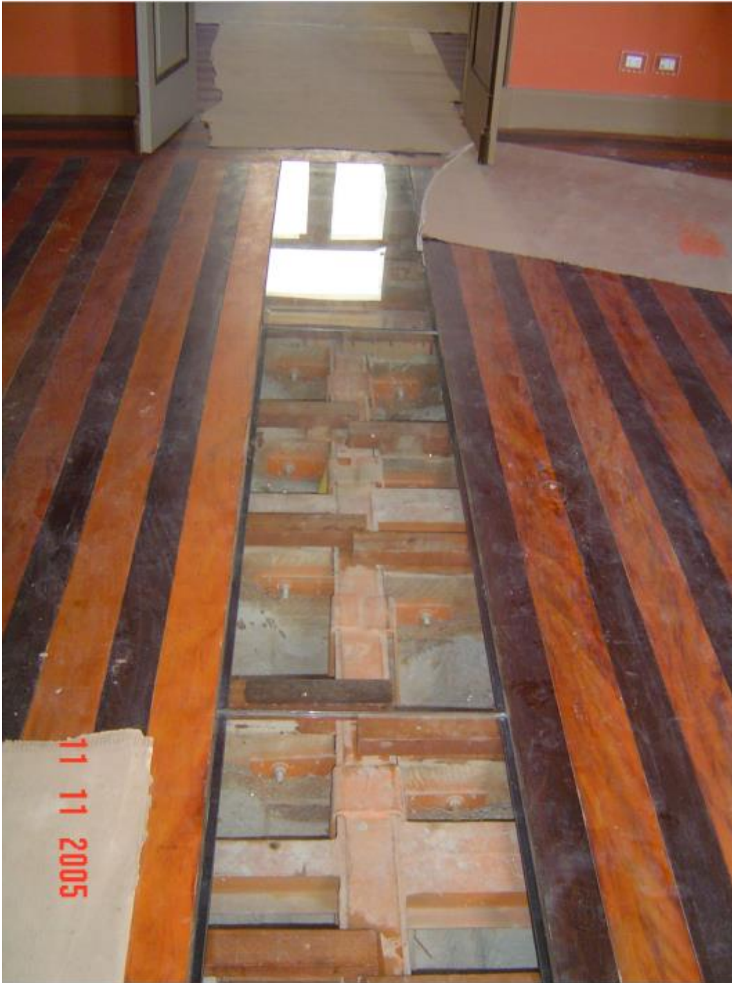
Figura 50: Tampo de vidro do piso do pavimento superior
