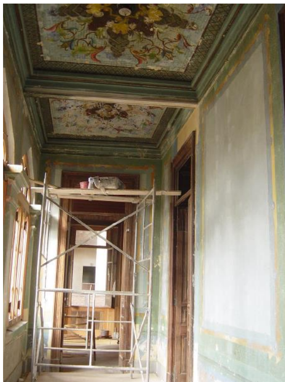
Figura 55: Andaime para acesso ao forro do corredor
