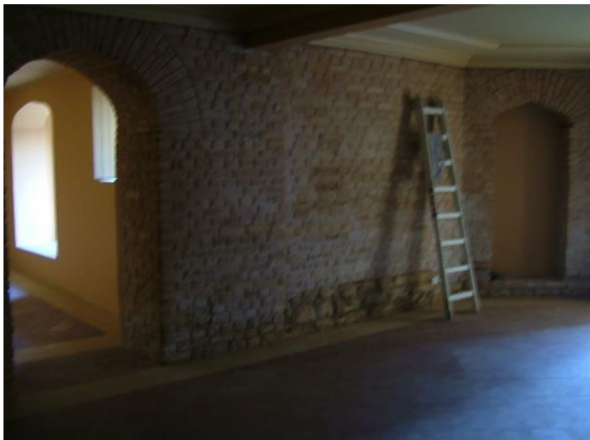
Figura 99: Subsolo – Ateliê, Corredor de acesso ao ateliê e arquivo do ateliê, conforme denominação da época da ocupação
