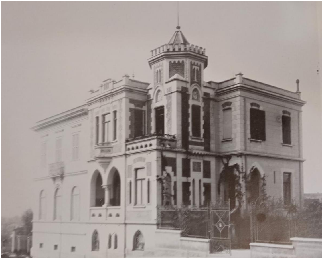
Figura 19: Residência de Manoel Pessoa de Siqueira Campos, São Paulo, projeto de Ramos de Azevedo
