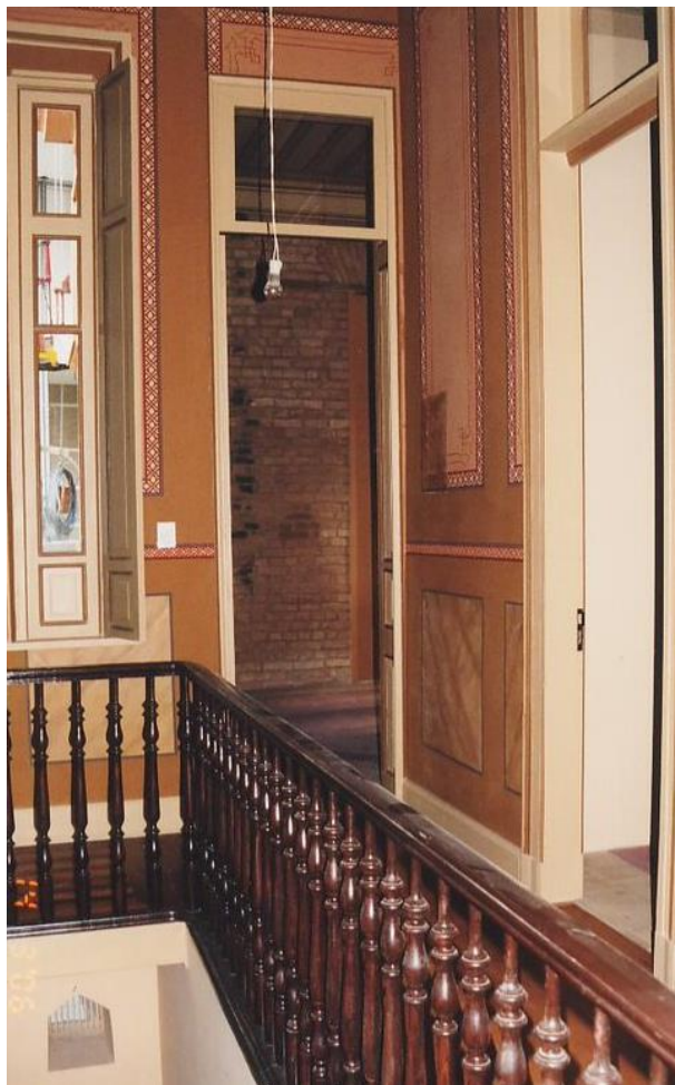
Figura 89: Corredor de acesso aos banheiros, cozinha e escada de mármore que leva ao porão Foto: Sueli Finoto, 2006. Fonte: Fonte: Acervo fotográfico do Museu do Tribunal de Justiça de São Paulo.
