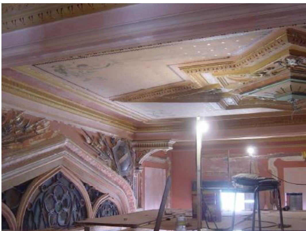
Figura 59: Detalhes do forro (2)
