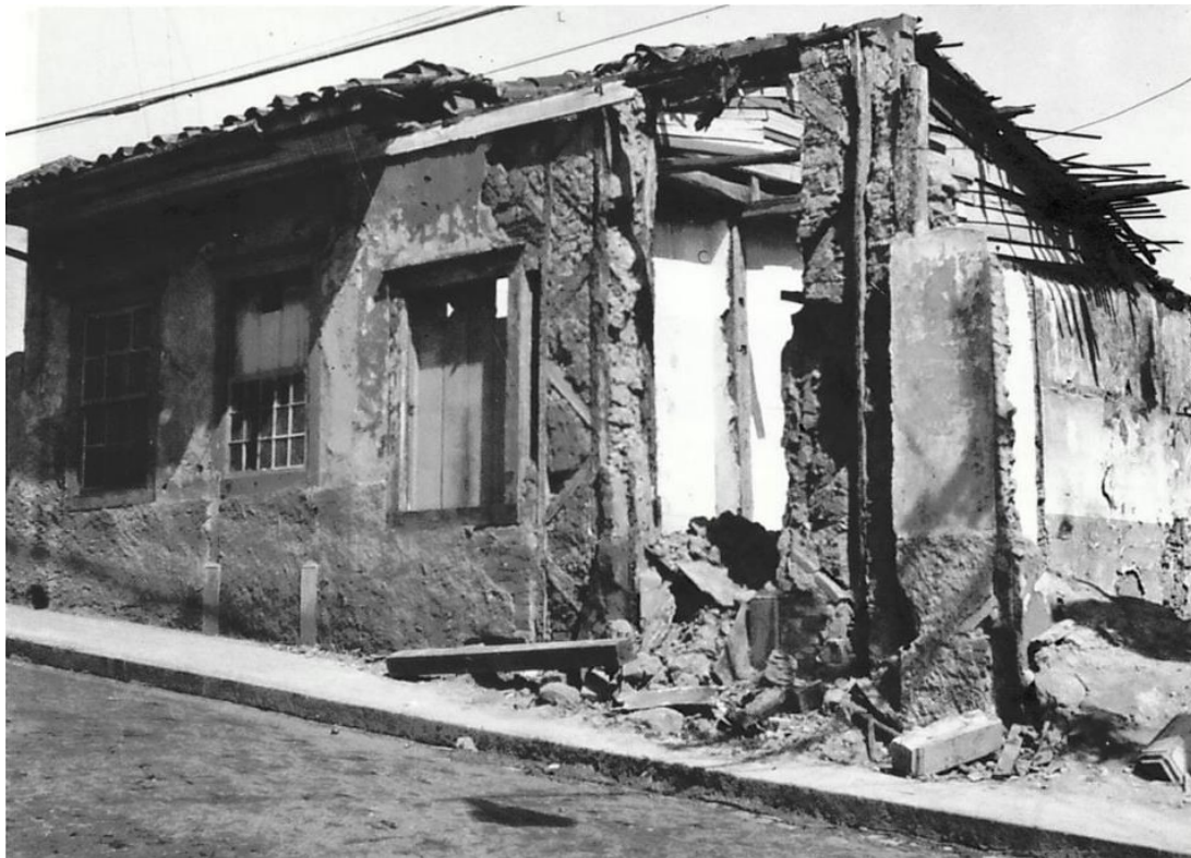
Figura 34: Casa de taipa demolida, que se localizava na Rua Tabatinguera Fonte: Prefeitura de São Paulo. Disponível em: Scanned Document (prefeitura.sp.gov.br).
