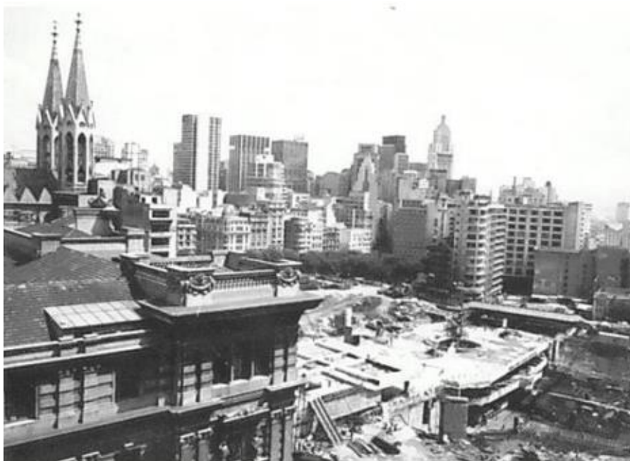
Figura 28: Imagem da Praça da Sé, obras de construção do metrô, 1976
