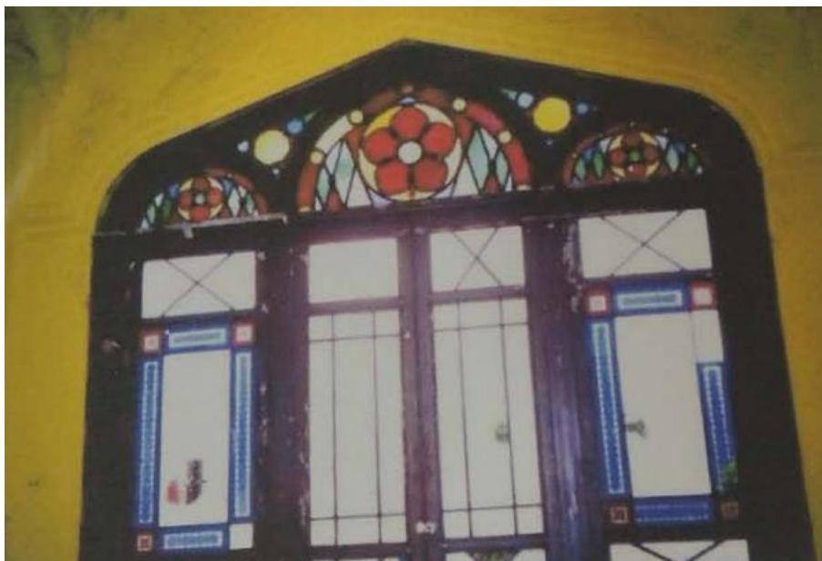
Figura 64: Vidros recolocados e restaurados (1) Autor: STCT/DPH Processo de tombamento. Fonte: Cidade de São Paulo (2001, fl. 26).
