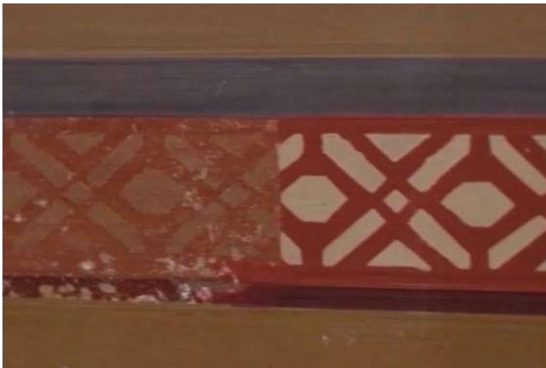
Figura 54: Processo de decapagem (3) Fonte: Acervo do Museu.
