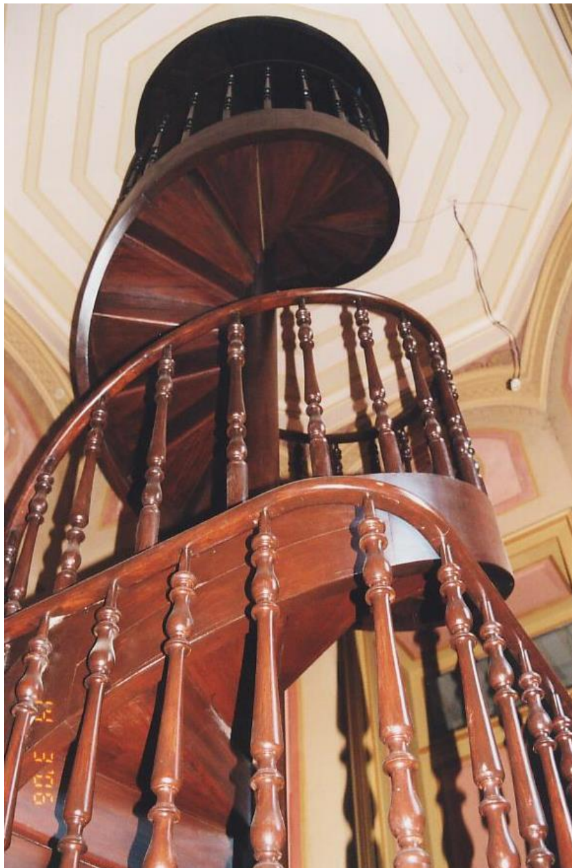
Figura 97: Detalhe da escada Helicoidal
