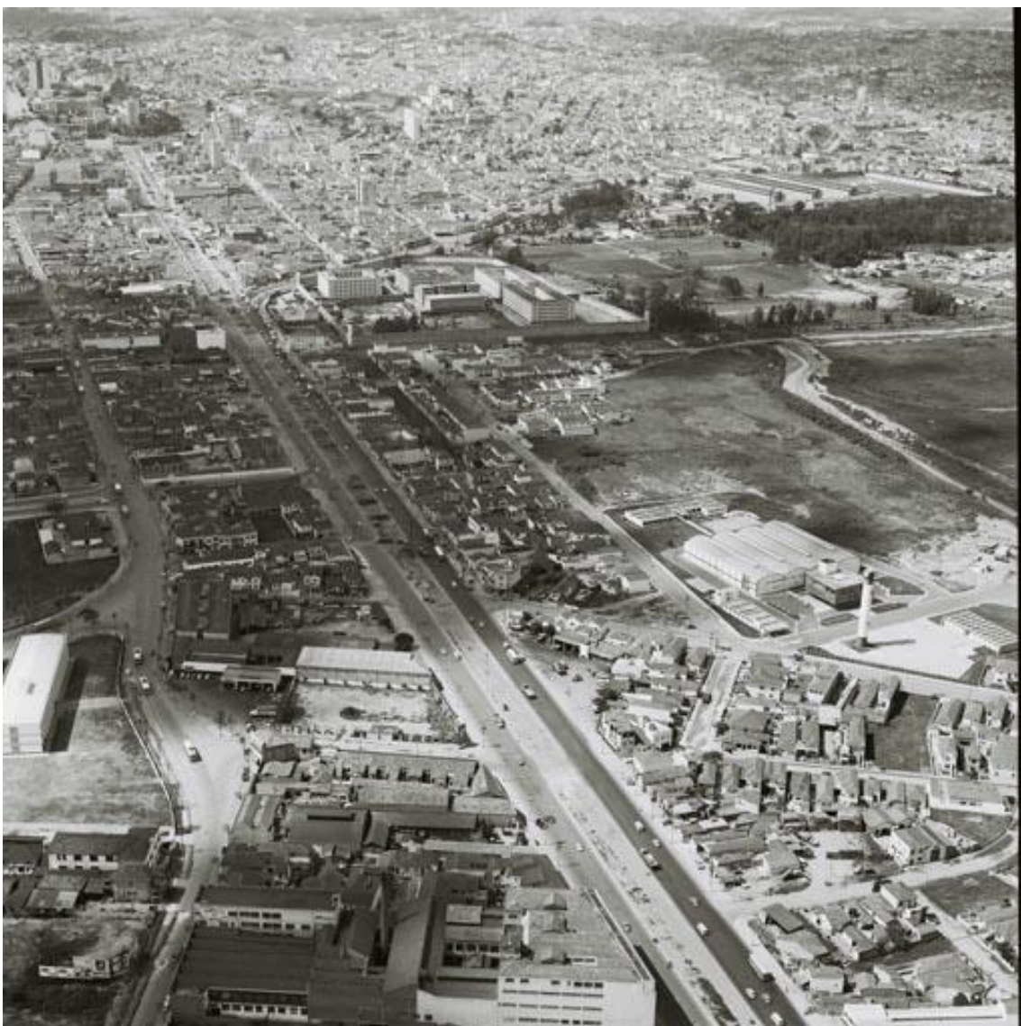
Figura 7 – Vista aérea das Obras do Metrô (norte-sul).
