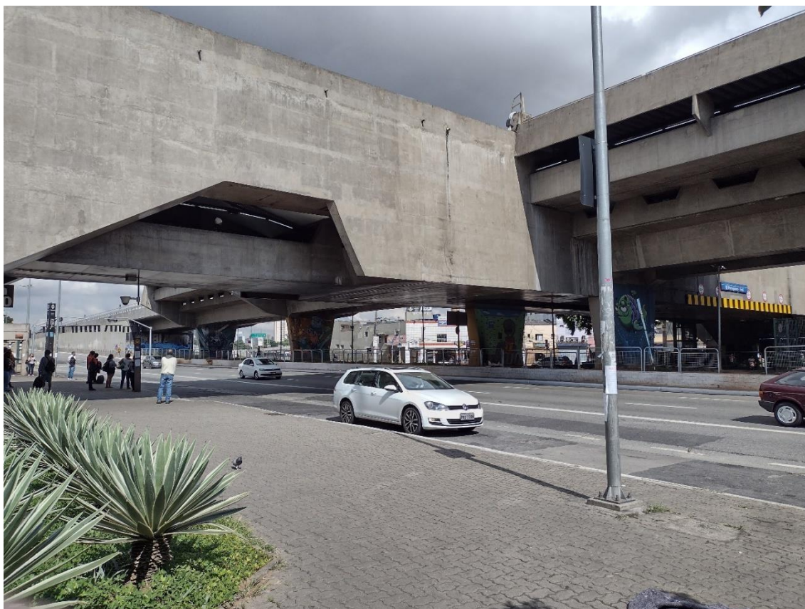
Figura 37 – Estação de Metrô e Rodoviária Portuguesa-Tietê.
