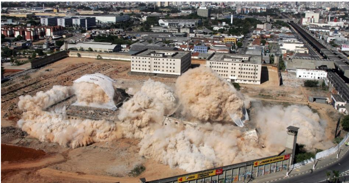
Figura 18 – Implosão dos pavilhões da Casa de Detenção (Carandiru).
