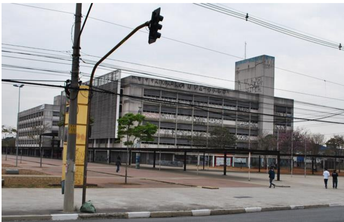
Figura 36 – Foto da Etec Parque da Juventude e entrada do PJ antes de ser gradeado.
