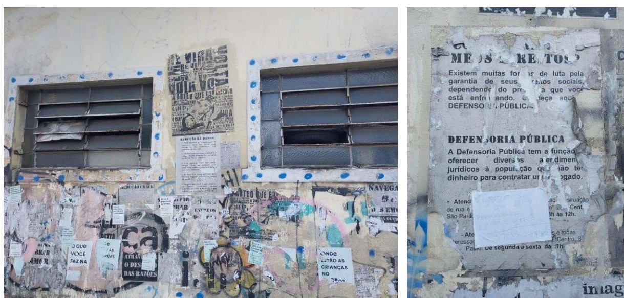
Fig. 55: Parte de muro localizado na Rua Tenente Pena, ao lado da UBS Bom Retiro.
