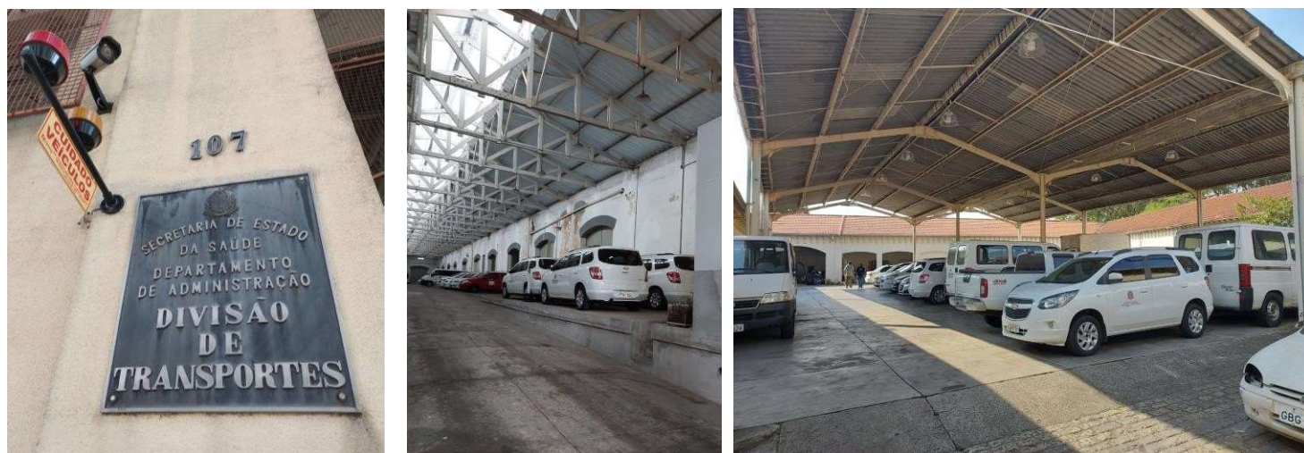
Fig. 07: Identificação da Divisão de Transportes na entrada lateral do prédio e pátio com frota de veículos.
