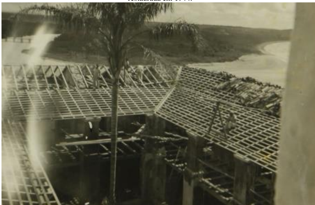
Figura 55 – Fotografia da Igreja e Residência dos Reis Magos, Serra, Espírito Santo (ES) sendo restaurada em 1944.
