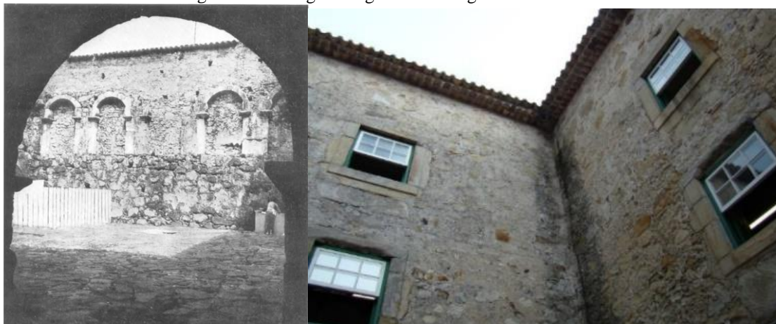
Figura 73 – Antigo Colégio de Paranaguá de 1750 – PR.
