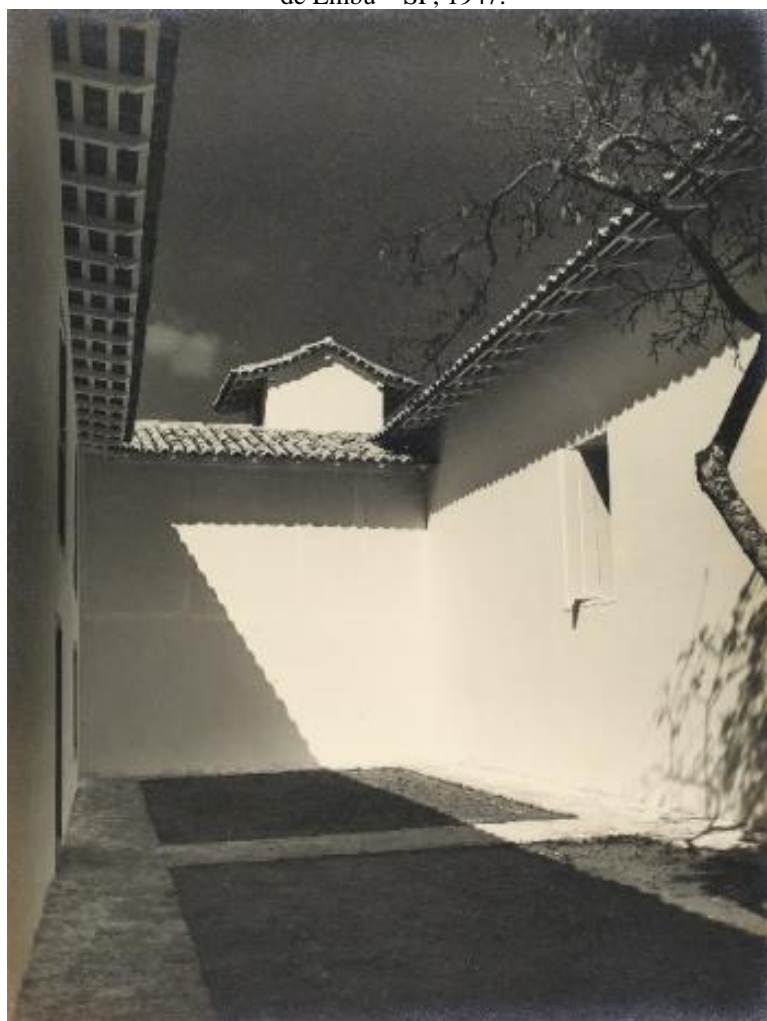
Figura 69 – Fotografia de Germano Graeser do Pátio interno da Igreja de Embu – SP, 1947.
