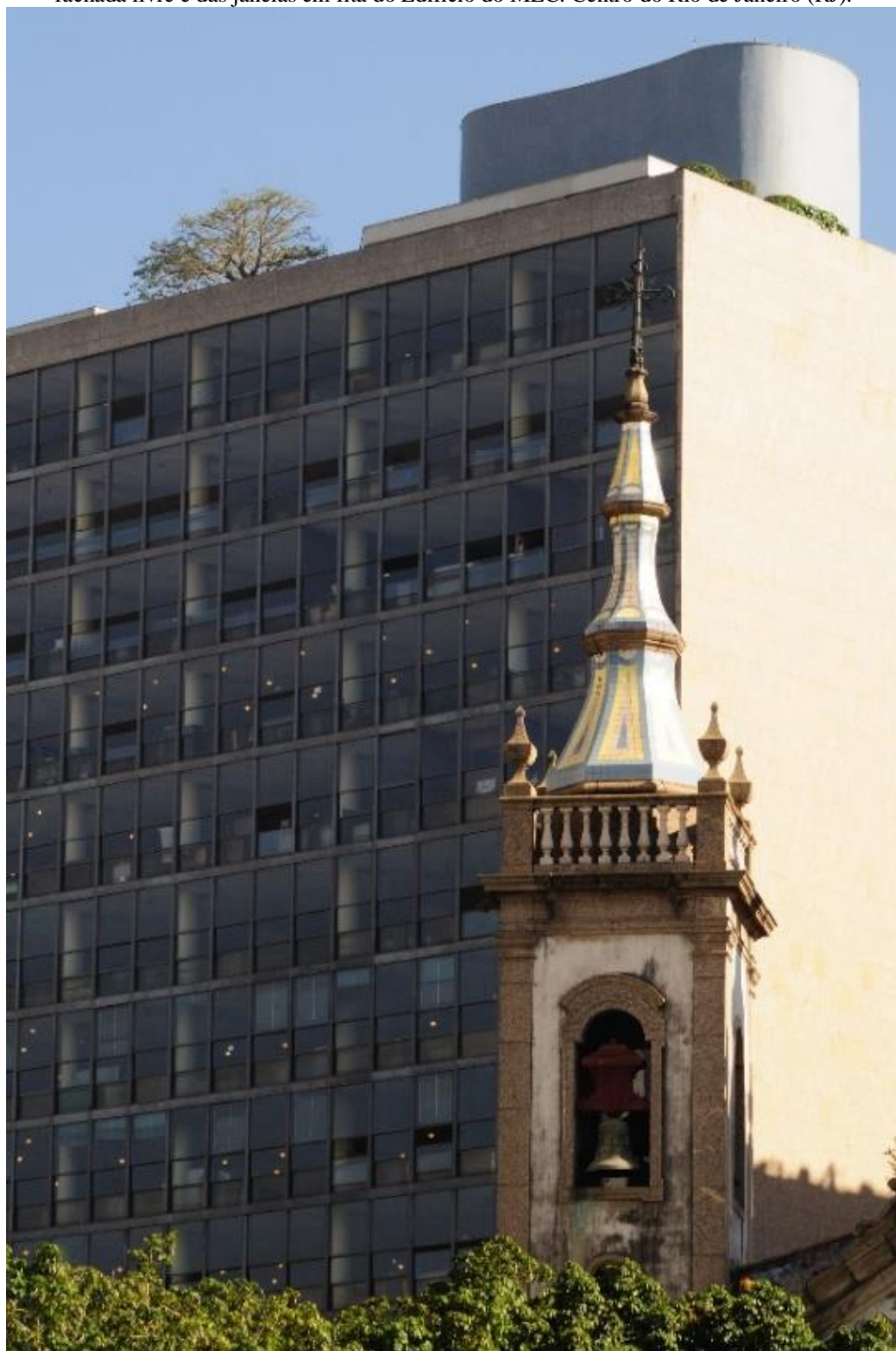
Figura 29 – A torre e a cruz de cúpula da Igreja de Santa Luzia e ao fundo a cruz do risco da fachada livre e das janelas em fita do Edifício do MEC. Centro do Rio de Janeiro (RJ).
