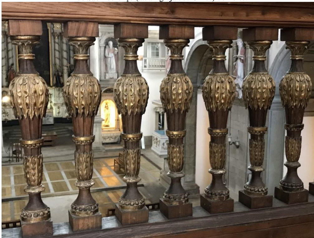
Figura 136 – Detalhe do madeiramento do guarda-corpo do coro da igreja do antigo Colégio de São Lourenço (atual Igreja dos Grilos) do Porto.
