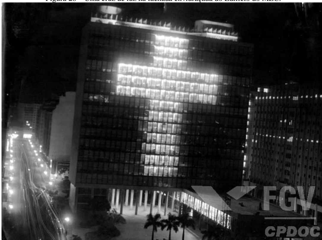
Figura 28 – Uma cruz de luz na fachada envidraçada do Edifício do MEC.
