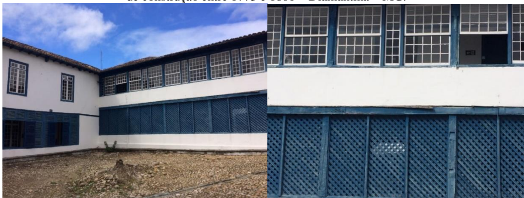
Figura 72 - Passadiço da Casa da Glória (atual Instituto de Geociências da UFMG), provável período de construção entre 1775 e 1800 – Diamantina – MG.
