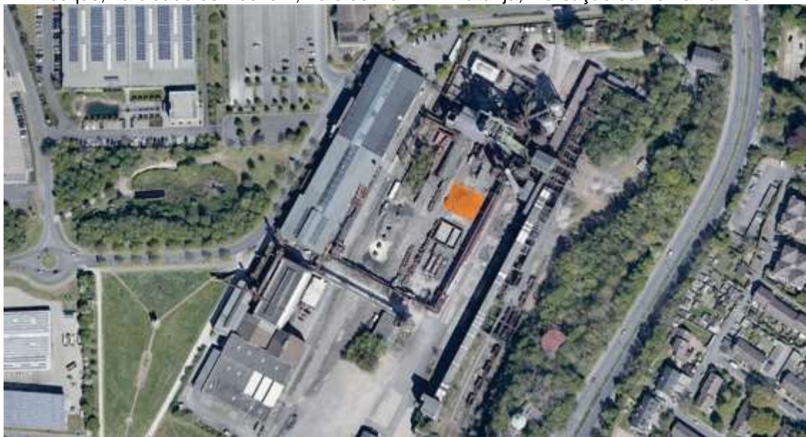
Figura 13 – Vista aérea do Museu LWL, construído nos remanescentes da antiga indústria de coque, na cidade de Bochum, Vale do Ruhr. Em laranja, marcação da Fornalha nº02.
