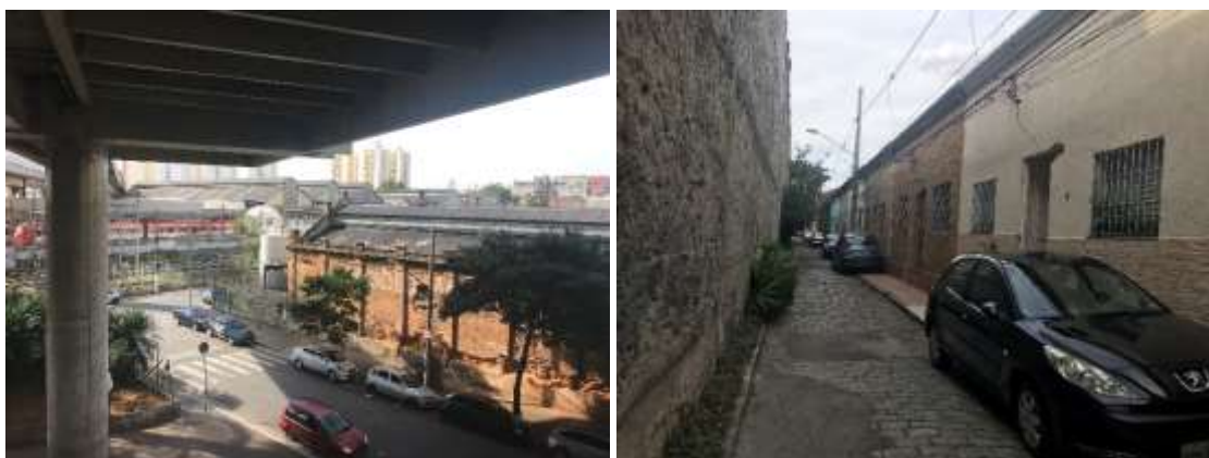
Figuras 38 e 39 – Brás. Oposição de escalas entre a infraestrutura urbana da estação Brás, a unidade de detenção, um antigo edifício industrial e rua residencial.
