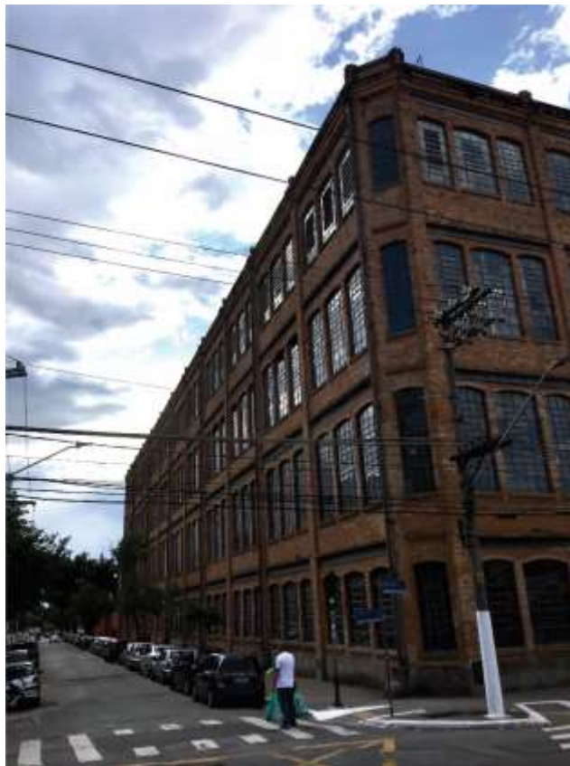
Fotos de levantamento de campo realizados pela autora, fevereiro de 2022.
