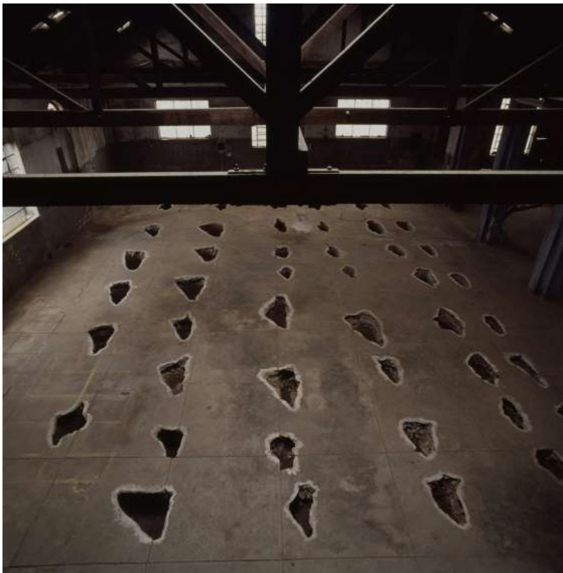
Figura 33 – Obra da artista Carmela Gross, “Buracos”, no edifício do antigo matadouro municipal de São Paulo para o Arte-Cidade 1.
