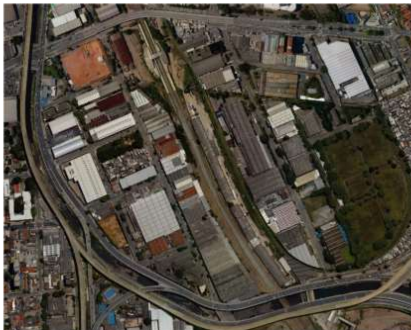
Figura 07 - Área 01 – Rua Barão de Resende.
