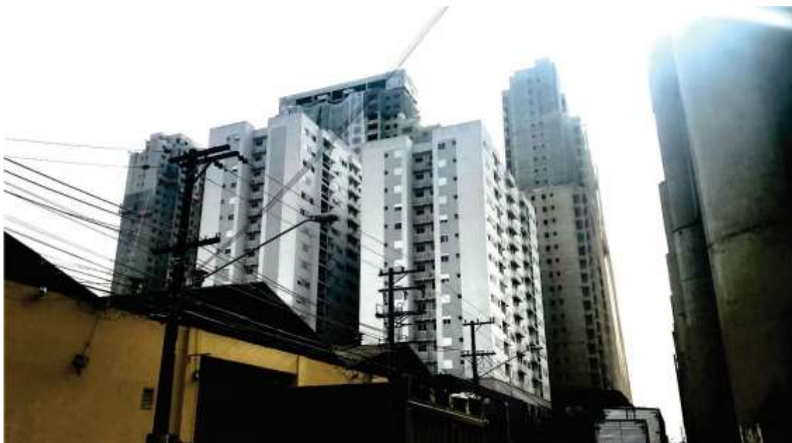
Figura 50 – Exemplo de verticalização no bairro do Brás- São Paulo, SP. Empreendimento Piscine Station Resort - Fotografia do levantamento de campo, à Rua Domingos Paiva, face à estação Brás.
