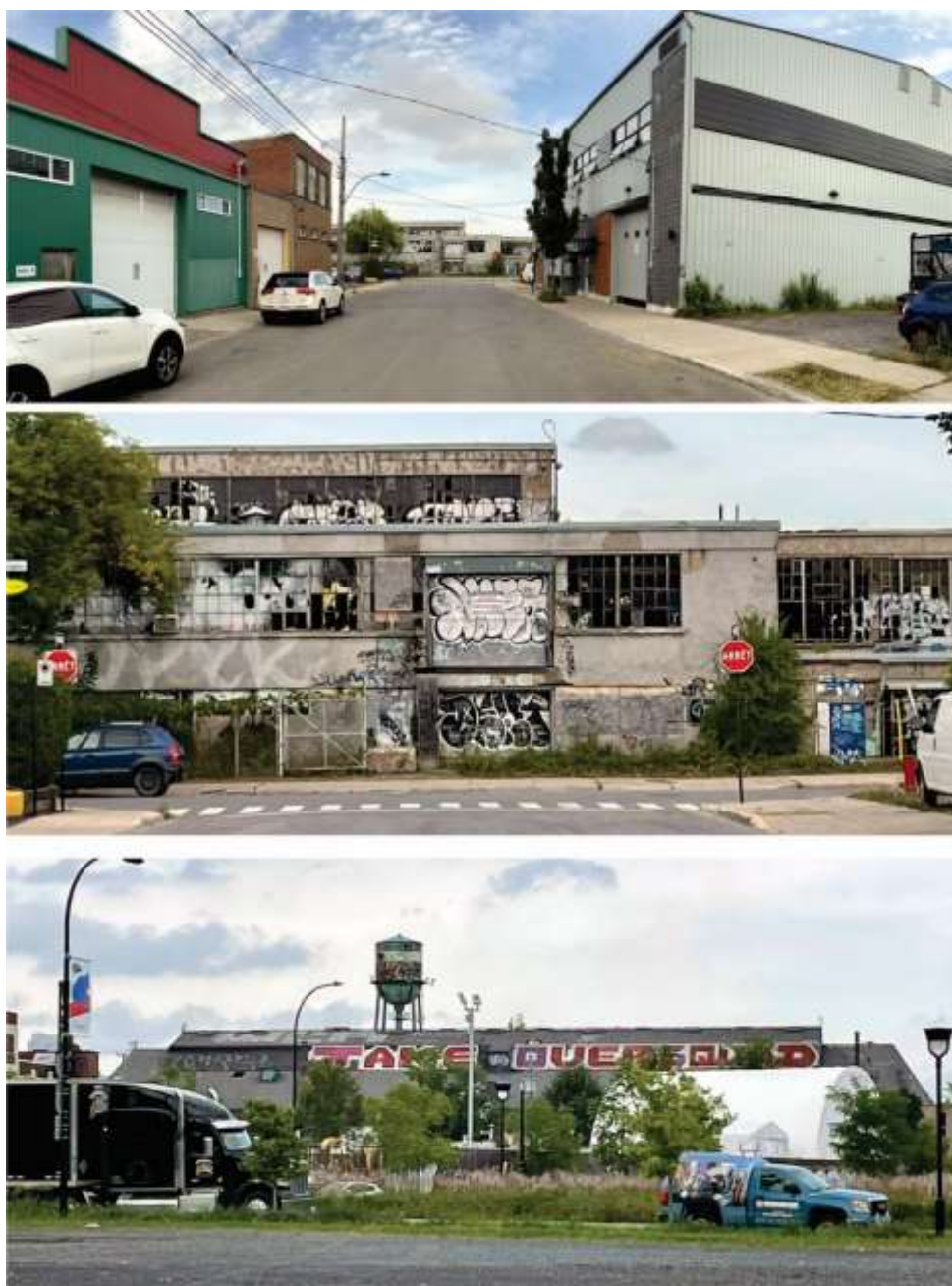
Figura 95 – Edificações sem utilização formal e tipologia da margem oposta do Canal do Lachine.
