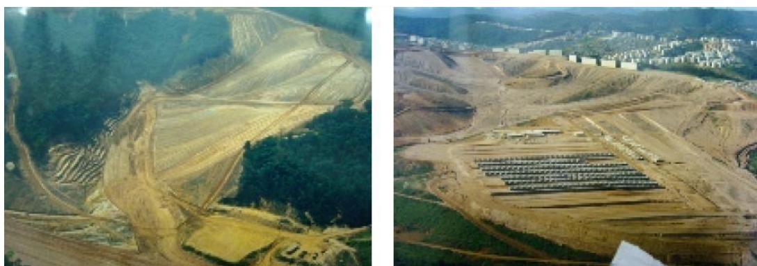
FIGURAS 51 E 52 - Terraplenagem do conjunto Cidade Tiradentes-SP.
