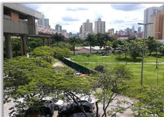
FIGURA 107 – Estação do Metrô Brás ao lado do Parque José Brás
