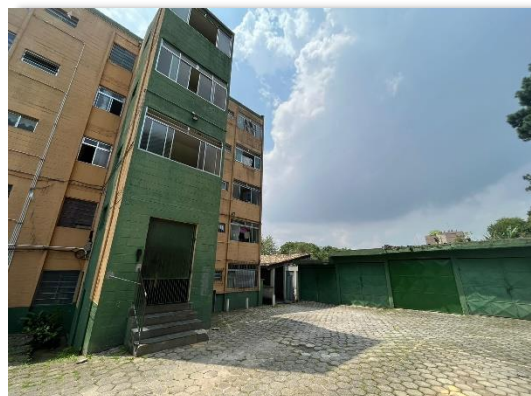
FIGURA 88 – Interior do bloco habitacional não atrai contato entre os diferentes, não favorece porosidade.
