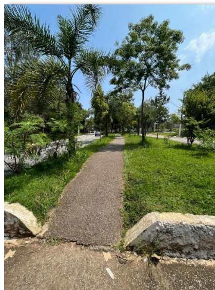
FIGURA 70 - Adaptação de rampas no espaço público.
