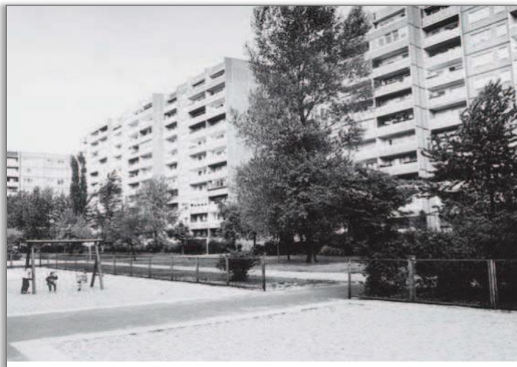
FIGURA 42 – Conjunto habitacional em Berlin – Friedrichsfelde (11 pavimentos do tipo WBS 70)
