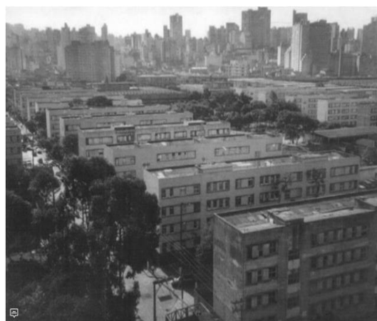
FIGURA 49 - Conjunto Residencial Várzea do Carmo
