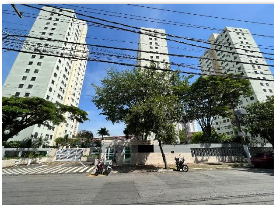
FIGURA 123 – Muro nos edifícios, impedindo a permeabilidade física de pessoas que não são moradoras.
