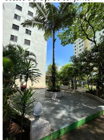
FIGURA 105 – Degrau para acesso à praça do conjunto.
