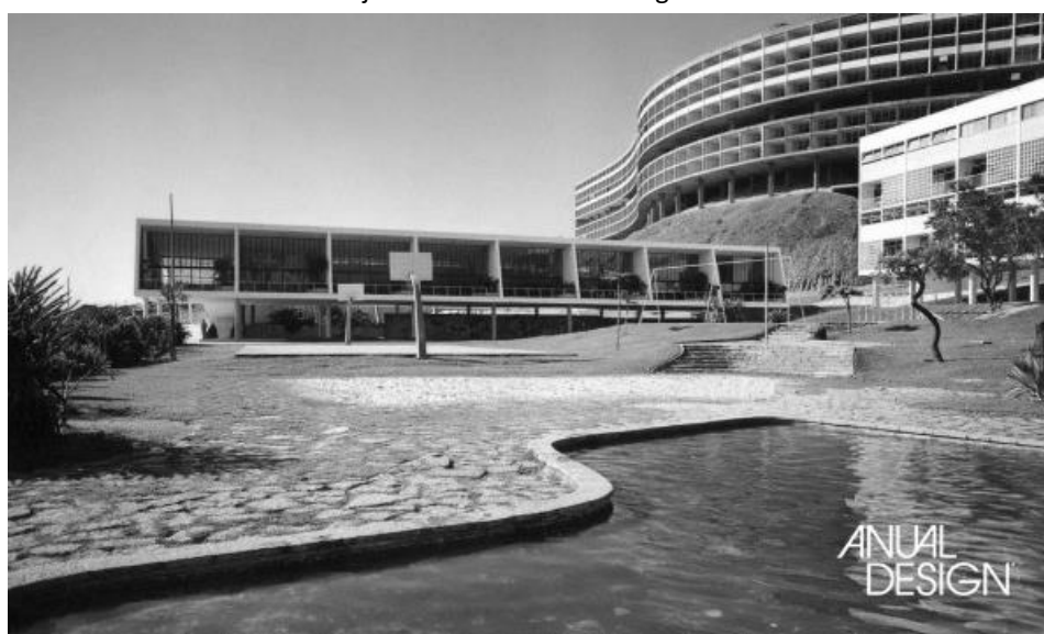
FIGURA 46 – Conjunto habitacional Pedregulho – Rio de Janeiro
