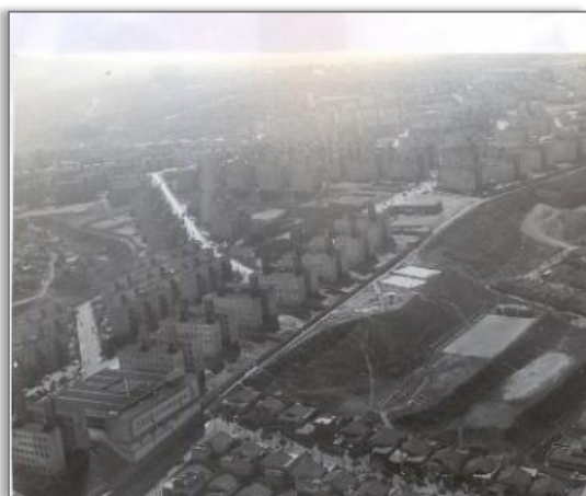
FIGURA 75 – Impacto ambiental com trabalho de terraplenagem intensa na implantação de conjuntos habitacionais.
