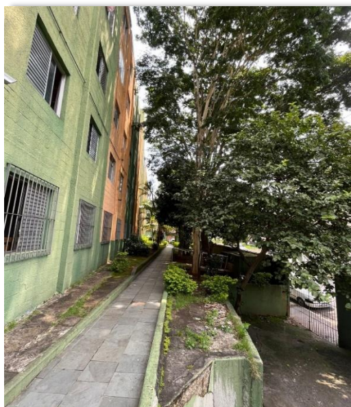
FIGURA 69 - Acesso principal do edifício por escada e desnível acentuado.
