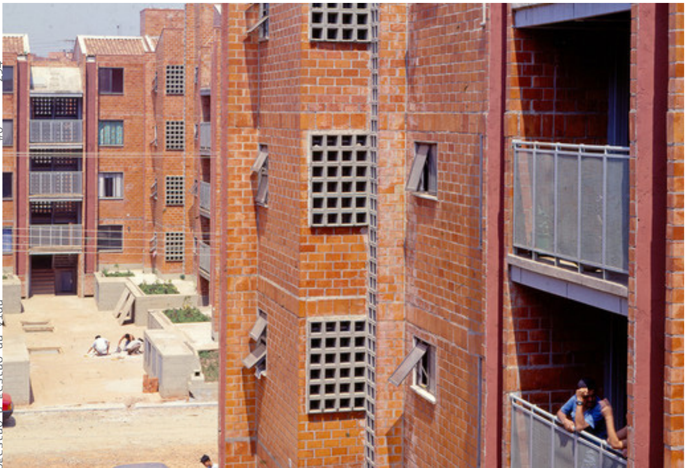
FIG085 — Vista dos blocos verticais construídos pelo mutirão autogerido “União da Juta” (1992-1998). // FONTE: Acervo USINA-CTAH, online. Disponível em: http://www.usina-ctah.org.br/uniaodajuta.html
