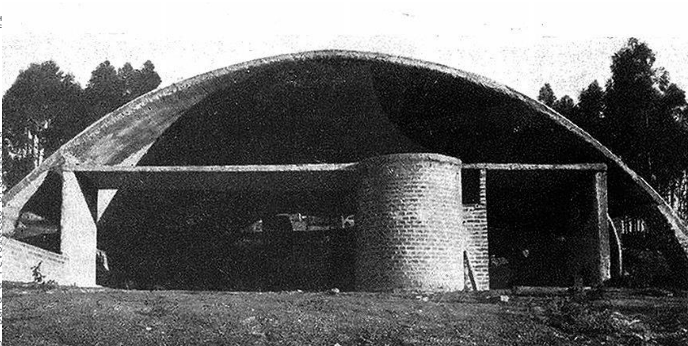
FIG009 — Detalhe da construção da abóboda para a Casa Bernardo Issler. Grupo Arquitetura Nova, 1961. // FONTE: Página web do Arquivo Arq. Disponível em: https://sixtensason.tumblr.com/post/175370368048/s%C3%A9rgio-ferro-resid%C3%Aancia-bernardo-issler
