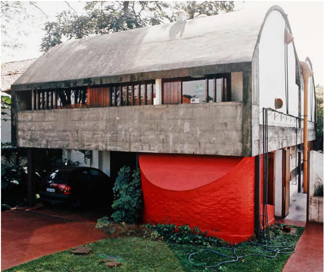
FIG014 — Fotografia do pátio de entrada da Casa Juares Brandão. Grupo Arquitetura Nova, 1968. // FONTE: WATSON, 2020, p. 65.
