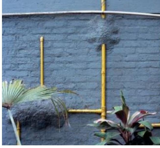
FIG012 — Detalhe das instalações aparentes e o registro da 'mão' do operário na argamassa de fixação. // FONTE: WATSON, 2020, p. 60.
