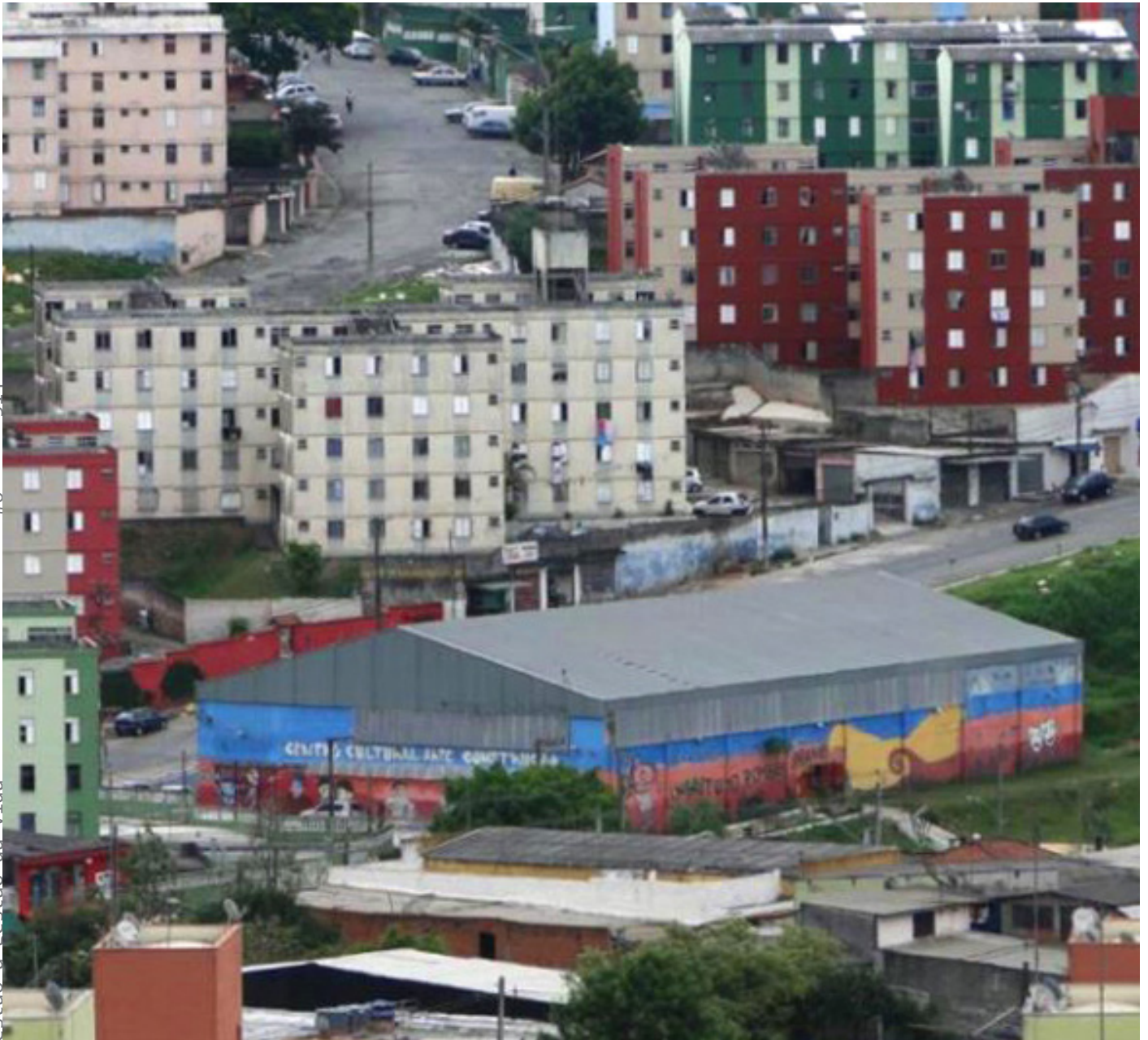
FIG091 — Vista do Centro Cultural Pombas Urbanas (no centro da imagem), localizado na Cidade Tiradentes, bairro da zona leste de São Paulo. // FONTE: Blog Folias Teatrais, online. Disponível em: https://foliasteatrais.com.br/tag/grupo-pombas-urbanas/
