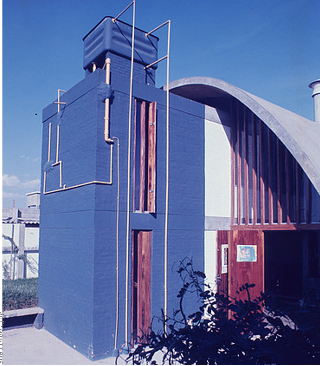
FIG012 — Detalhe das instalações aparentes e o registro da 'mão' do operário na argamassa de fixação. // FONTE: WATSON, 2020, p. 60.
