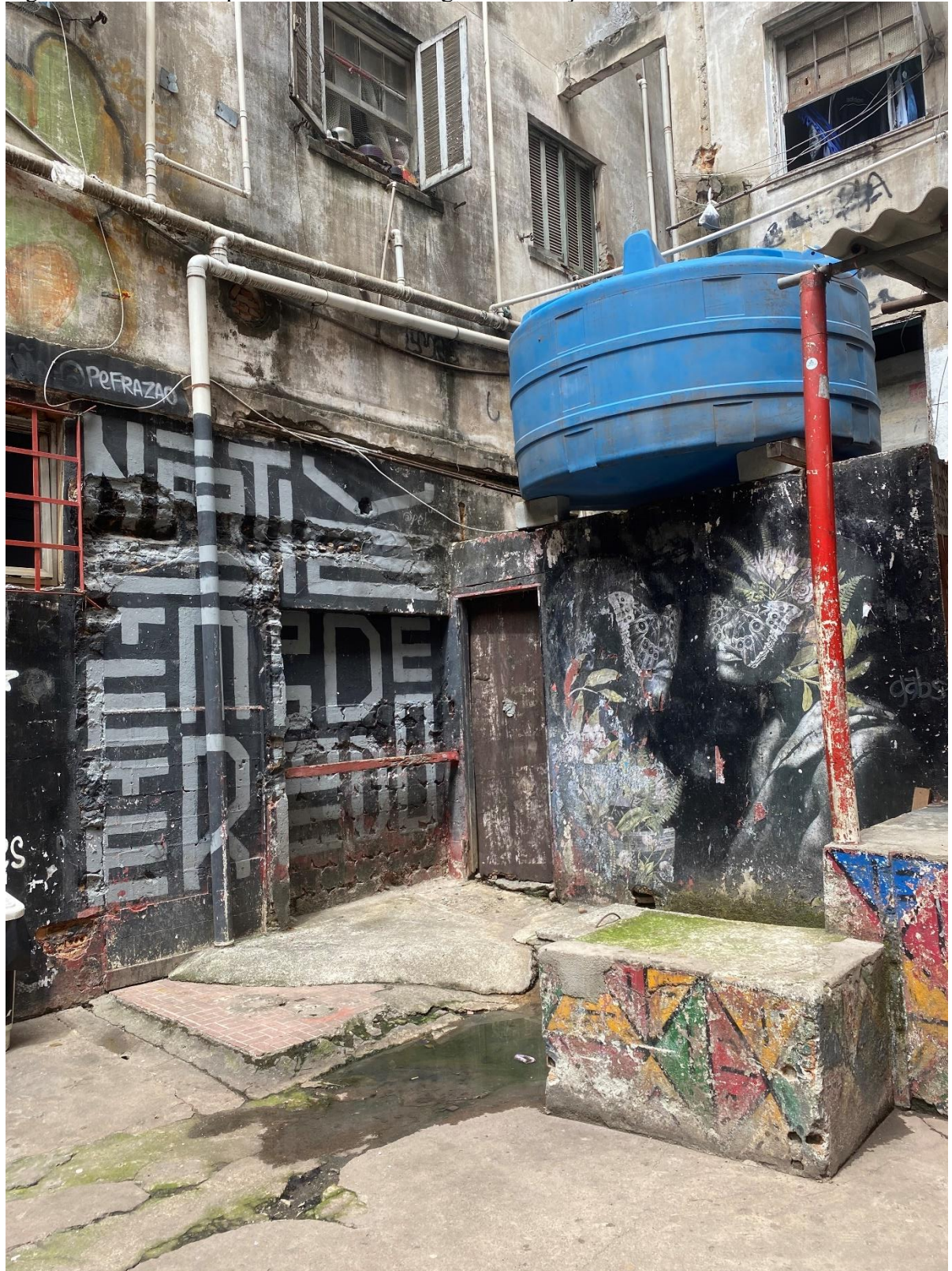
Figura 3.16: Vista do pátio com a caixa d'água e tubulações.
