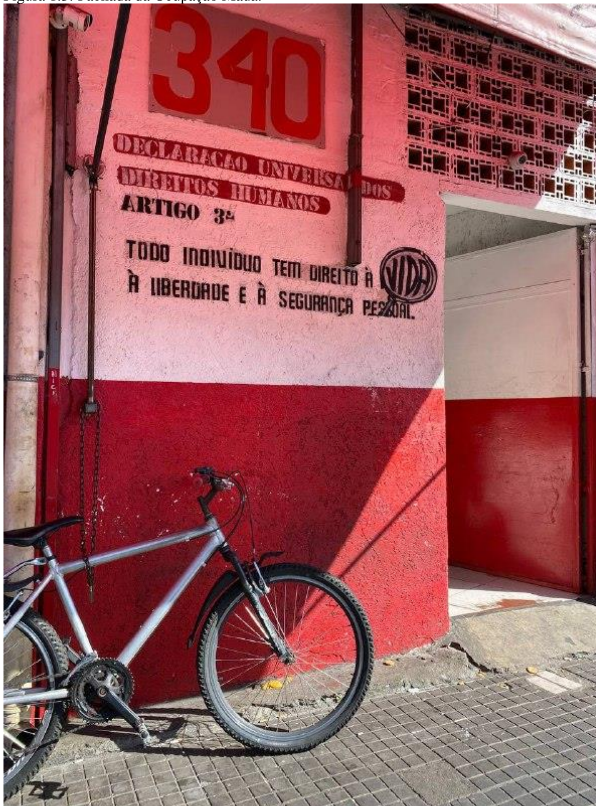
Figura 1.3: Fachada da Ocupação Mauá.
