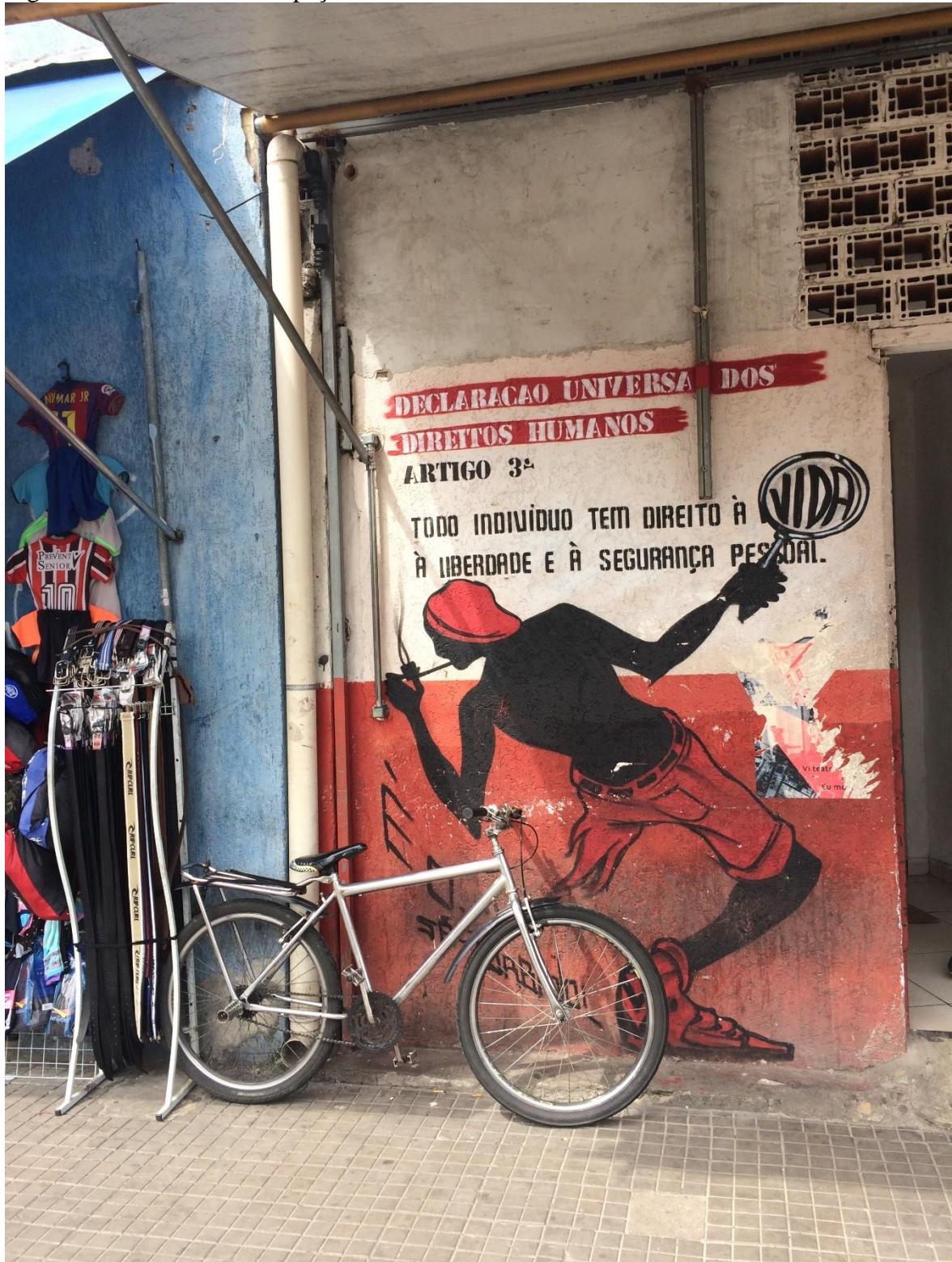
Figura 1.2: Fachada da Ocupação Mauá.
