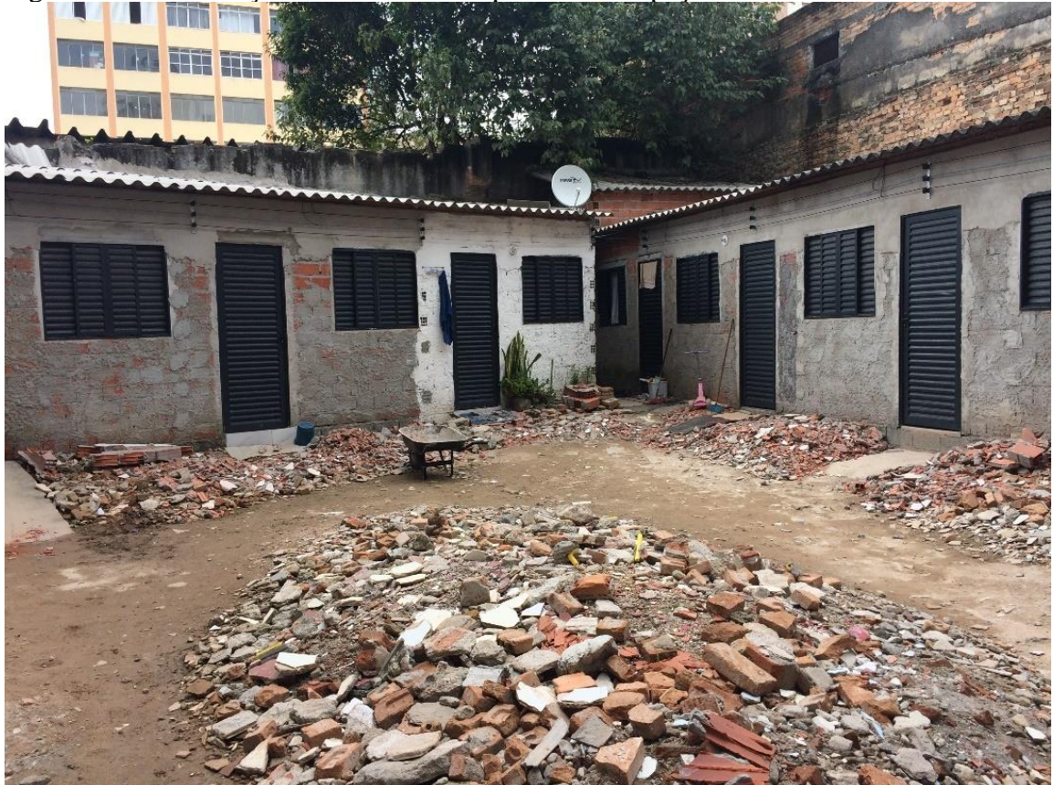
Figura 2.35: Construção das casinhas no quintal da ocupação.
