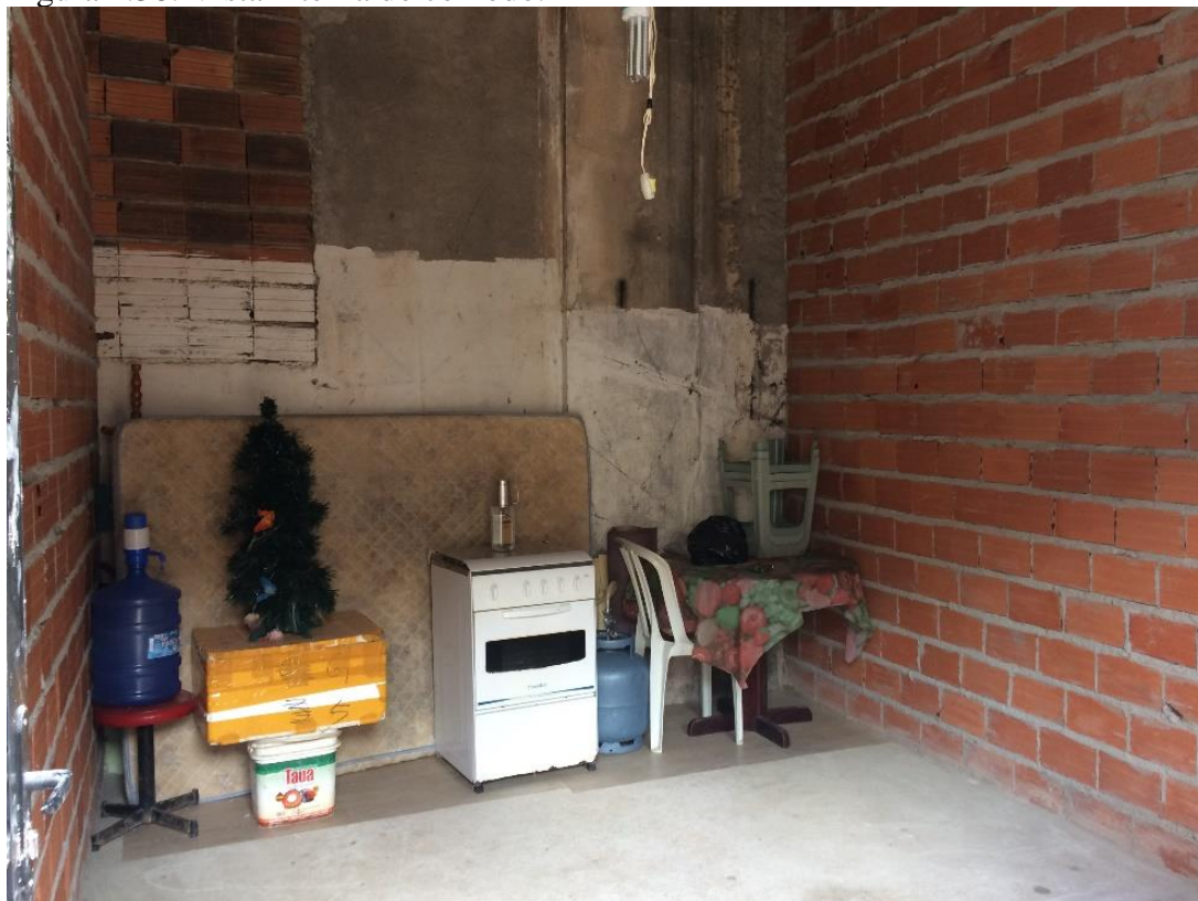
Figura 2.38: Vista interna do cômodo.
