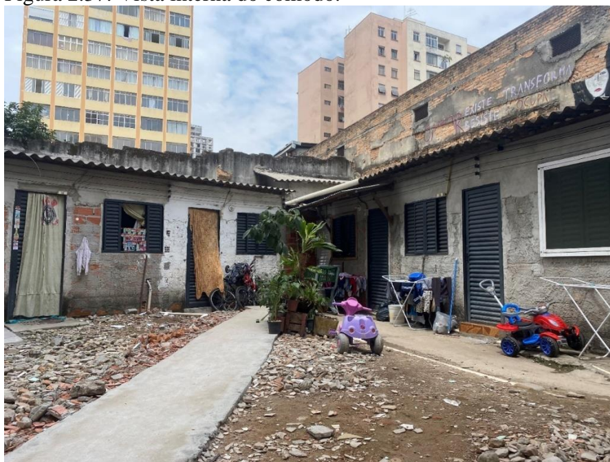
Figura 2.37: Vista interna do cômodo.
