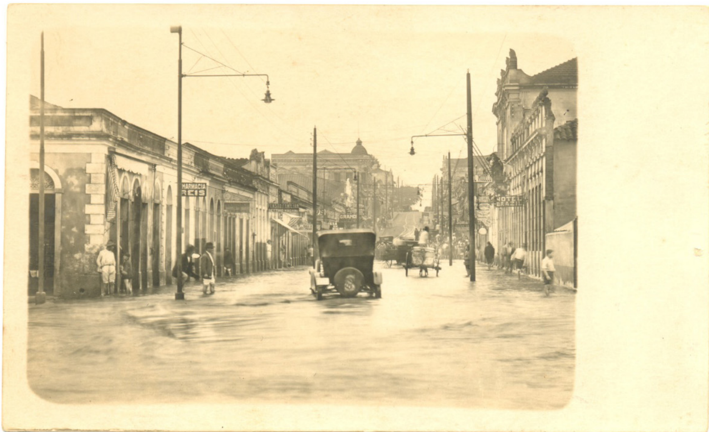
Figura 19: Alagamento na Rua General Osório, em frente à estação da Mogiana.
