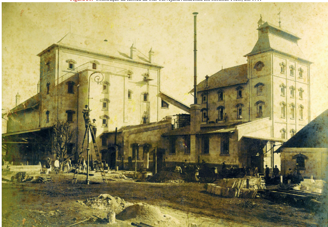
Figura 31: Construção da fábrica da Cia. Cervejaria Antarctica em Ribeirão Preto, em 1911
