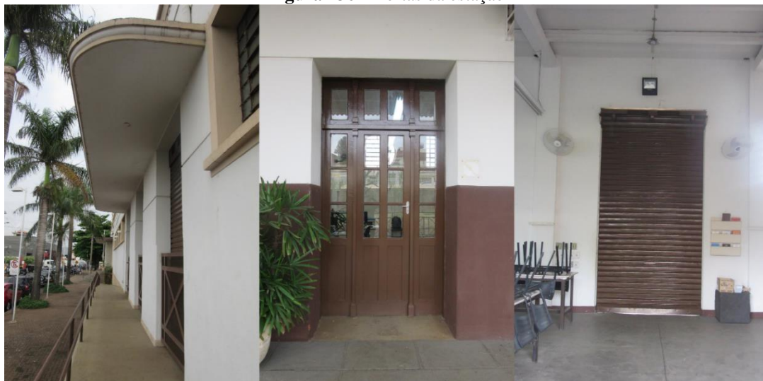
Figura 136 – Portas da estação
