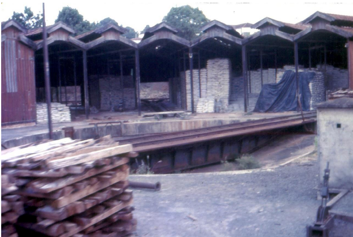
Figura 78 - Rotunda e girador em desuso
