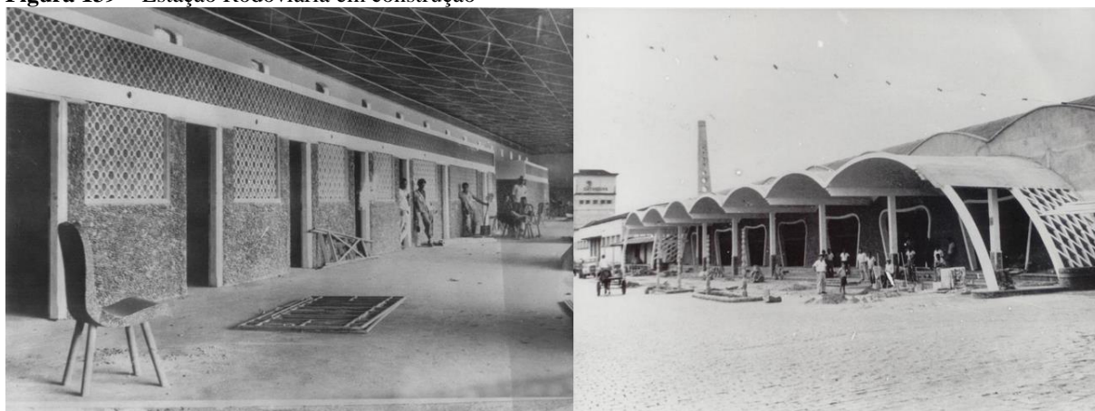
Figura 139 – Estação Rodoviária em construção
