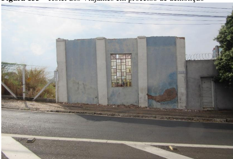
Figura 153 – Hotel dos Viajantes em processo de demolição
