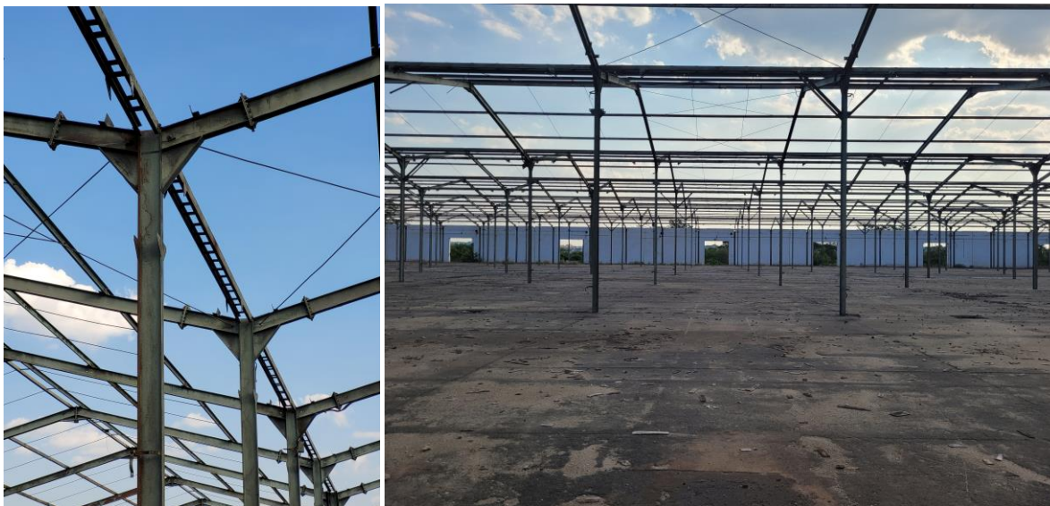
Figura 203 – Estruturas metálicas do galpão
