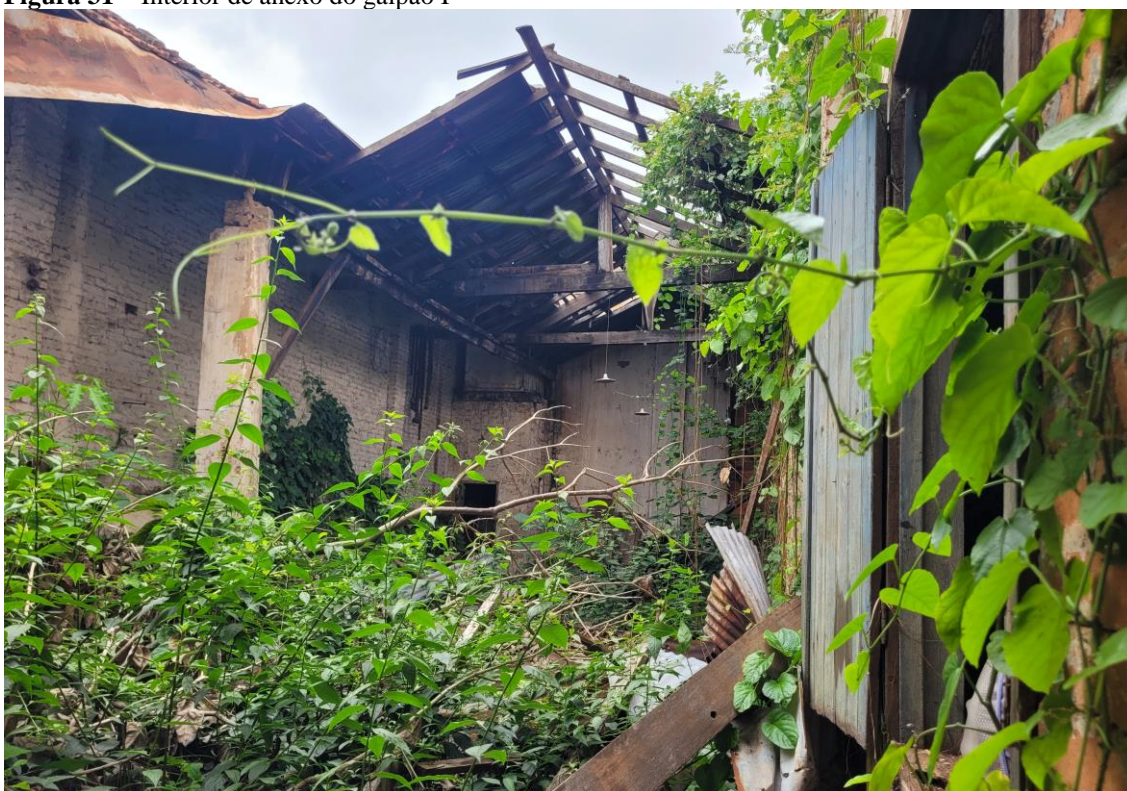
Figura 31 – Interior de anexo do galpão I
