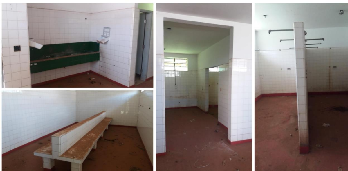
Figura 195 – Interior do vestiário
