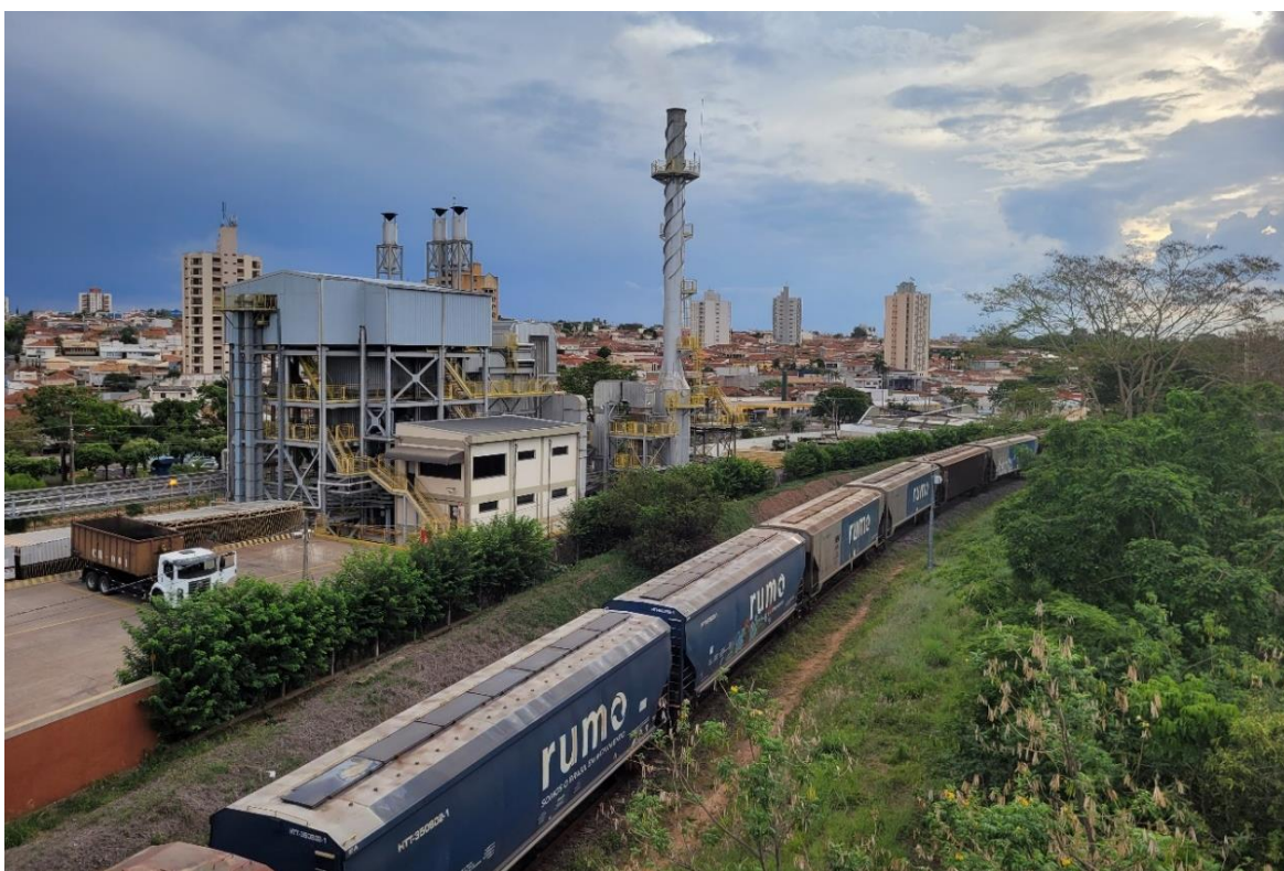
Figura 122 – Vista da COCAM e da ferrovia pelo viaduto Miguel Pachá
