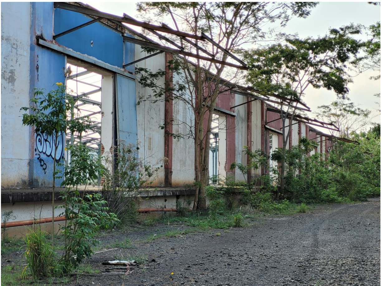
Figura 200 – Portas do galpão principal
