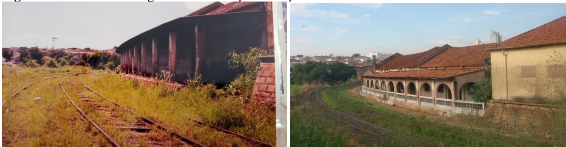
Figura 48 – “Machina Progresso” antes e após a adição dos arcos e da balaustrada
