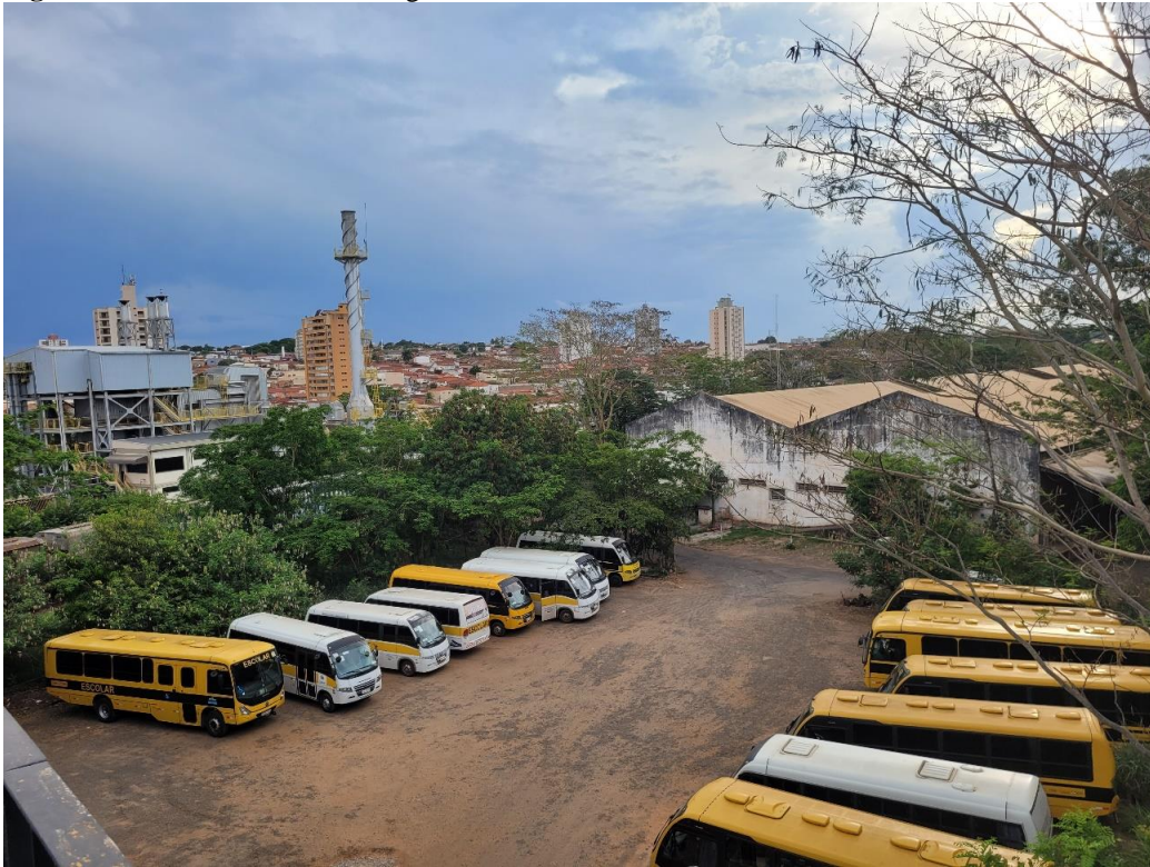
Figura 182 – Vista do viaduto Miguel Pachá: Pátio da frota de ônibus escolar
