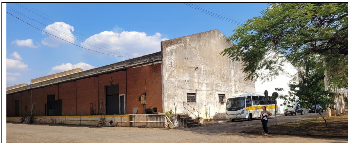
Figura 2. Fachada frontal da antiga CEAGESP. Fonte: da autora, 2022.
