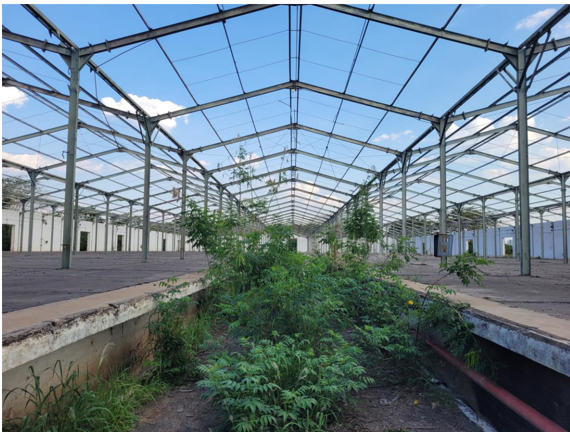
Figura 201 – Interior do galpão
