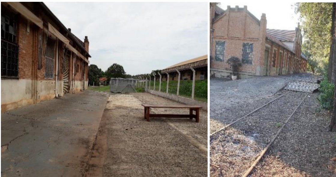
Figura 112 – Antigo desvio ferroviário aterrado
