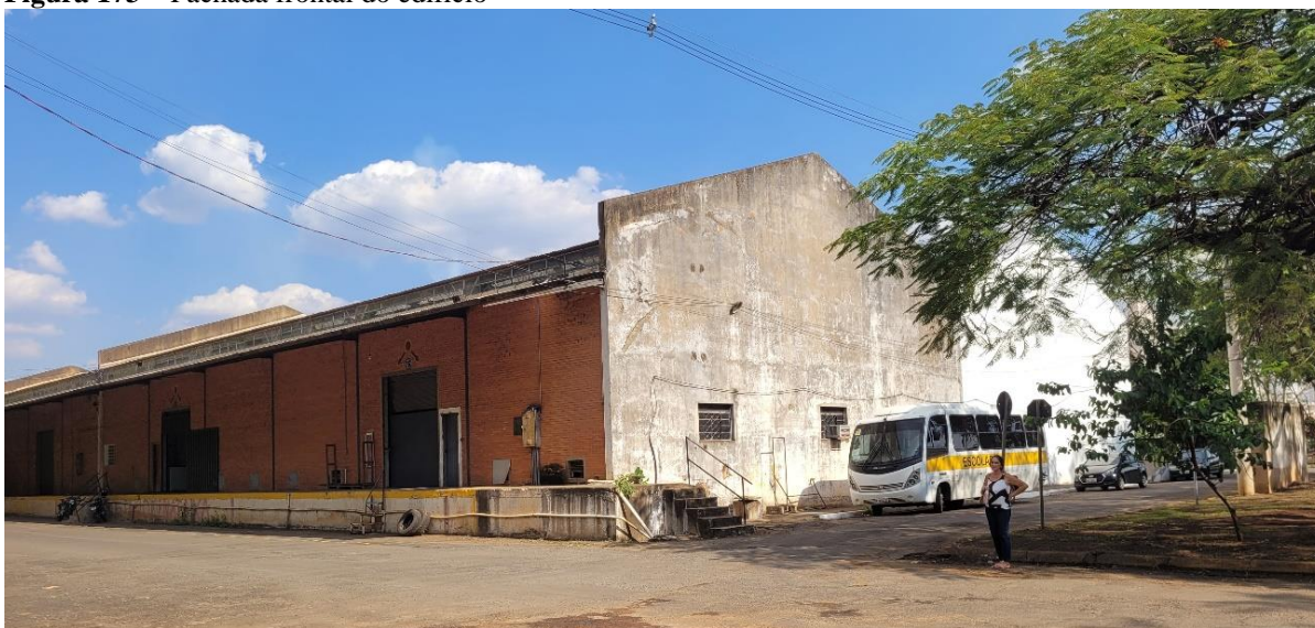
Figura 173 – Fachada frontal do edifício
