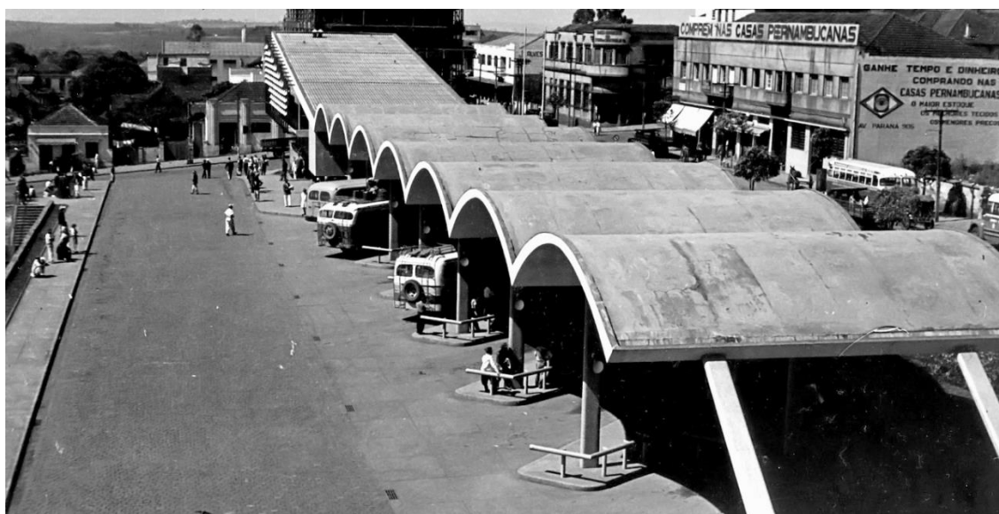
Figura 140 – Estação Rodoviária de Londrina-PR
