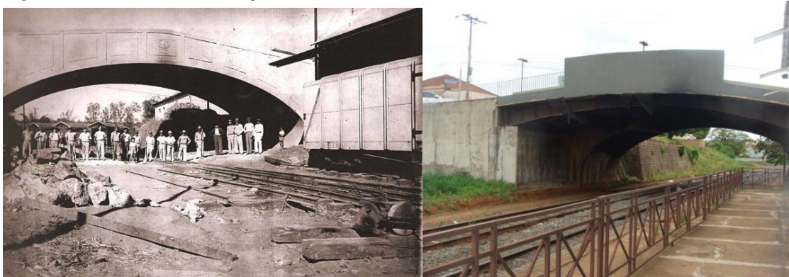
Figura 62 – Viaduto em construção e atual
