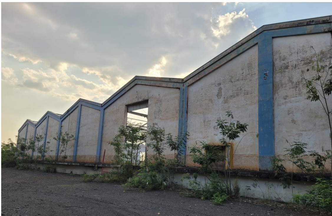
Figura 202 – Fachada frontal do galpão
