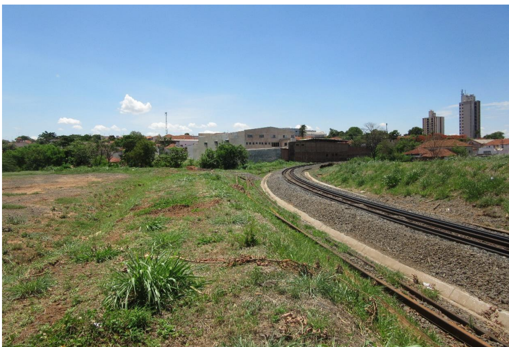
Figura 80 – Área do antigo pátio de manobras
