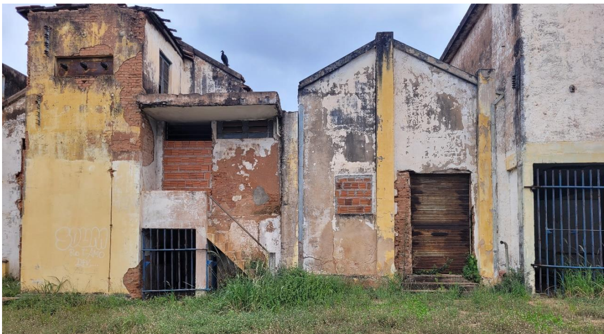
Figura 28 – Anexos do galpão I
