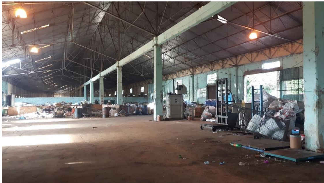
Figura 86 – Interior do Recicla Catanduva
