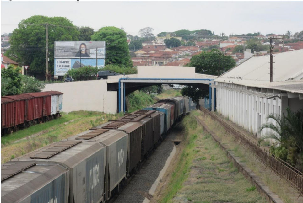
Figura 64 – Viaduto após o rebaixamento da linha férrea
