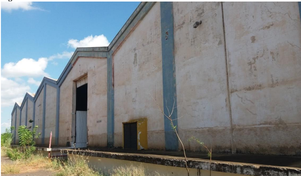
Figura 188 – Fachada frontal do armazém do IBC II
