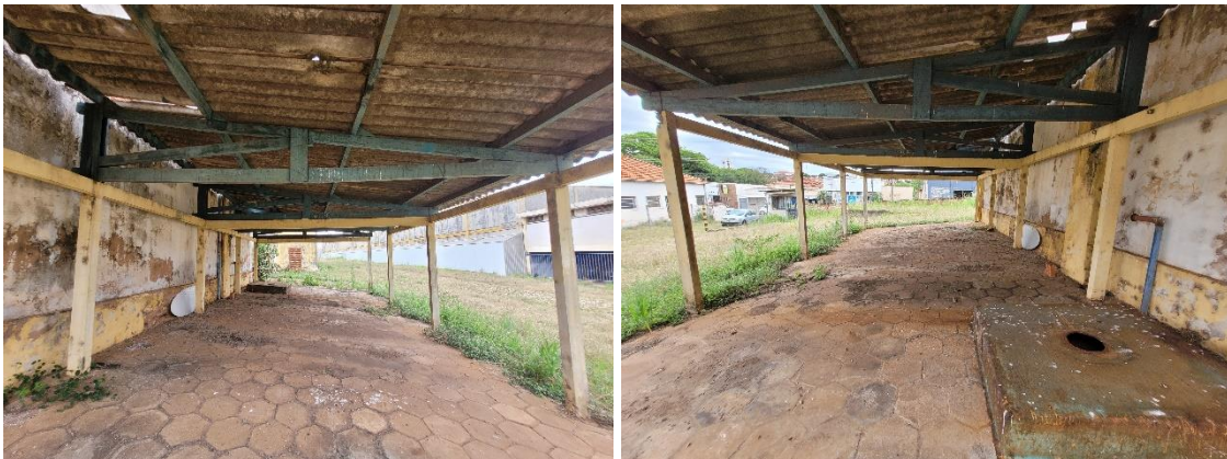
Figura 38 – Garagem/oficina do galpão II
