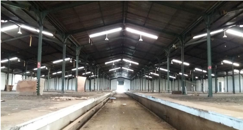
Figura 187 – Interior do armazém do IBC II
