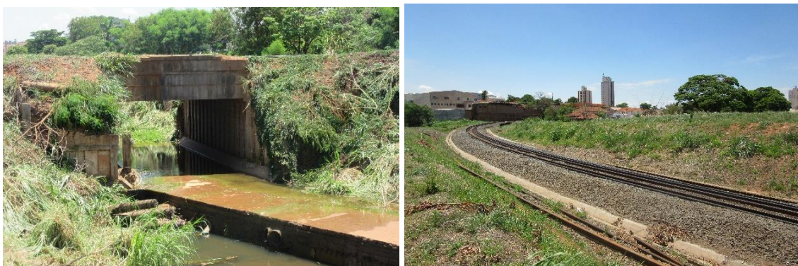
Figura 52 – Córrego Minguta e ferrovia
