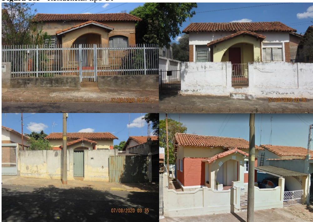
Figura 165 - Residências tipo C1
