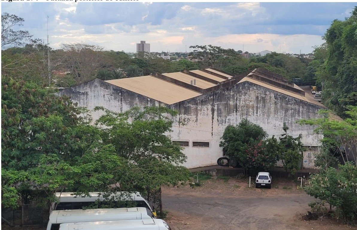
Figura 174 – Fachada posterior do edifício
