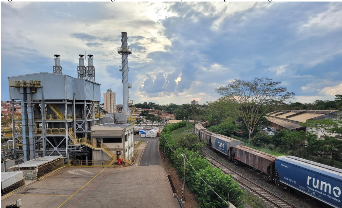
Figura 183 – Vista do viaduto Miguel Pachá: COCAM, ferrovia e o prédio da antiga CEAGESP
