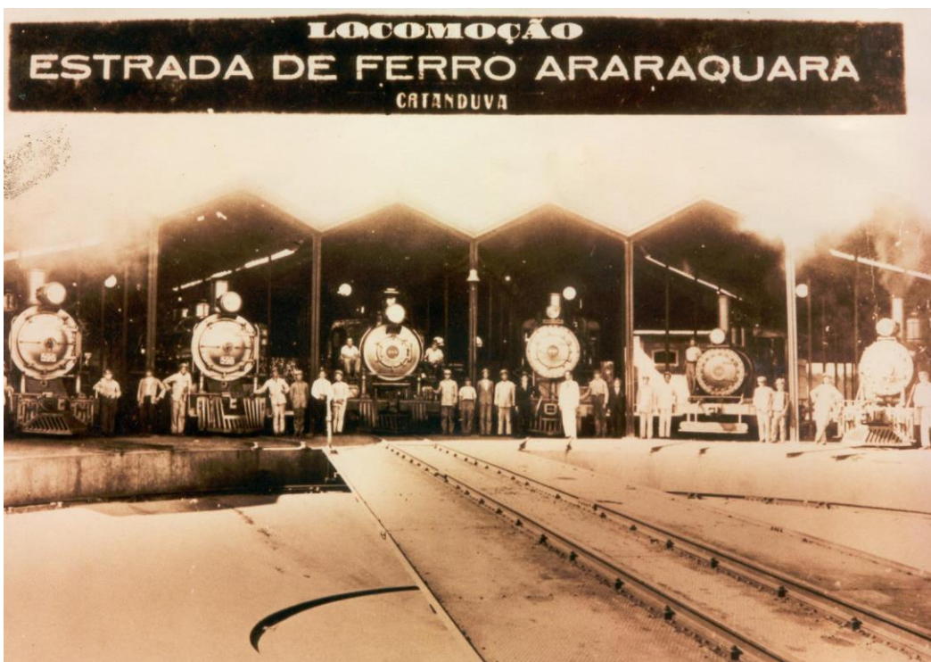
Figura 76 – Rotunda e girador
