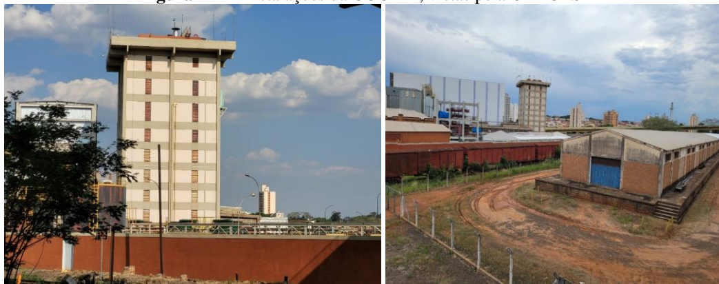
Figura 124 – Instalações da COCAM, vistas pela CEAGESP
