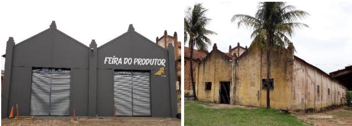
Figura 103 – Pintura na fachada principal do “galpão 02”
