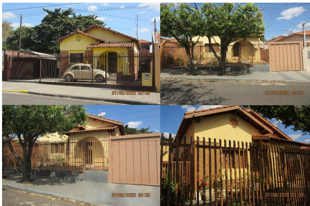
Figura 169 - Residências tipo C3
