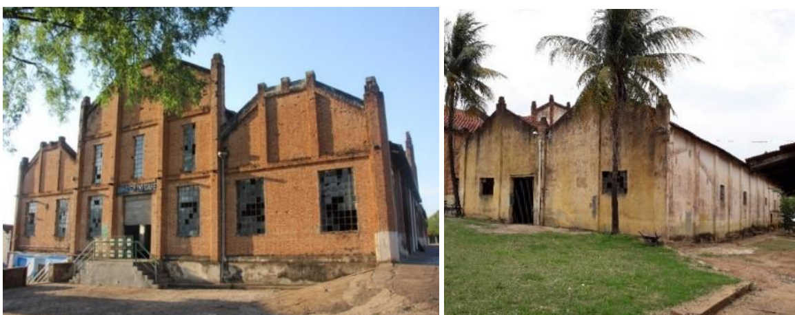
Figura 96 – a) “Galpão 01” (edifício principal) e b) “Galpão 02”
