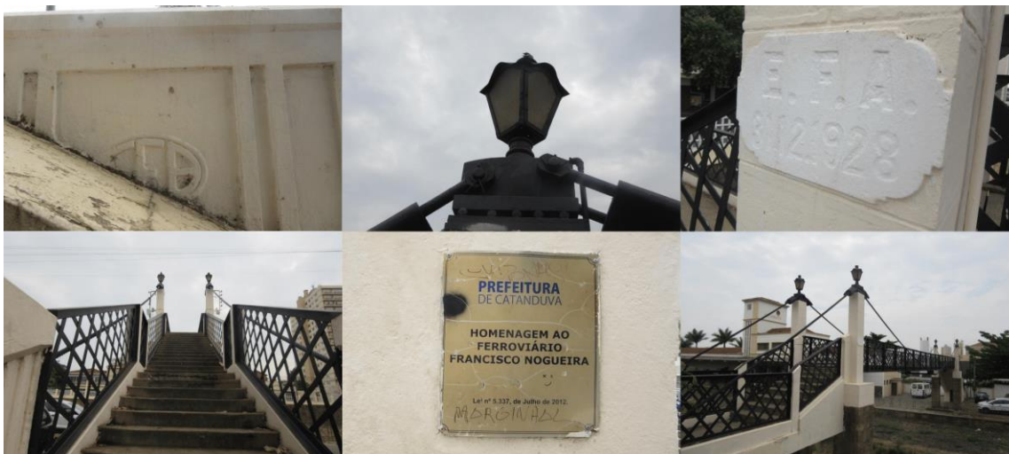
Figura 58 – Detalhes da Passarela “Francisco Nogueira”
