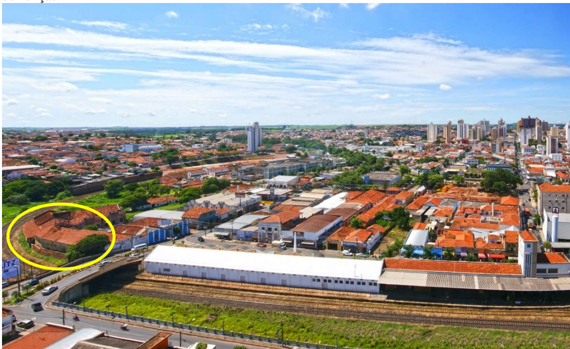
Figura 54 – Vista aérea da Estação Cultural, com a “Machina Progresso” destacada, antes da sua demolição
