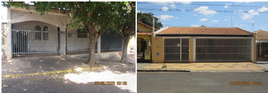
Figura 166 - Residências tipo C1 reformadas
