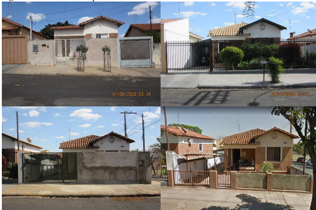
Figura 168 - Residências tipo C2
