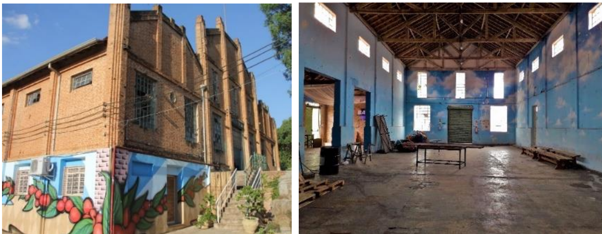
Figura 102 – Pintura no exterior e no interior do edifício principal
