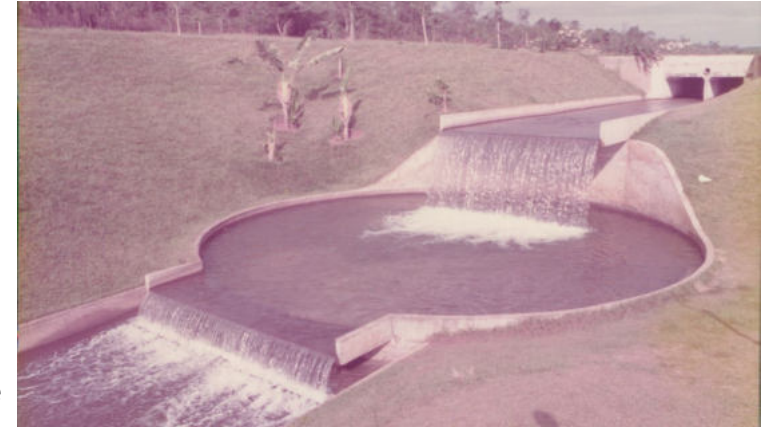
Figura 83 - 1975, cachoeira em concreto projetada por Santoro. Fonte: acervo histórico do Clube Náutico Araraquara, 2020.
