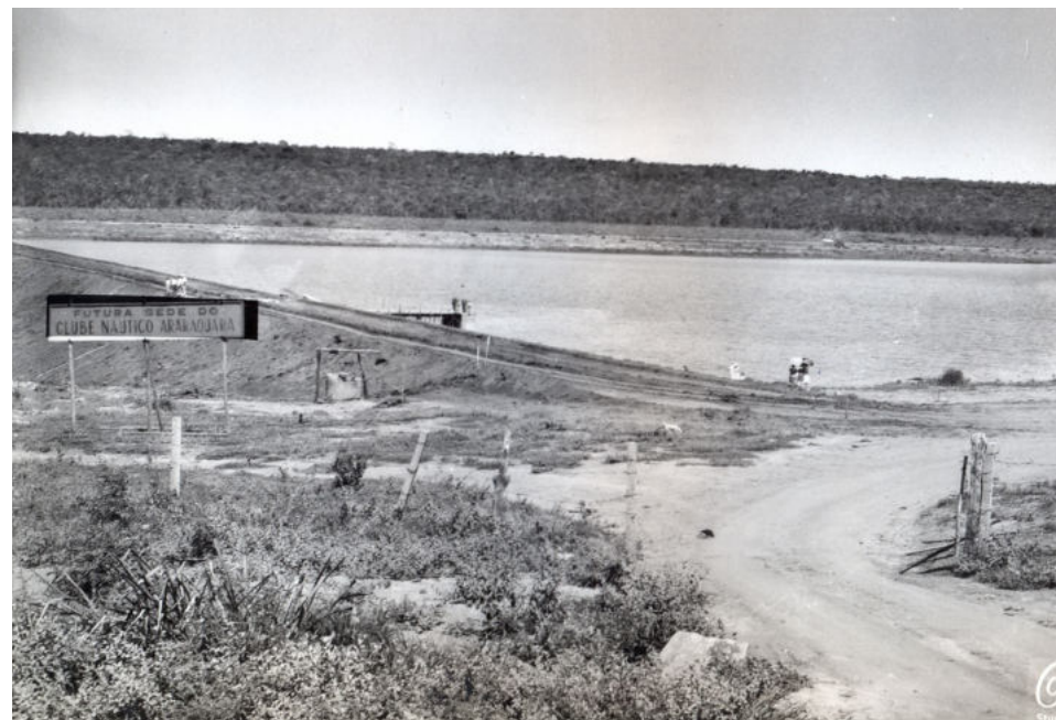
Figura 69 - Inauguração da barragem Clube Náutico Araraquara. Vista da margem Oeste da represa. Década de 60.
