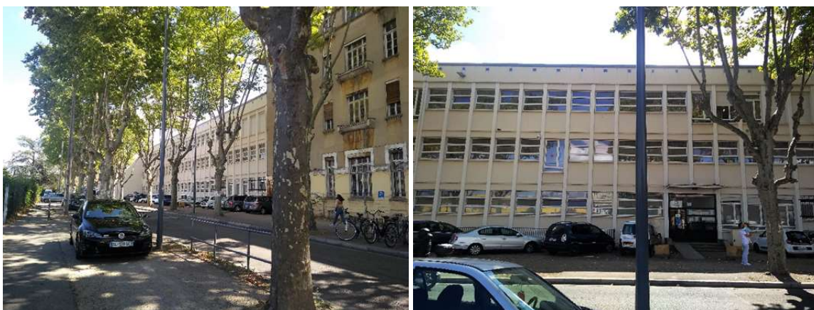
Figuras 26 e 27 - Edifício que acolheu os refugiados deslocados da Selva de Calais. Durante a visita, eu estava hospedando as pessoas em risco e funcionando como sede da ONG Alynea. O edifício será demolido na próxima fase do projeto e as famílias serão realocadas para um edifício de contêiner na mesma área. Fonte: Maíra C. Daitx (fotografias tiradas em setembro de 2020)
