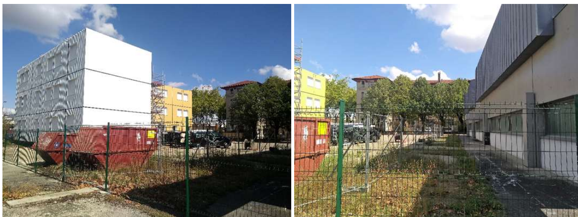
Figuras 31 e 32 - À esquerda está o edifício de contêiner que recebeu as famílias alojadas por Alynea. No momento das fotografias, o espaço estava sendo construído. À direita, o prédio de escritórios que abriga atualmente o CCO e o GIE. O edifício histórico pode ser visto em segundo plano, atrás das árvores. Fonte: Maíra C. Daitx (fotografias tiradas em setembro de 2020)
