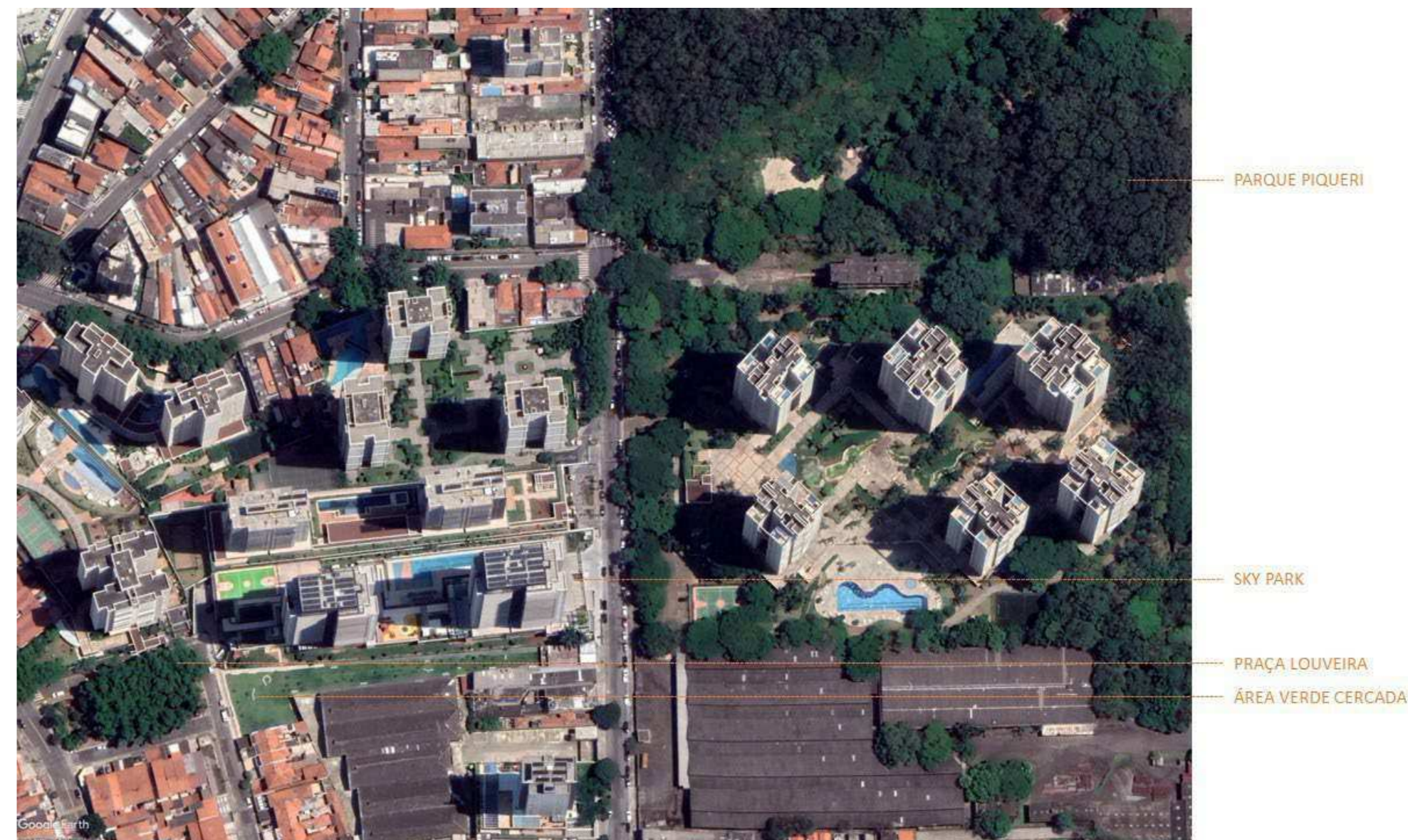
Figura 49: Localização do empreendimento Sky Park Tatuapé em relação ao Parque Piqueri e à Praça Louveira. FONTE: Elaboração própria
