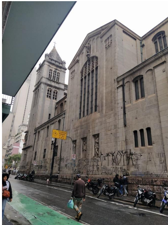
Figura 50: Fachada lateral oeste
