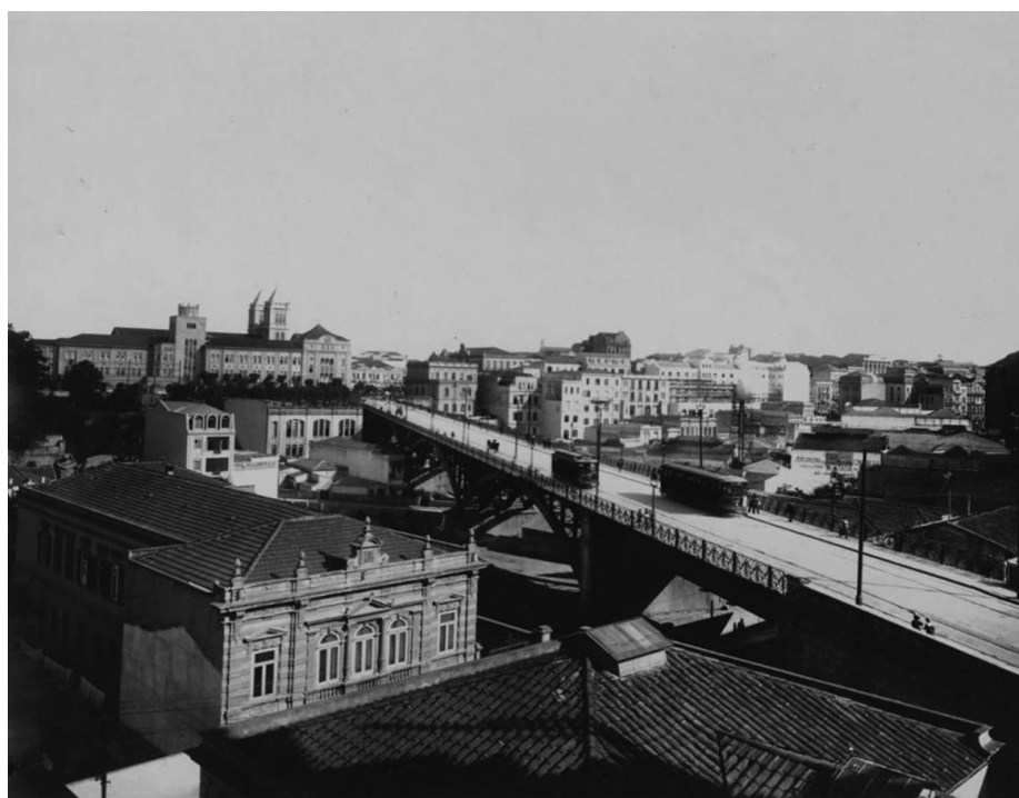
Figura 21: Viaduto Santa Ifigênia
