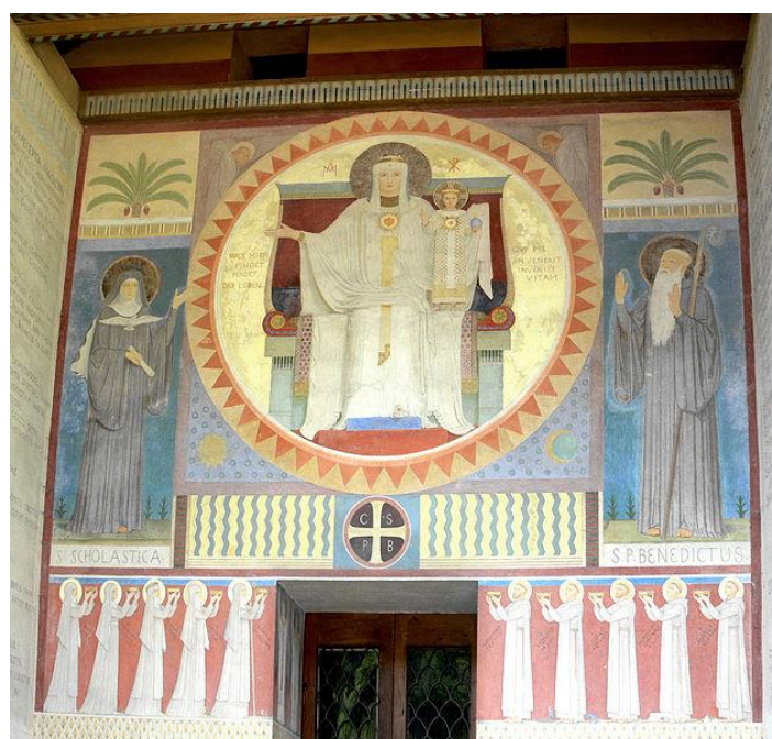
Figura 33: Detalhe da fachada principal da Capela de São Mauro, Baden-Württemberg, Alemanha, 1868-1870.
