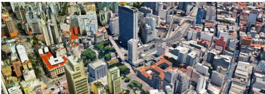
Figura 28: Vista aérea do Viaduto Santa Ifigênia (ao centro) oriundo do site Google Earth.
