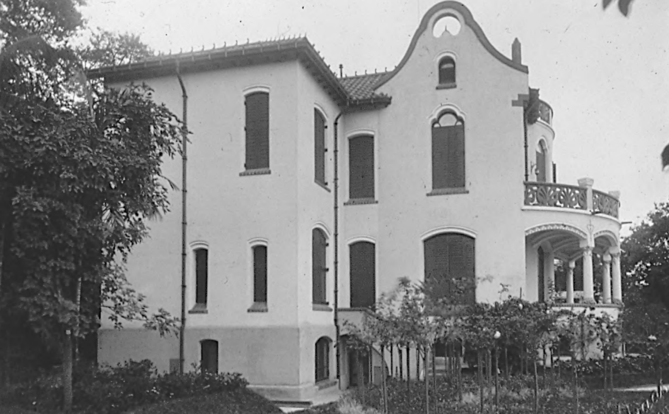
Figura 95: Villa Horácio Sabino (1903), com vista entre a e Avenida Paulista e Rua Padre João Manoel, abaixo, vista da Avenida Paulista. Fonte: Acervo de Ana Carolina Laraya Glueck.
