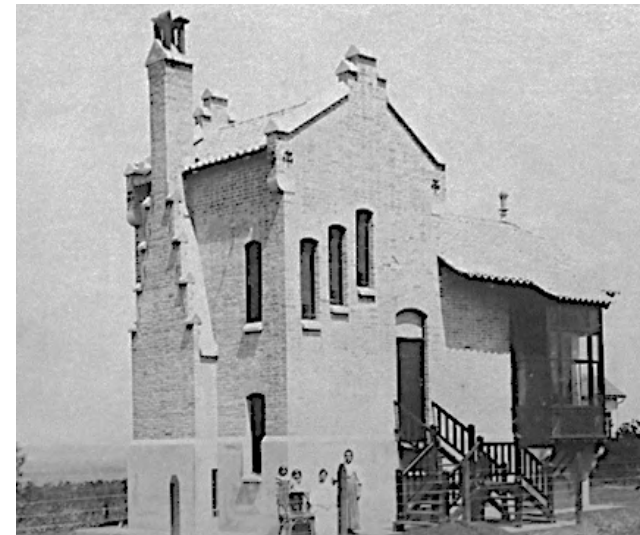
Figura 36: Residência de Victor Dubugras na Alameda Joaquim Eugênio de Lima, nº3. Fonte: Acervo da Biblioteca da FAU-USP.
