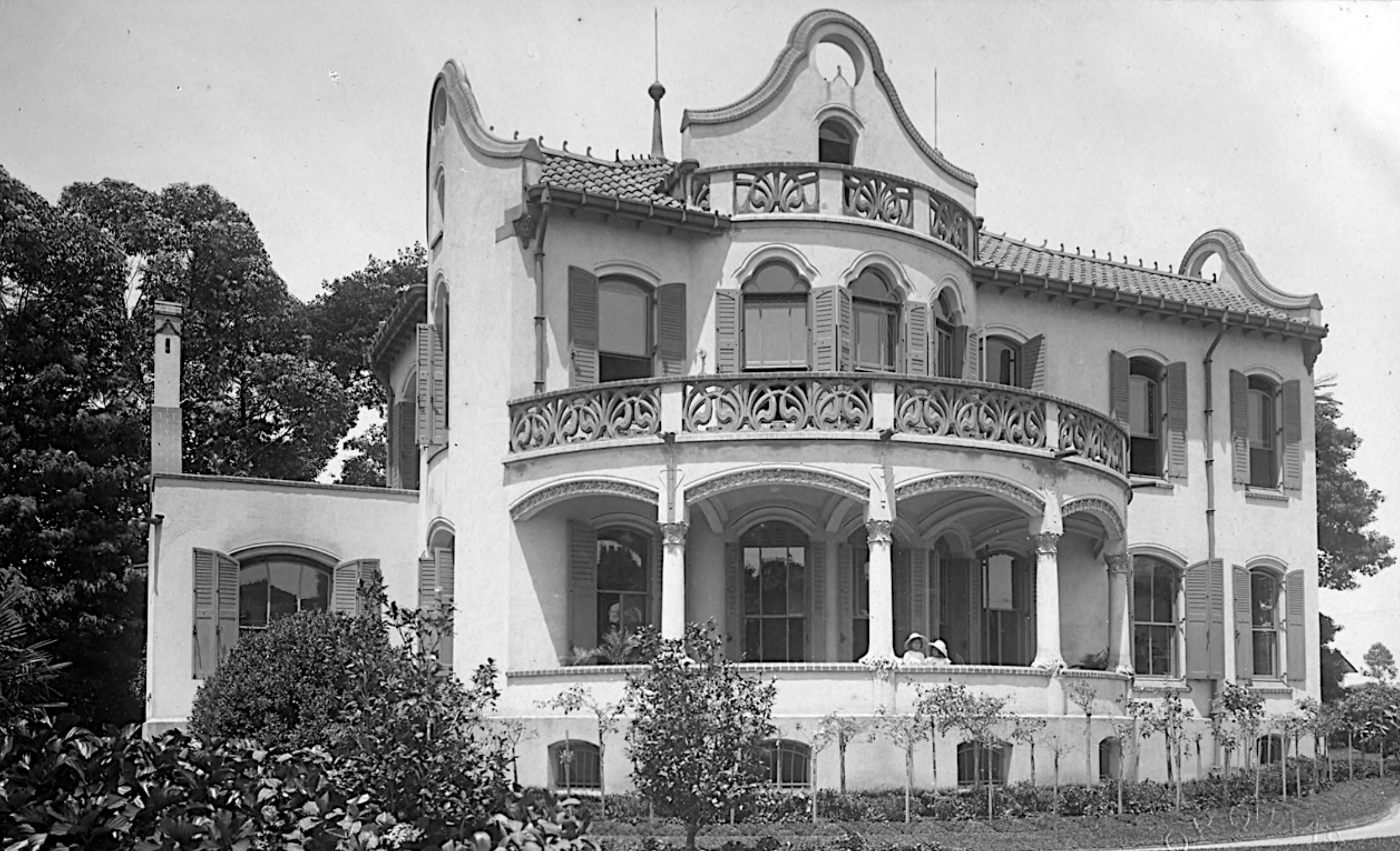
Figura 96: Villa Horácio Sabino (1903), com vista da Avenida Paulista. Fonte: Acervo de Ana Carolina Laraya Glueck.
