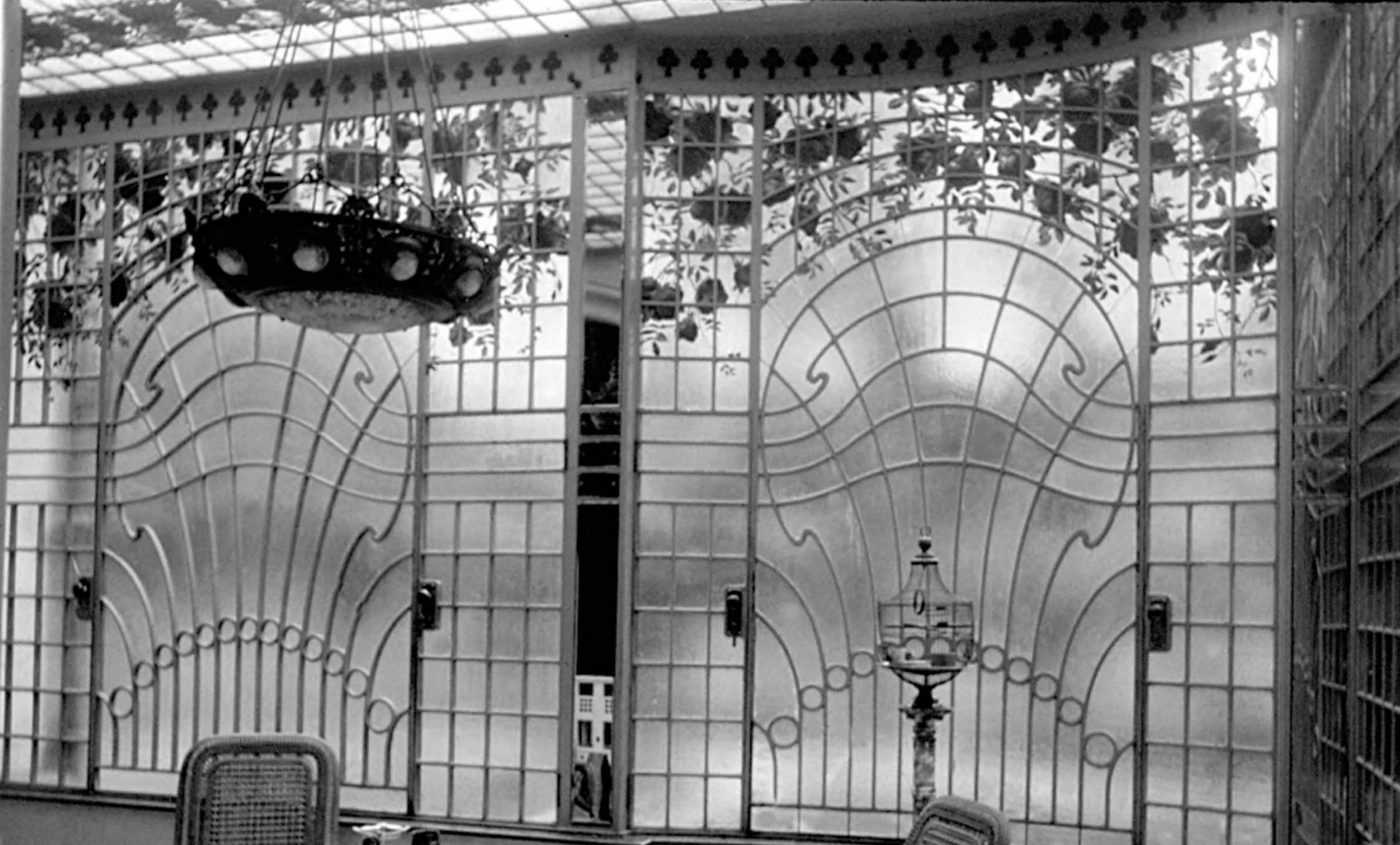
Figura 116: Jardim de inverno. Destaque para a estrutura metálica das paredes e cobertura em composição com vitrais. Fonte: Acervo de Ana Carolina Laraya Glueck
