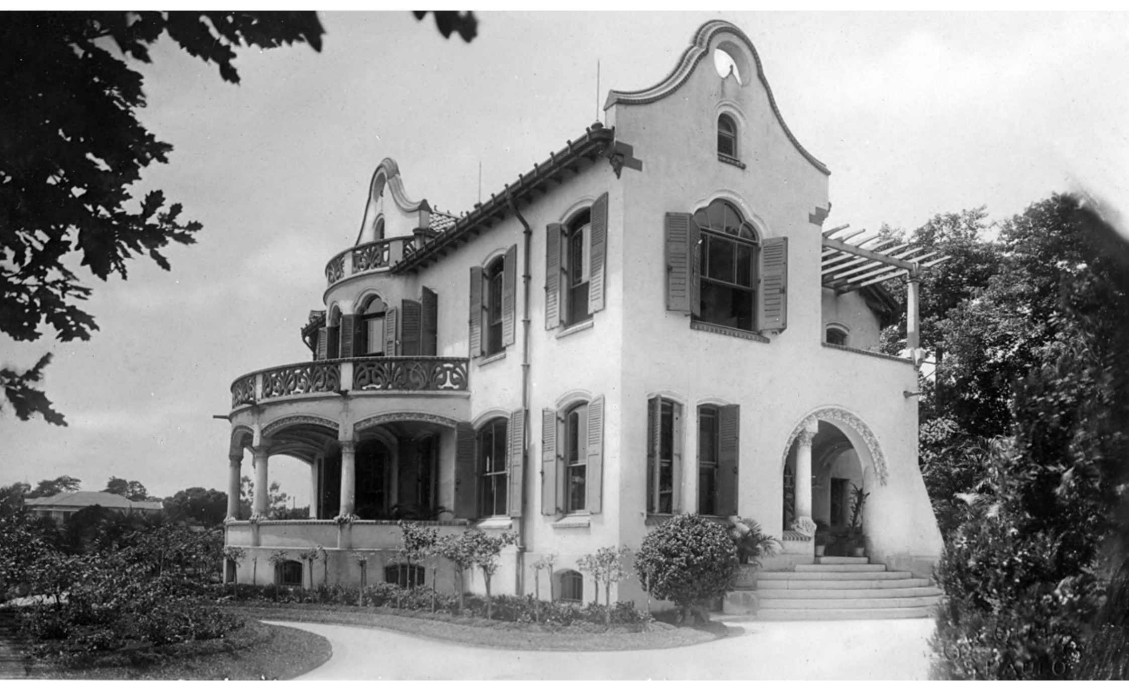
Figura 97: Villa Horácio Sabino, com vista entre a Rua Augusta e a Avenida Paulista. Fonte: Acervo de Ana Carolina Laraya Glueck.
