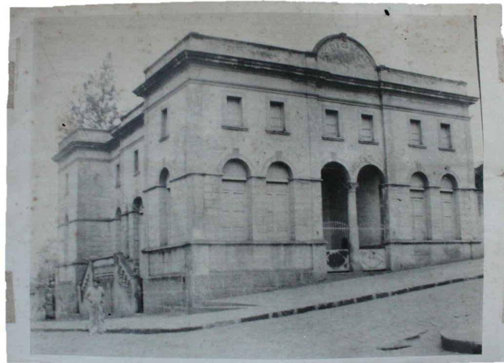
Figura 91. Imagem com descritor 'Assobradado', atribuído à categoria (12) GABARITO DAS EDIFICAÇÕES - CM. Fonte: Museu Histórico Municipal Ruth Bueno Pontes Nigro, s/d, Bocaina-SP.
