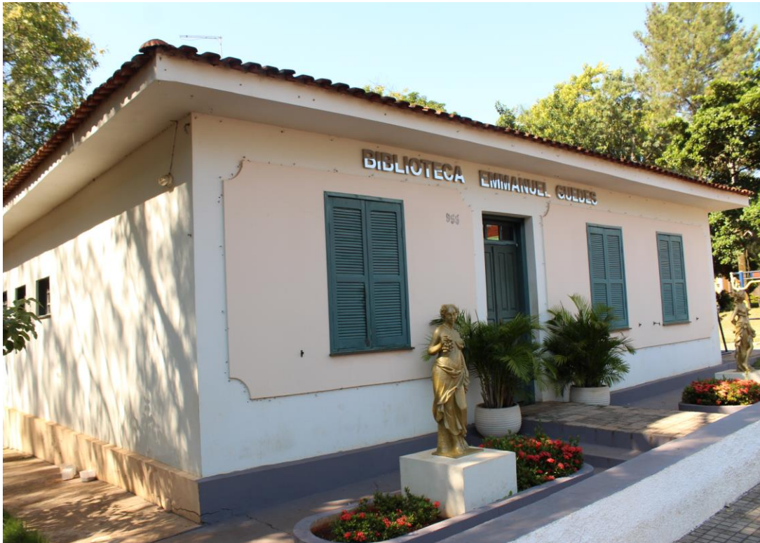
Figura 06. Biblioteca Pública Emanuel Guedes, edifício da antiga casa do construtor da ferrovia de Bocaina-SP. Fonte: Acervo da autora, 2018.
