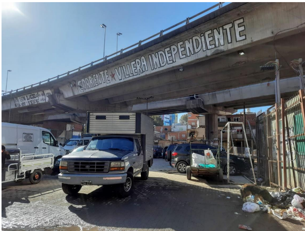
Figura 37: Moradias abaixo da Autopista Illia
