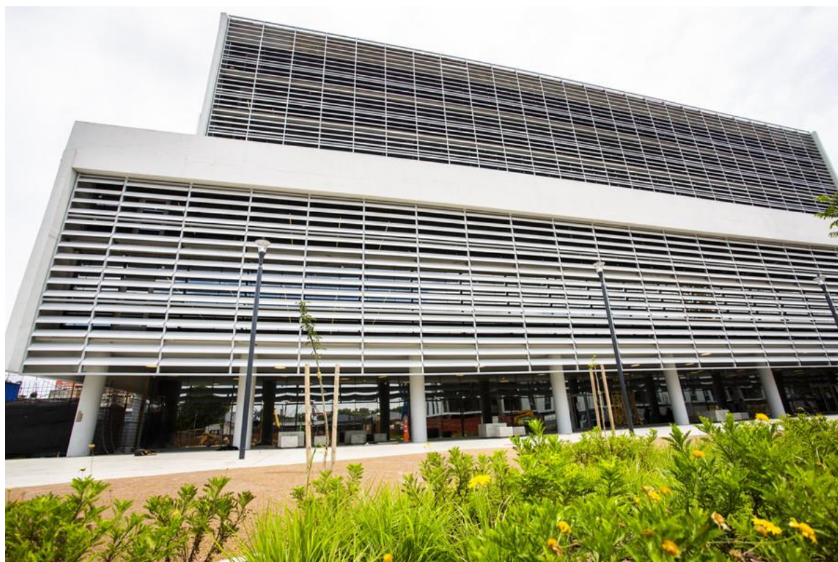
Figura 52: Edifício do Ministério da Educação
