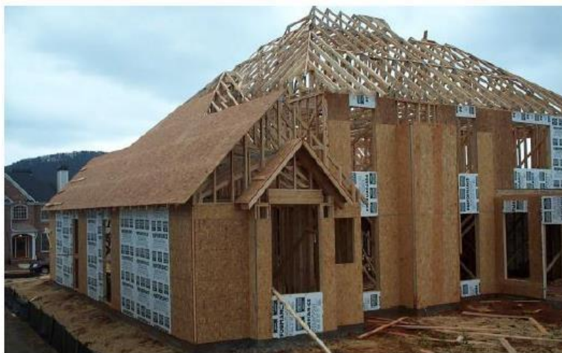
Figura 17: Casa de Wood Frame em cobertura treliçada
