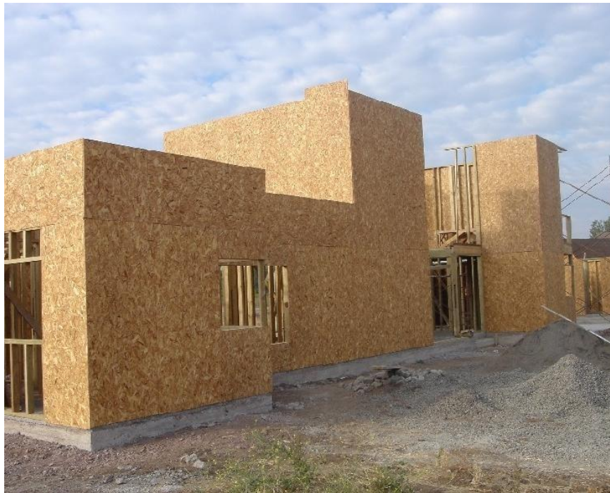
Figura 6: Exemplo de montantes para espaços das janelas
