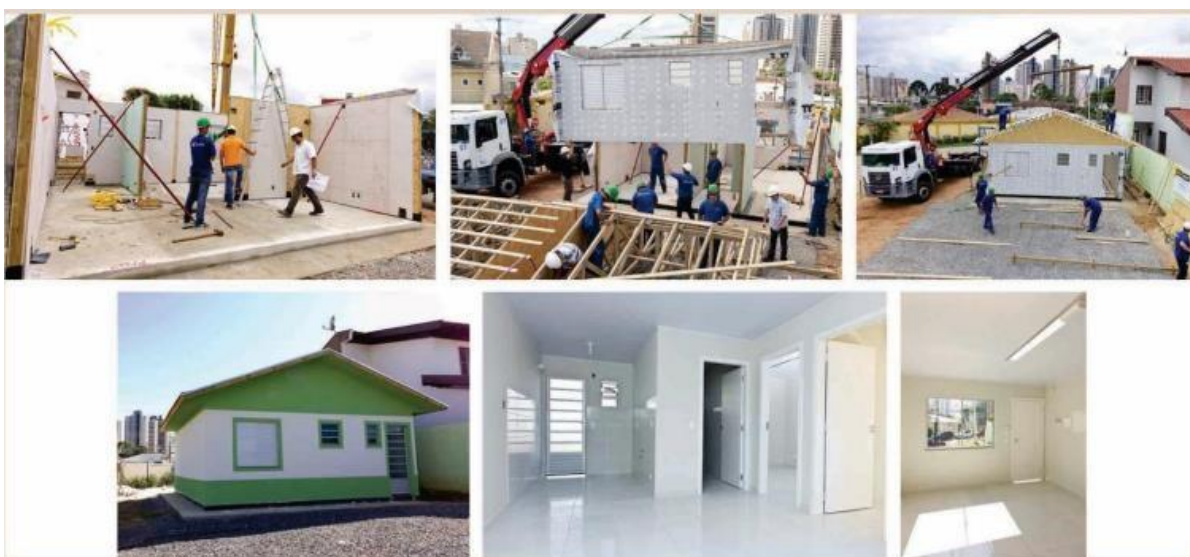
Figura 4: Protótipo construído pela TecVerde em Curitiba
