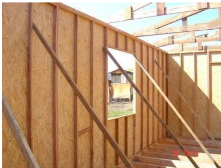
Figura 16: Parede em Wood Frame com contraventamento
