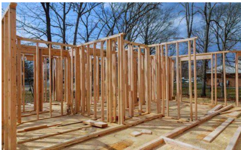
Figura 5: Ossatura das paredes de Wood Frame
