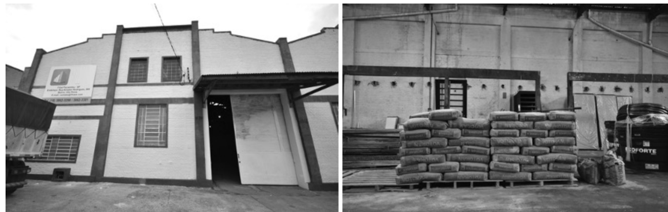
Figura 14. Fachada do galpão; vista interna do galpão da Empresa C com alguns materiais.
