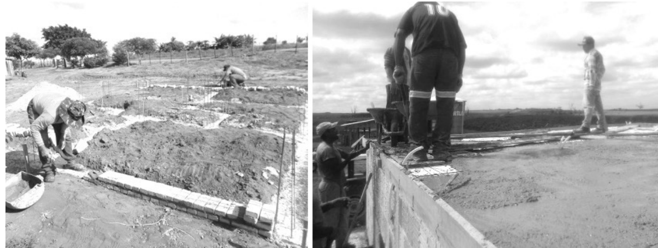
Figura 11. Fundações das casas (estacas cilíndricas e vigas baldrame); laje de concreto.
