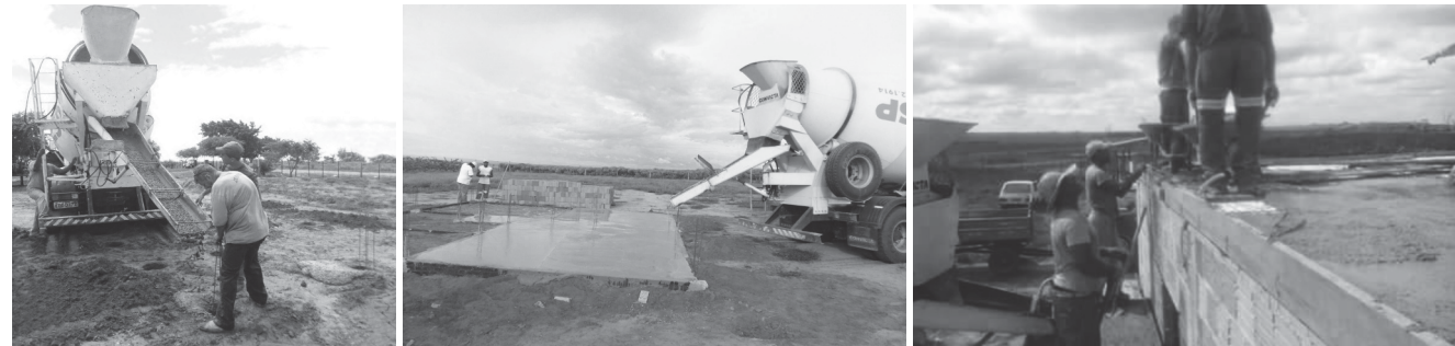
Figura 46. Concretagem das brocas, contrapiso e laje pelos próprios moradores (44 unidades)
