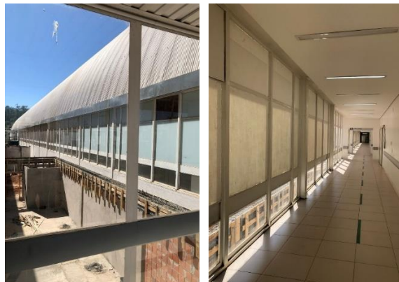
Figura 54: Fachada noroeste do bloco B
