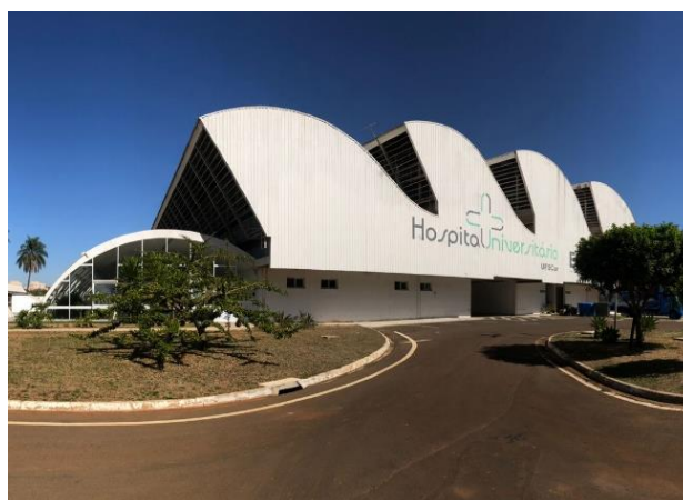
Figura 57: Fachada nordeste bloco B
