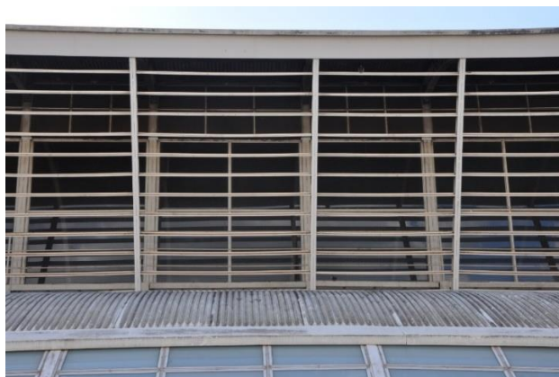
Figura 65: Vedação dos sheds
