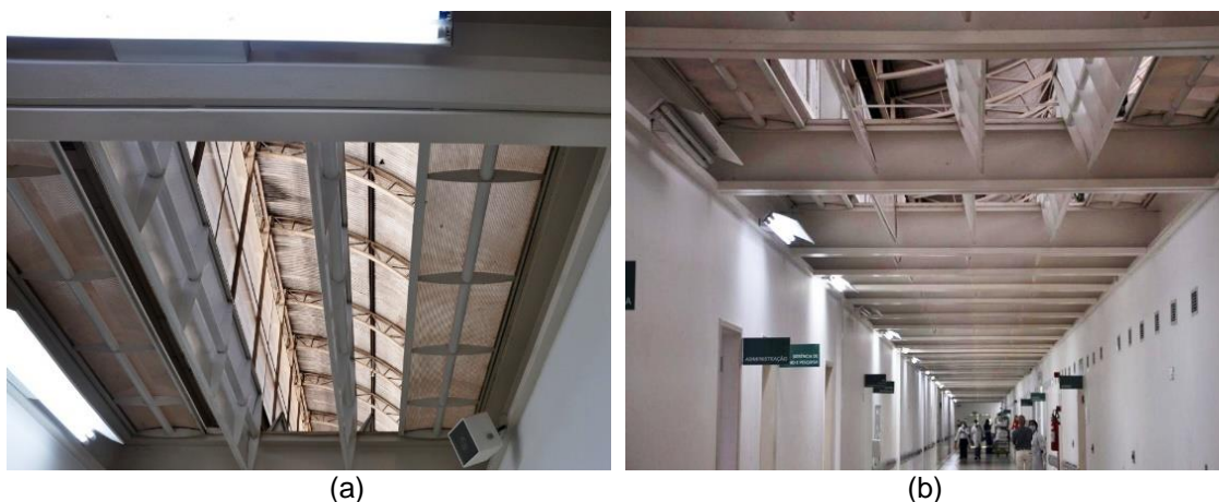
Figura 42: Forros basculantes móveis
