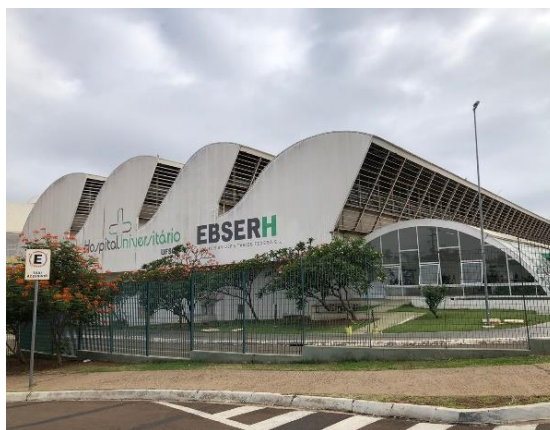
Figura 55: Fachada sudoeste bloco B
