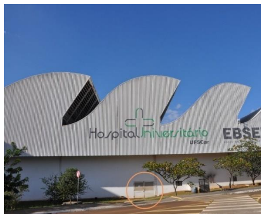
Figura 56: Acesso ao subsolo técnico
