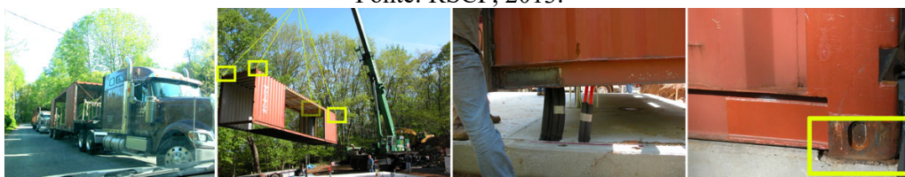
Imagem 2.30 – Transporte, levantamento e locação de contêineres em obra. Fonte: RSCP, 2013.
