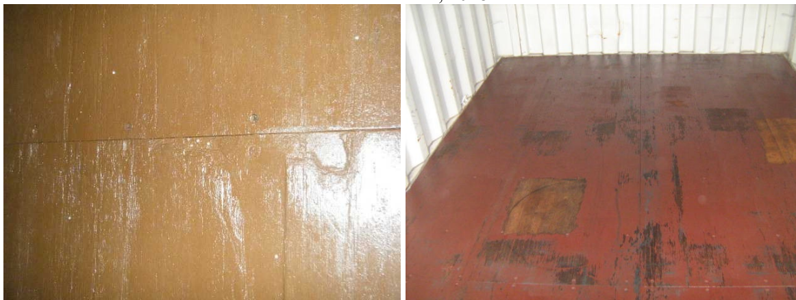
Imagem 2.24 – Parte inferior de piso de contêiner com revestimento de tinta.
