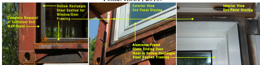
Imagem 2.36 – Exemplo de requadro e janela em contêiner.
