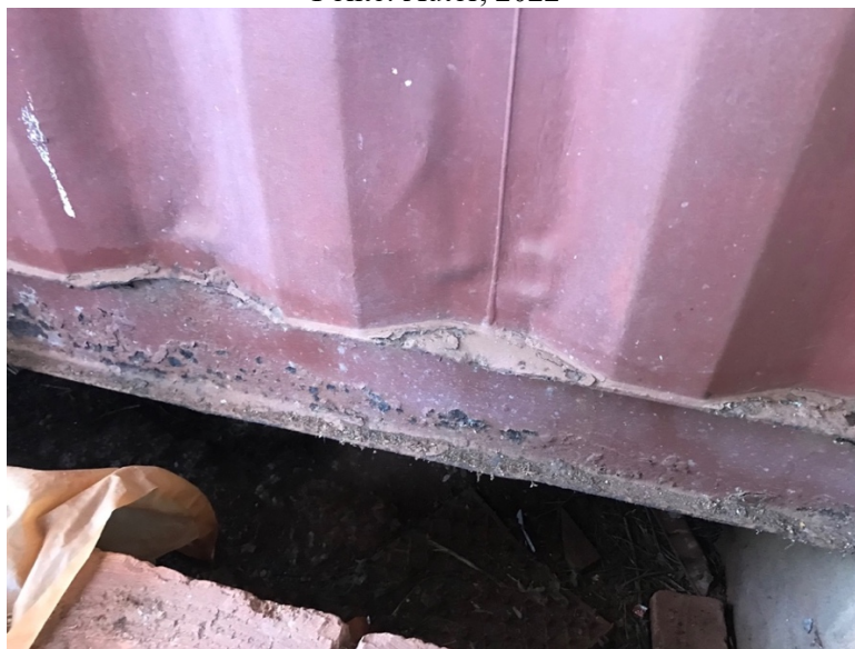
Imagem 6.36 – Corrosão da parte superior da viga inferior do contêiner.
