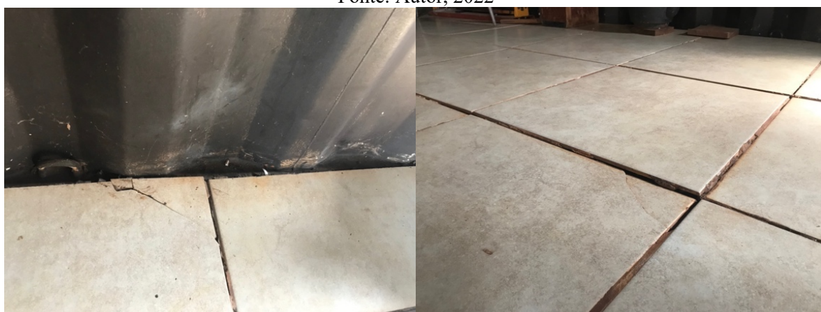
Imagem 6.37 – Deslocamento de cerâmicas do piso.
