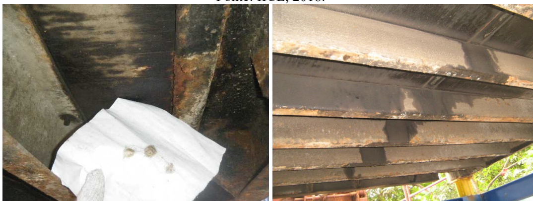
Imagem 2.24 – Parte inferior de piso de contêiner com revestimento de tinta.
