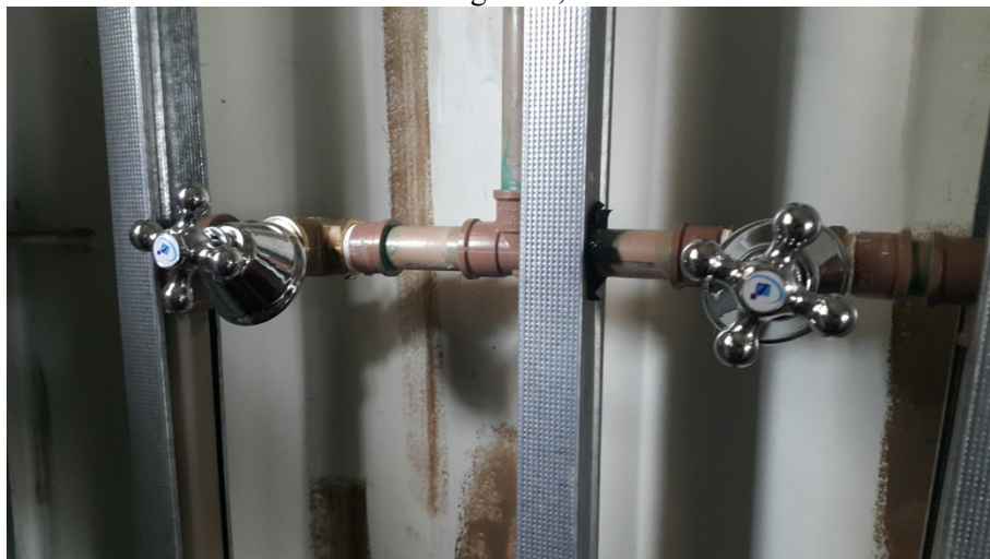
Imagem 2.32 – Instalação de canos de PVC para hidráulica. Fonte: Agnaldo, 2019.
