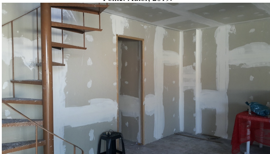
Imagem 2.37 – Revestimento interno em gesso em paredes de contêiner. Fonte: Autor, 2019.
