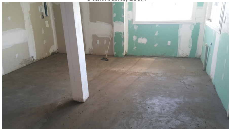
Imagem 2.39 – Regularização de piso em contêiner. Fonte: Autor, 2019.
