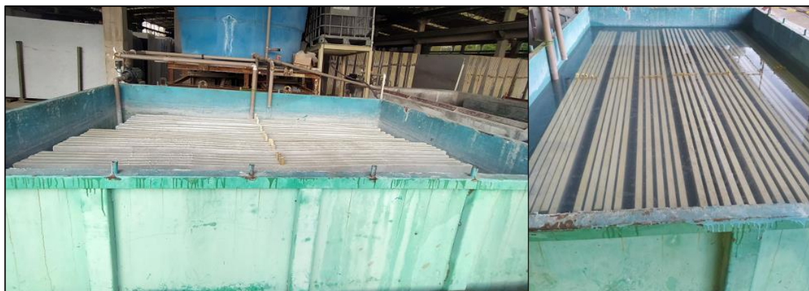
Figura 15 - Tanque de ácido instalado em indústria de beneficiamento para remoção de oxidação de chapas de rochas ornamentais
