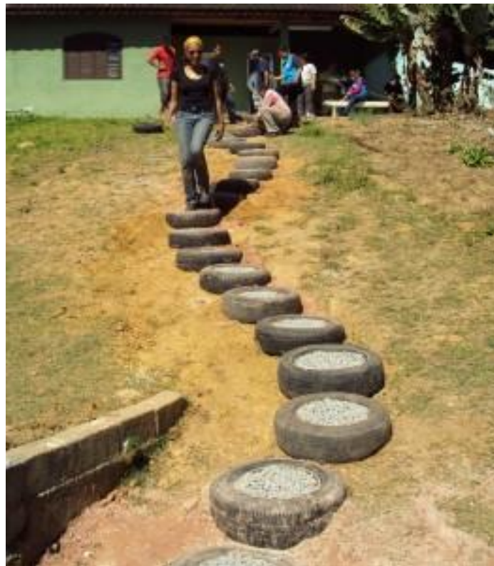
Figura 6 - Construção da escada de pneus UBS Colônia
