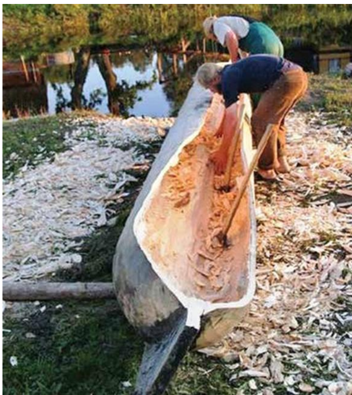
Figura 35 - Feitio da Canoa Caiçara, de um pau só , em Ubatuba
