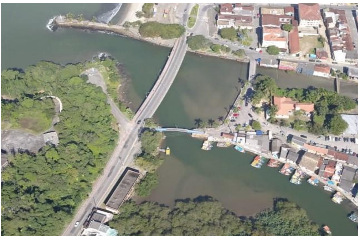
Figura 17 – Ponte nova de Concreto, acesso ao Bairro do Perequê Açú
