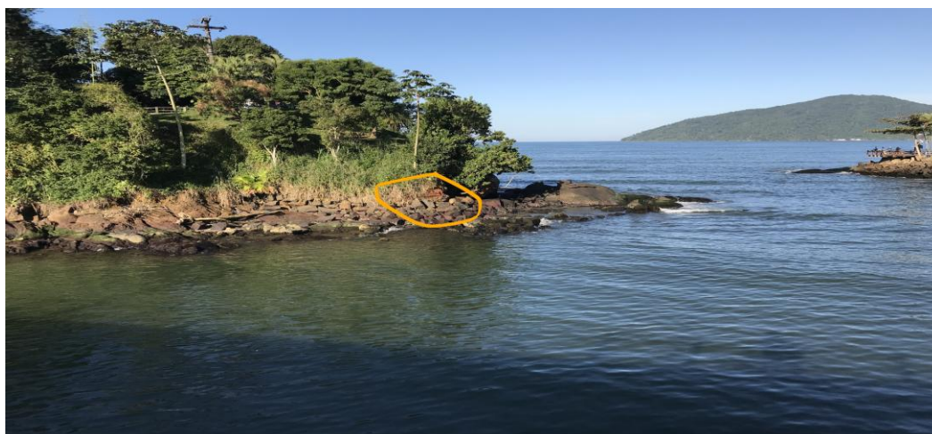
Figura 18 – Vestígio da Ponte do século 19
