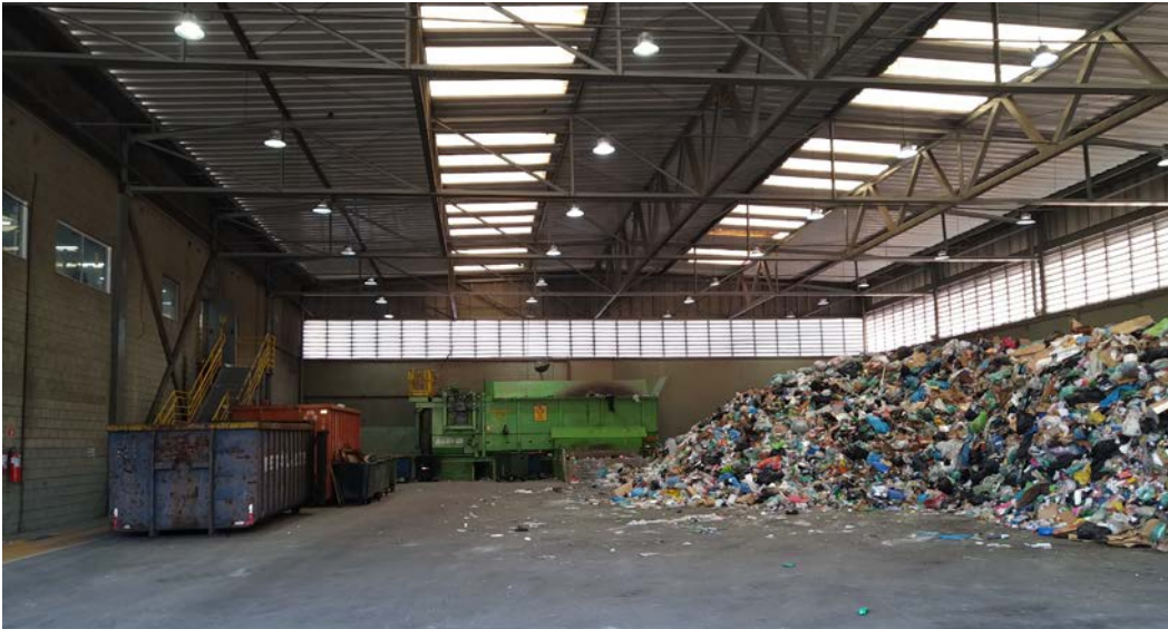
FOTO 1 - Pátio de recepção dos materiais e rasga sacos
