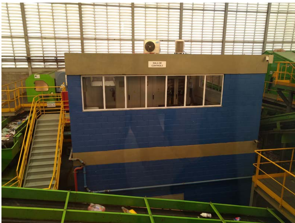
FOTO 5 - Sala de controle
