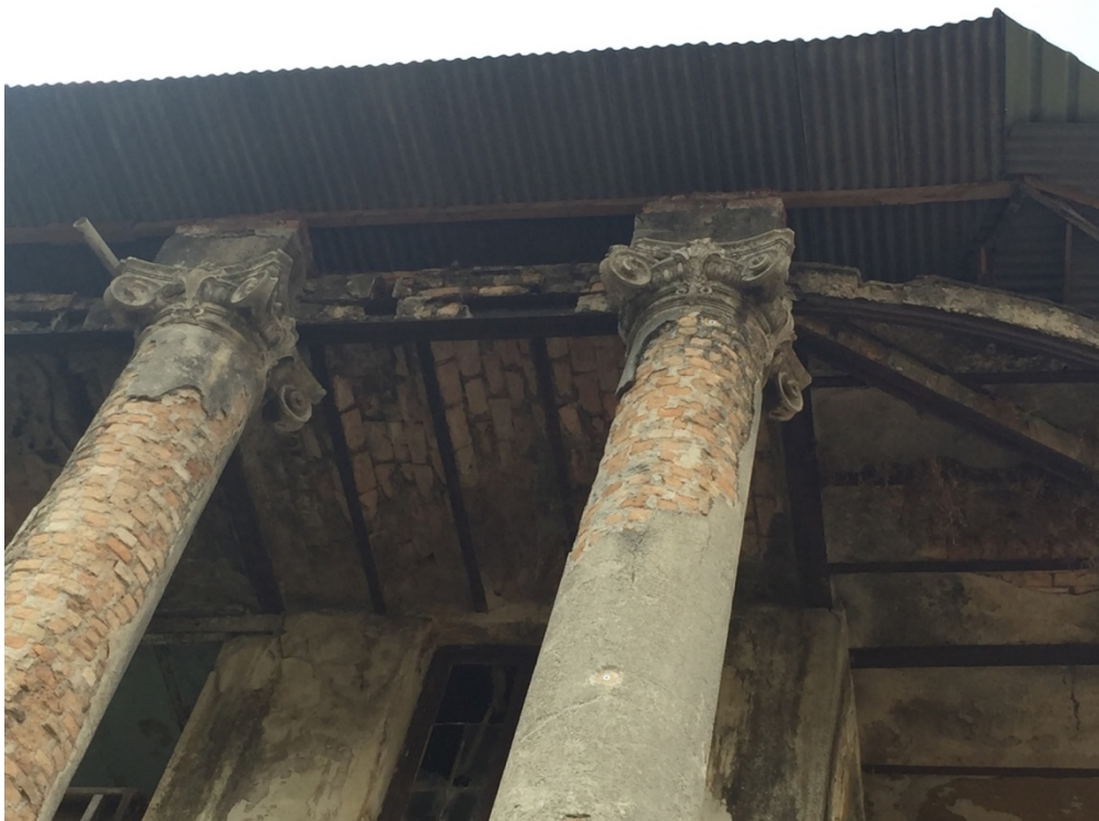
Figura 14 — Trilhos de trem utilizados na construção
