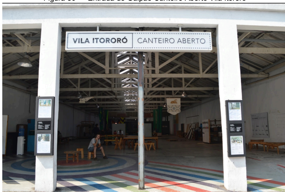
Figura 30 — Entrada do Galpão Canteiro Aberto Vila Itororó
