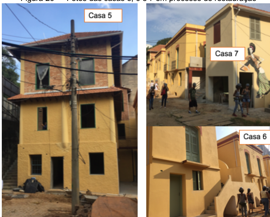
Figura 26 — Fotos das casas 5, 6 e 7 em processo de restauração
