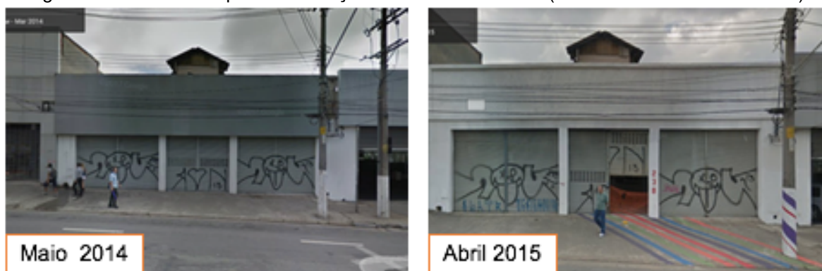
Figura 23 — Antes e depois do começo do Canteiro de Obras (maio de 2014 e abril de 2015)
