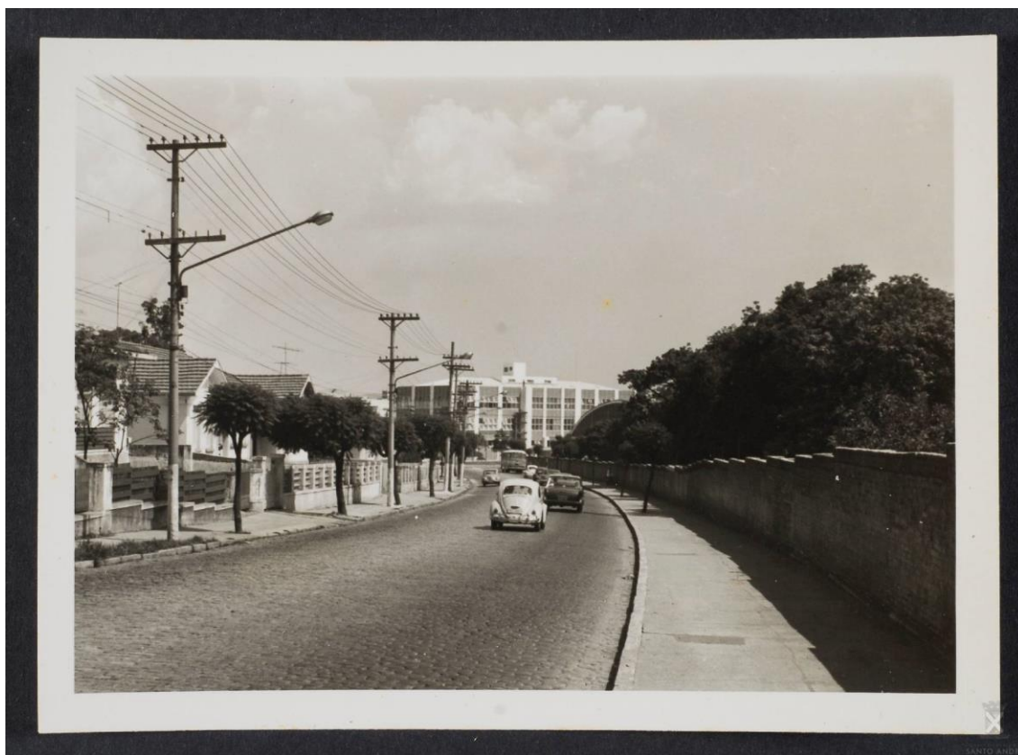
Figura 11 – Ao fundo, a Fábrica de Elevadores Otis, Santo André, 1971
