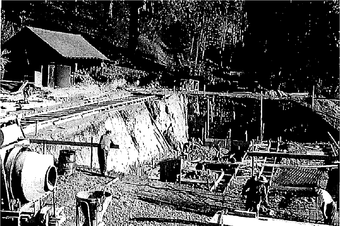
Figura 5. Imagem da construção do bunker financiado pela NASA para os experimentos de J.Aschoff
