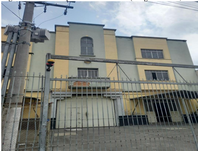
Figura 100 - Edificação não identificada (antigo Presídio, Brás)
