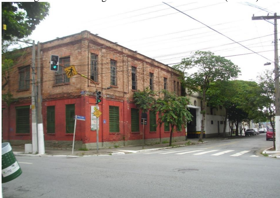
Figura 130 – “Antigas Oficinas Casa Vanorden”. (Mooça)
