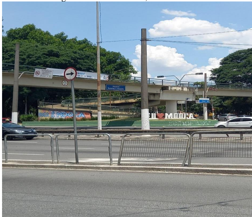
Figura 43 - Radial Leste, sentido bairro
