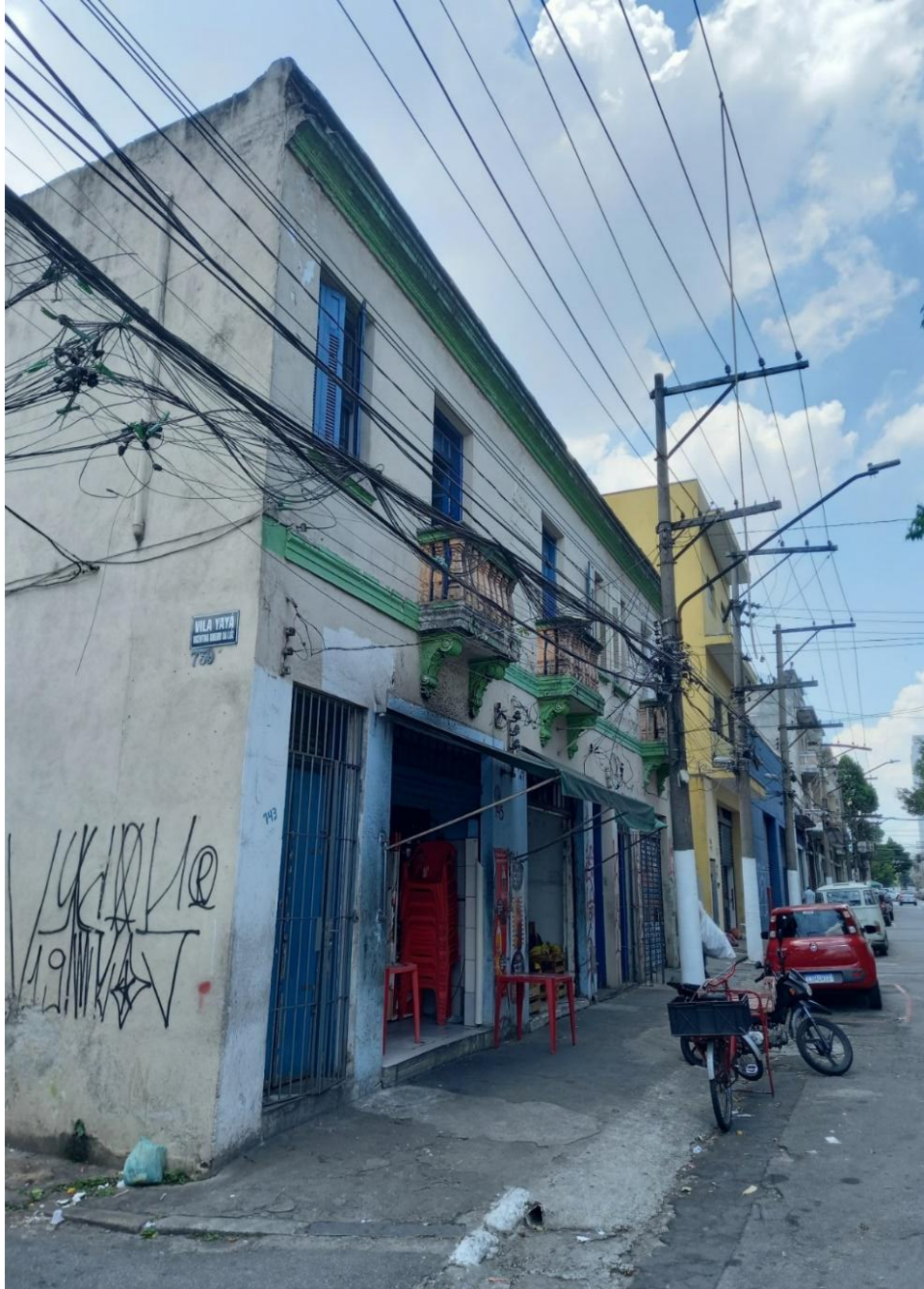
Figura 38- Fachada lateral da entrada da Vila Yará
