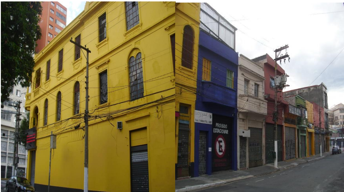
Figura 6 e 7 - Edificações rua Oiapoque (imagem 1), x rua Rangel Pestana (imagem 2)
