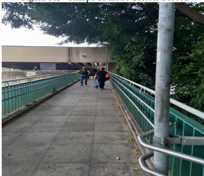
Figura 105 - Rampa do metrô Bresser-Mooca
