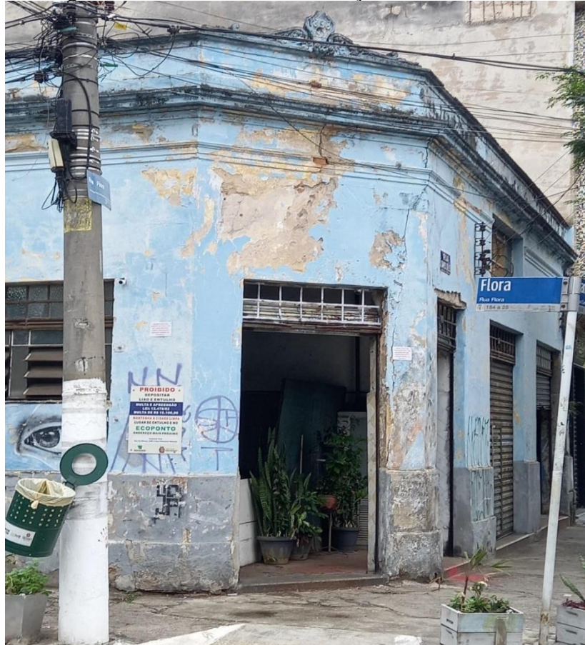
Figura 31 - Referência da Edificação nos anos de 1898
