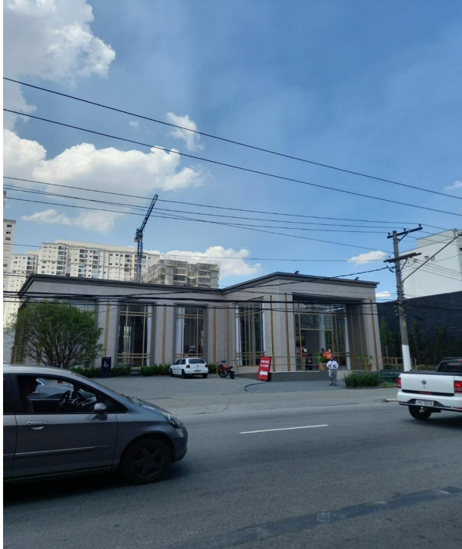
Figura 40 - Construção na Rua Piratininga
