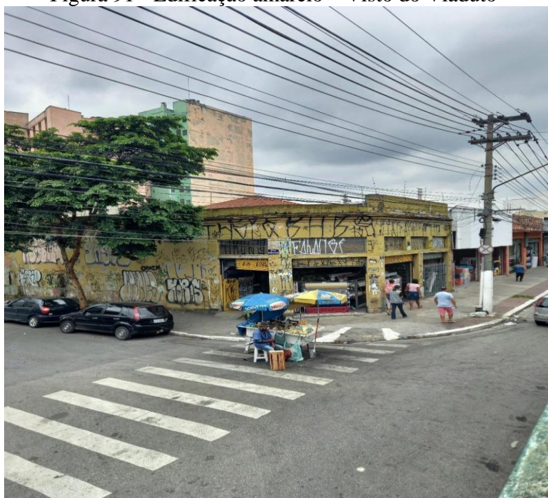
Figura 91 - Edificação amarelo – Visto do Viaduto
