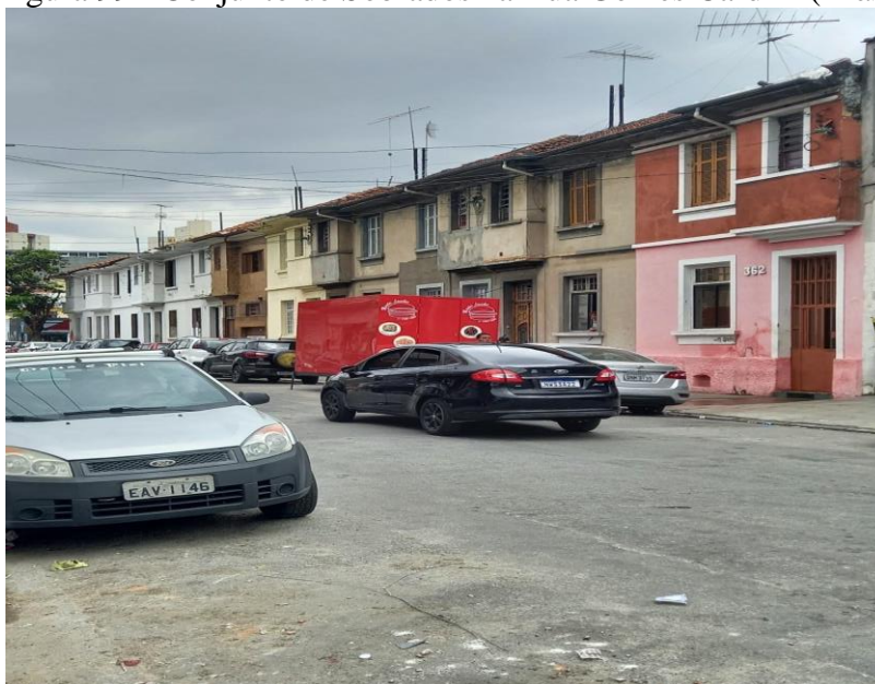
Figura 99 - Conjunto de Sobrados na Rua Gomes Cardim (Brás)
