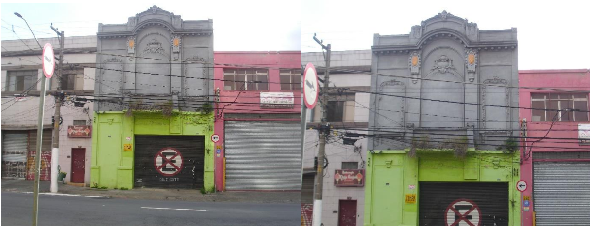
Figura 4 e 5 - Imóvel antigo na Rua Piratininga,228
