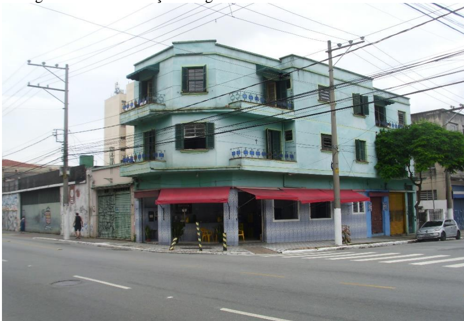
Figura 122 – Construção antiga Rua da Mooca x rua Dona Ana Neri
