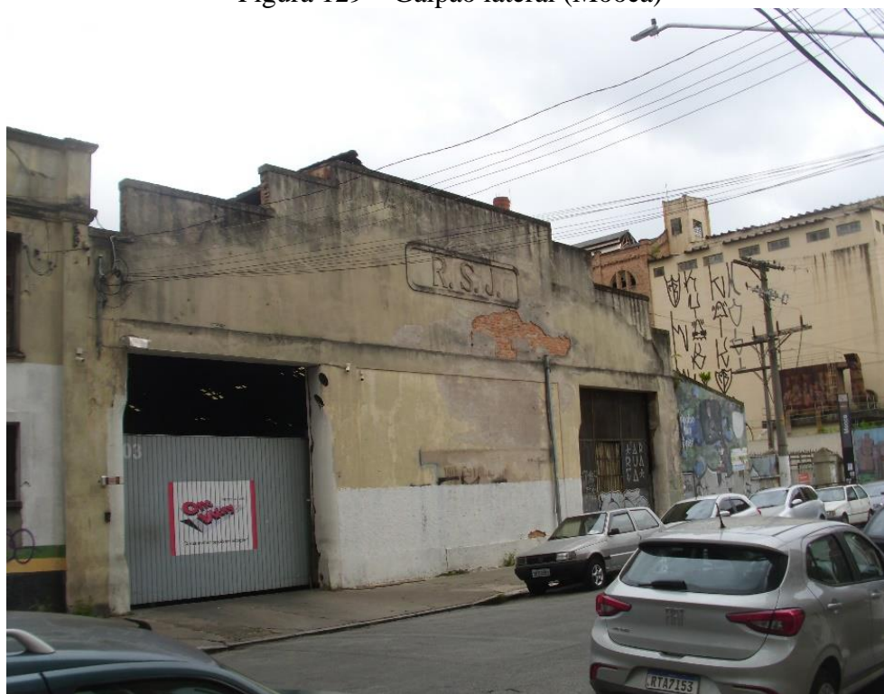
Figura 129 – Galpão lateral (Mooca)
