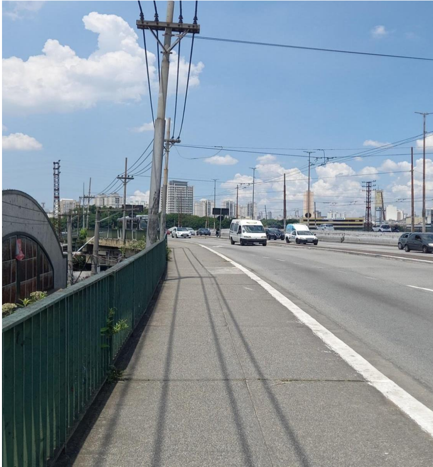
Figura 41 - Viaduto Alcântara Machado
