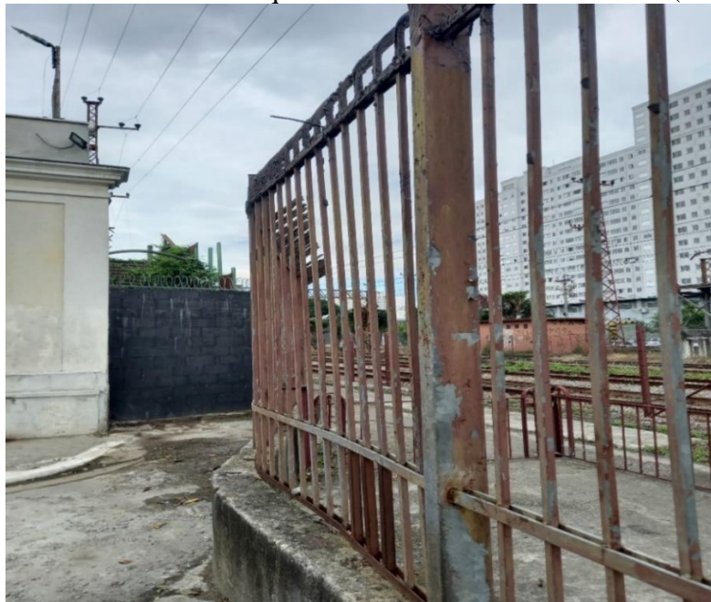
Figura 109 - Passarela Bloqueada Rua Visconde de Parnaíba (Mooca)
