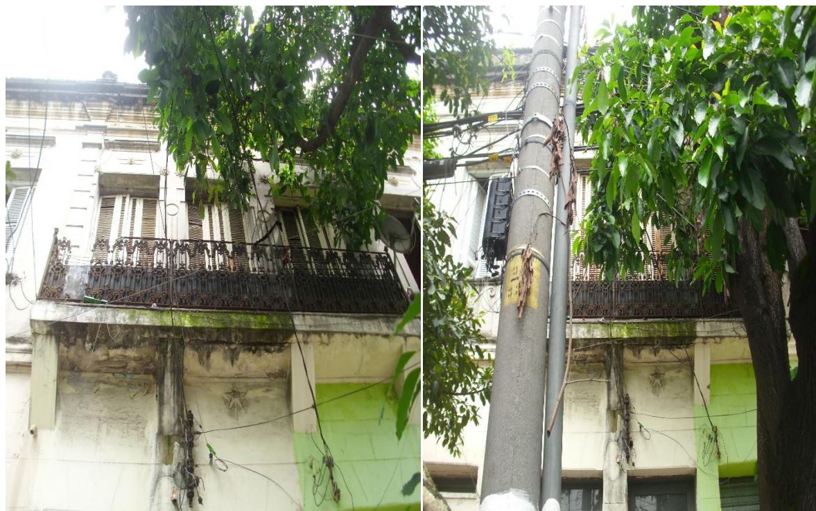
Figura 120 e 121 – Edificação na Rua Piratininga, 1032
