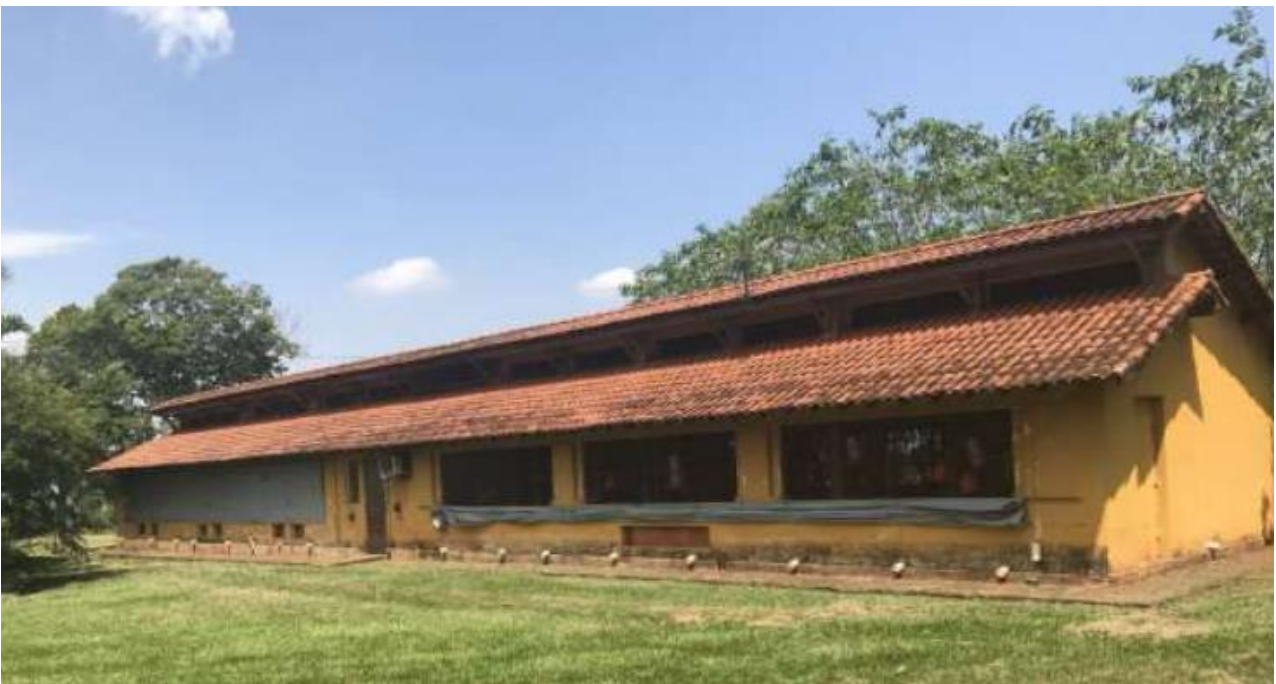
Figura 3. Vista externa do galpão experimental
