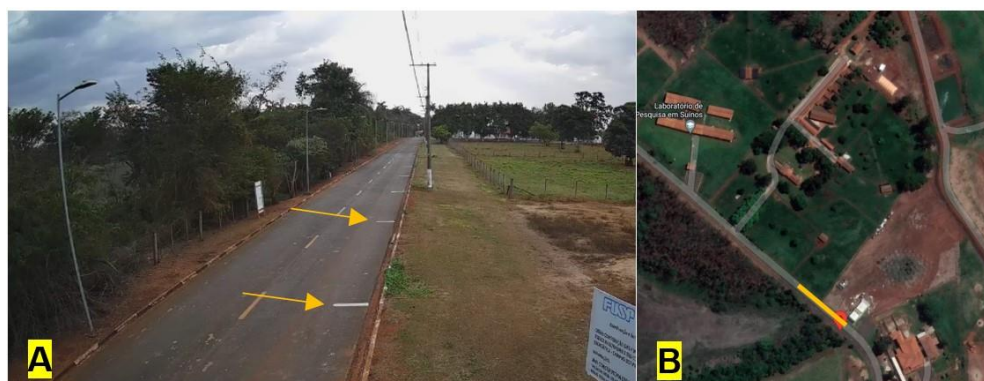
Figura 14 - Via pavimentada utilizada para os testes de detecção.
