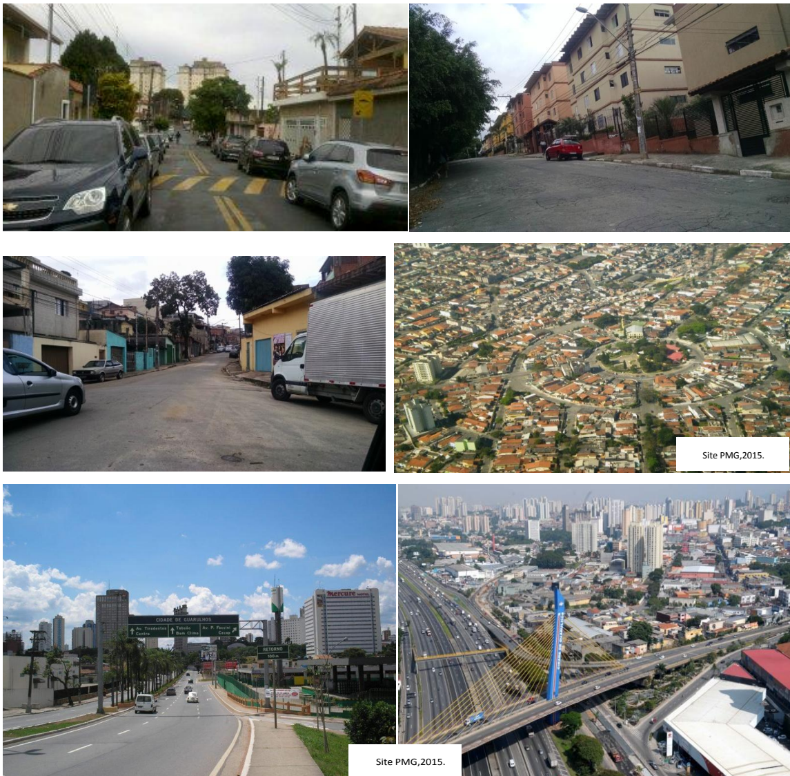
Conjunto de Fotos 4: Região central - São Ricardo, Ponte Grande, Gopoúva, Vila Galvão, entrada da cidade (via Dutra) e Ponte estaiada na Rod.Pres.Dutra.
