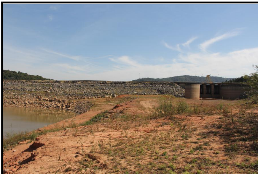
Figura 14 – Saída da Barragem do Rio Jaguari no período de estiagem (maio 2014)
