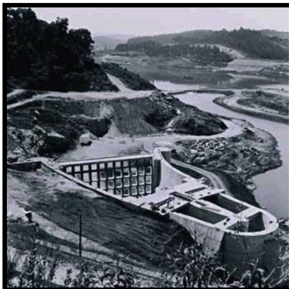
Figura 5 – Construção do Reservatório do Rio Juquery (ou Paiva Castro)
