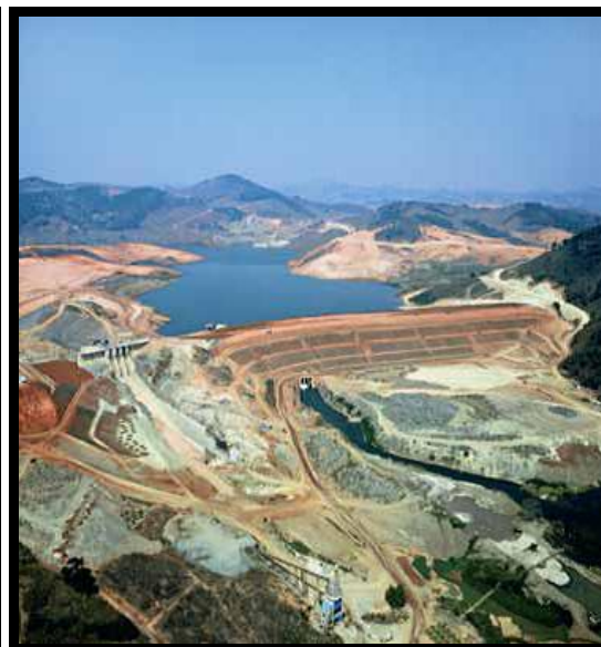
Figura 6 – Construção do Reservatório do Rio Jaguari
