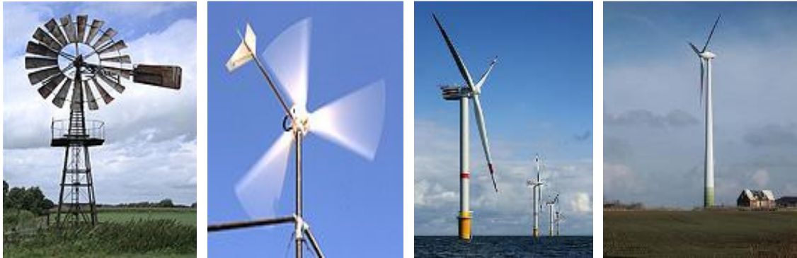
Figura 8 – Aerogeradores de Eixo Horizontal Fonte: Relatório do Centro Brasileiro de Energia Eólica – 2008
