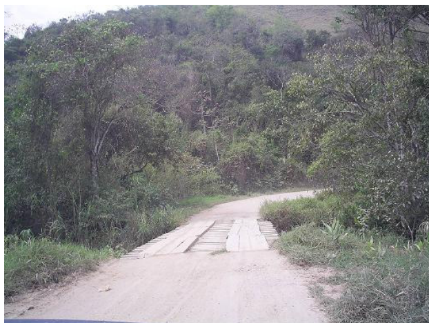
Ilustração 6.7. - Ponte de madeira sobre o rio Mato Preto, afluente do Ribeira
