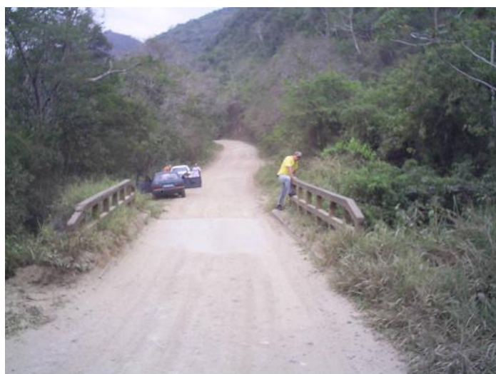
Ilustração 6.3. - Ponte de alvenaria sobre o rio Bom Sucesso, afluente do Ribeira
