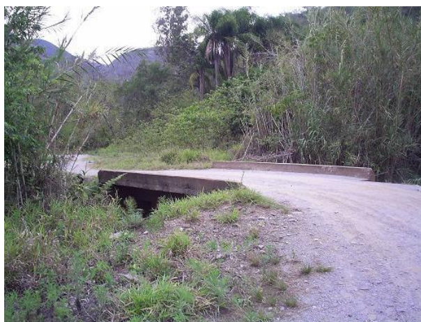
Ilustração 6.8. - Ponte de alvenaria sobre o rio do Rocha – acesso para posto de saúde e telefone público e residências
