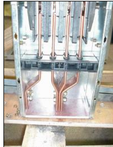
Fotografia 7 - Vista parcial da montagem de ensaio (lado do fechamento das três fases)
